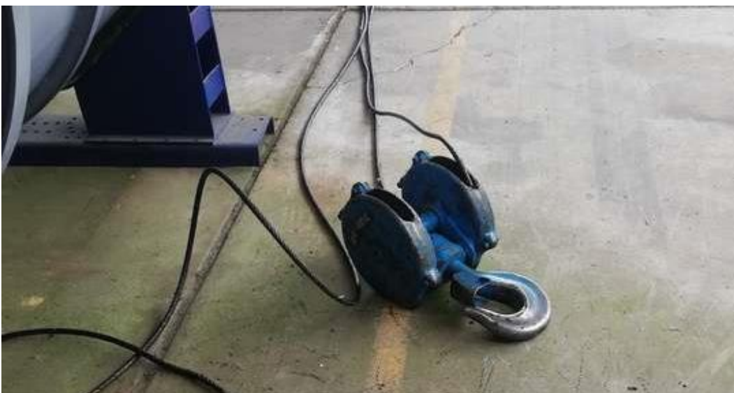
Figura 41. Desmontaje de cable de puente grúa número 2.
