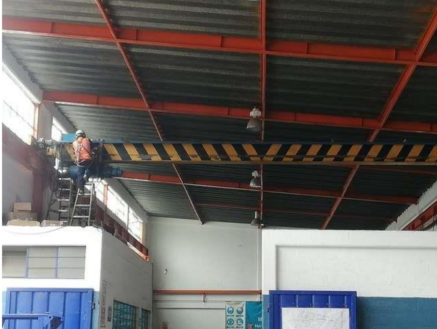
Figura 34. Reparación de puente grúa número 1.
