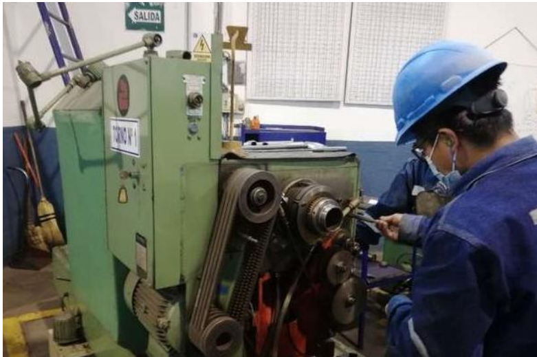
Figura 43. Cambio de fajas del torno número 1.
