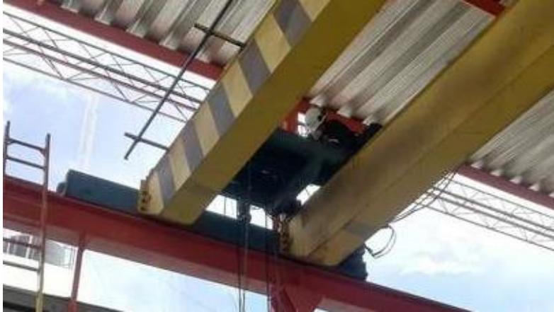
Figura 42. Reparación de sistema eléctrico de puente grúa número 2.
