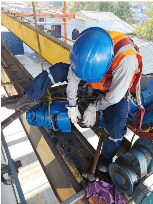
Figura 39. Desmontaje de freno roto de puente grúa número 2.
