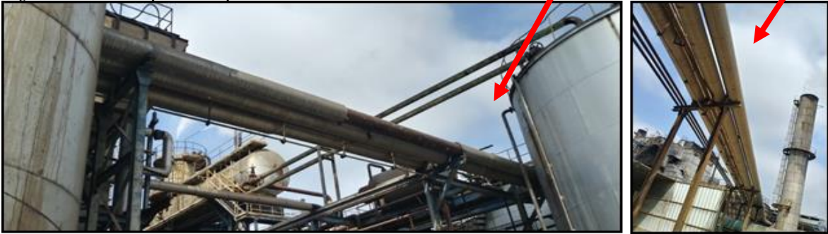
Figura 22. Tubería para reemplazo – Frente a chimenea Caldero 20.
