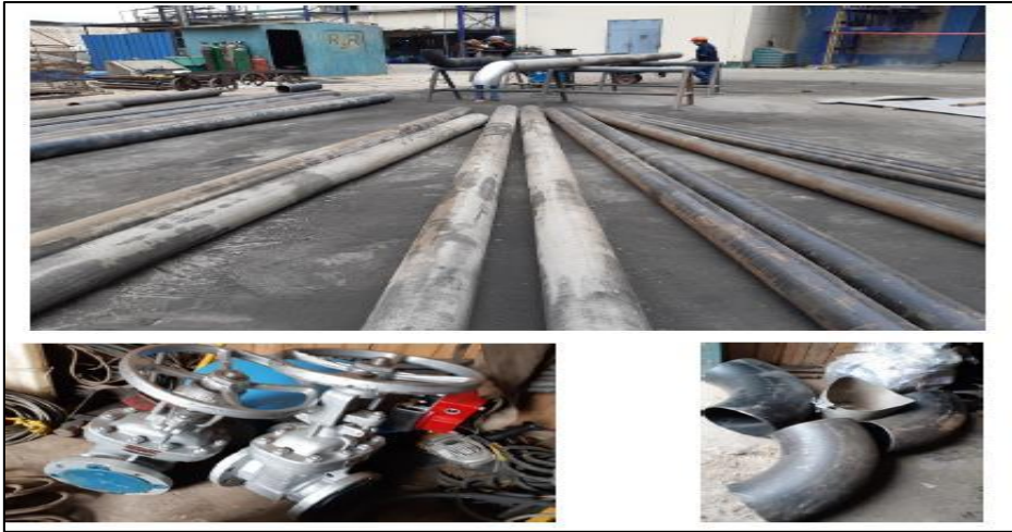
Figura 28. Habilitado de material para instalación de sistema.
