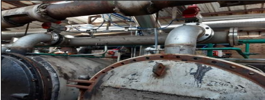
Figura 29. Habilitado de material para instalación de sistema.
