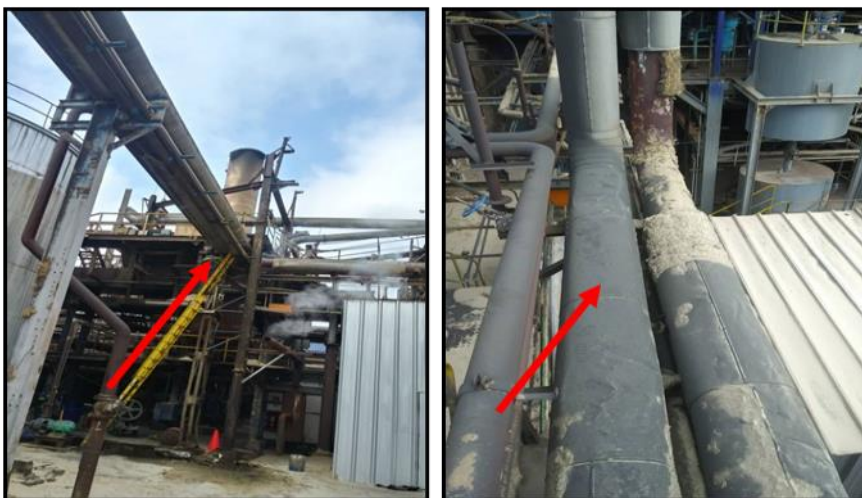
Figura 21. Tubería para reemplazo – Planta de fuerza
