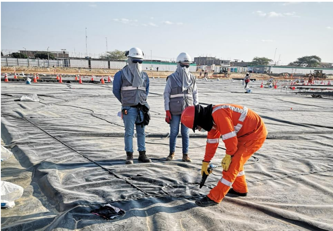
Figura 15. Ensayos de Spark test a la geomebrana Fuente: Propia (2022)
