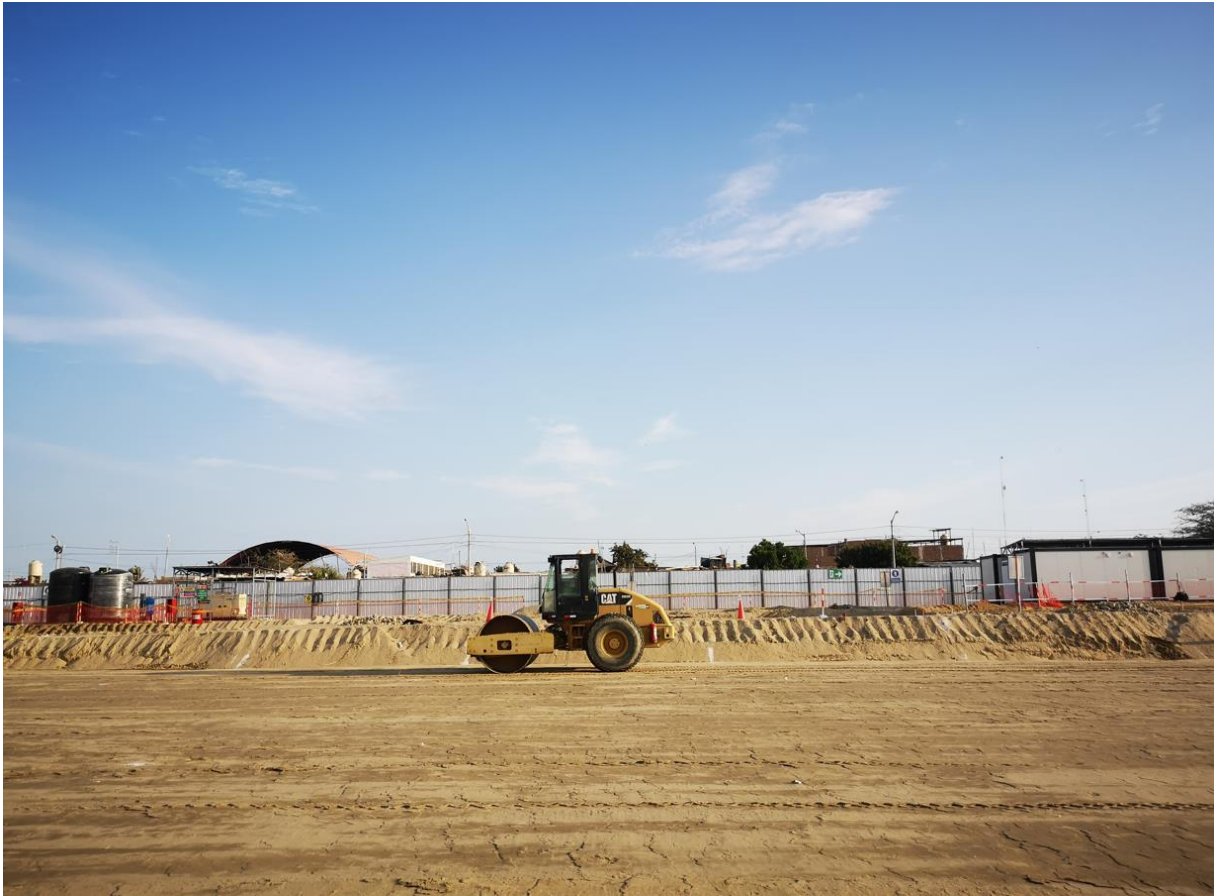
Figura 11. Superficie nivelada y compactada. Fuente: Propia (2022).
