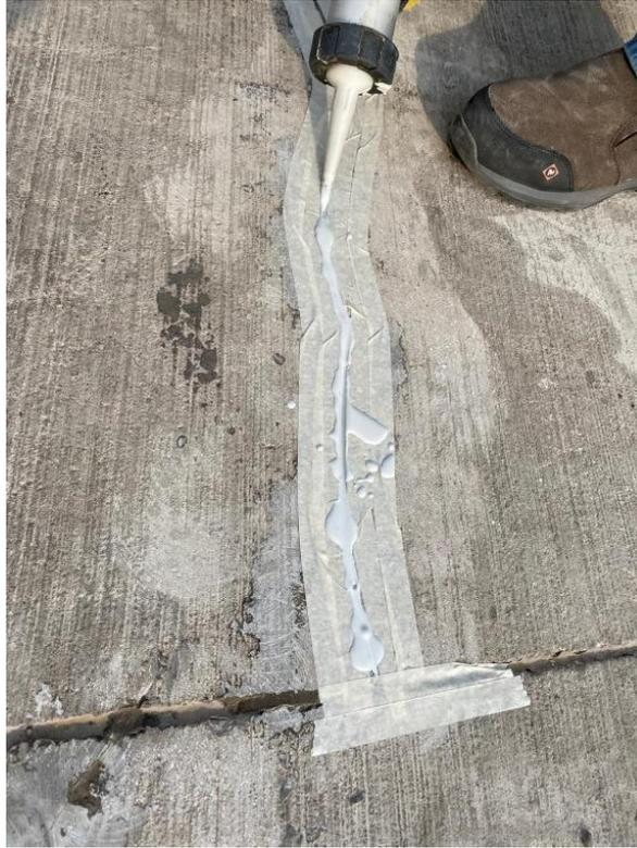
*Ilustración 44 Colocación del material por gravedad. Fuente propia.*
