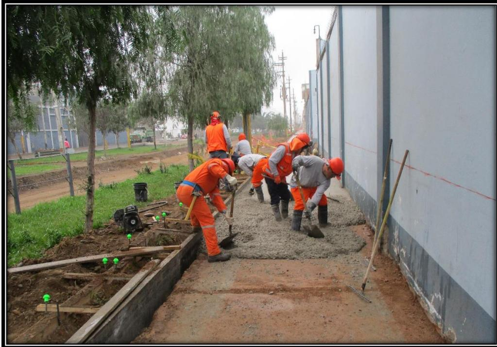
*Ilustración 20 Ejecución de veredas de concreto. Fuente propia*
