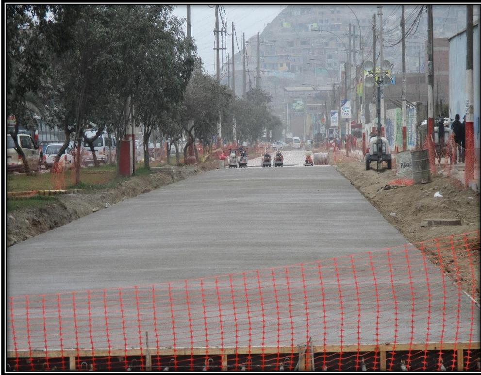
*Ilustración 33 Vaciado de concreto para pavimento rígido. Concluido. Fuente propia.*
