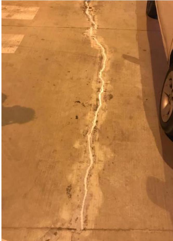
*Ilustración 46 Reparación de fisuras en pavimento rígido. Fuente propia*
