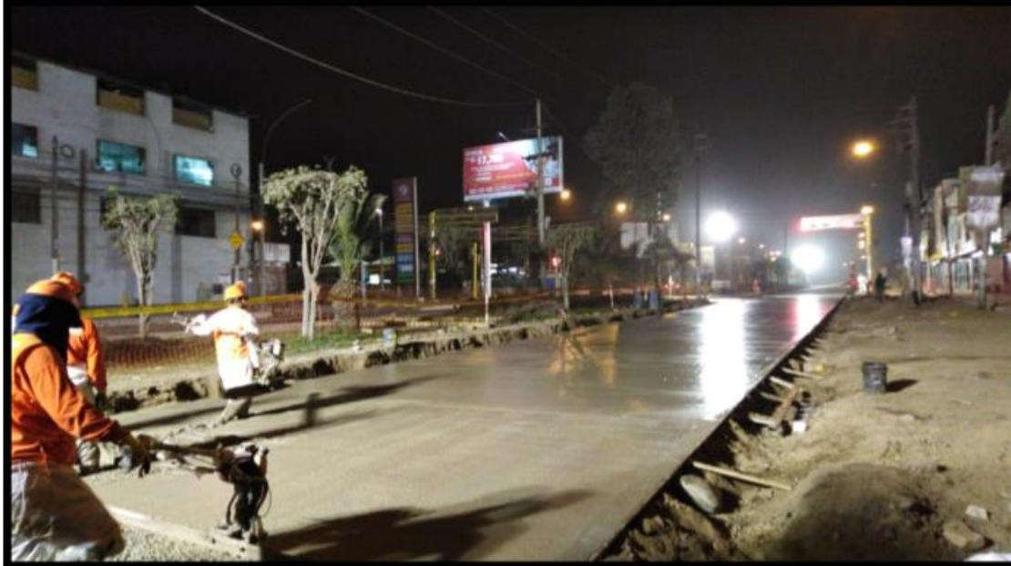
*Ilustración 31 Procedimiento de vaciado de concreto. Fuente propia*
