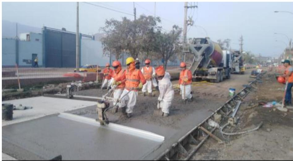
*Ilustración 32 Procedimiento de vaciado de concreto. Fuente propia*
