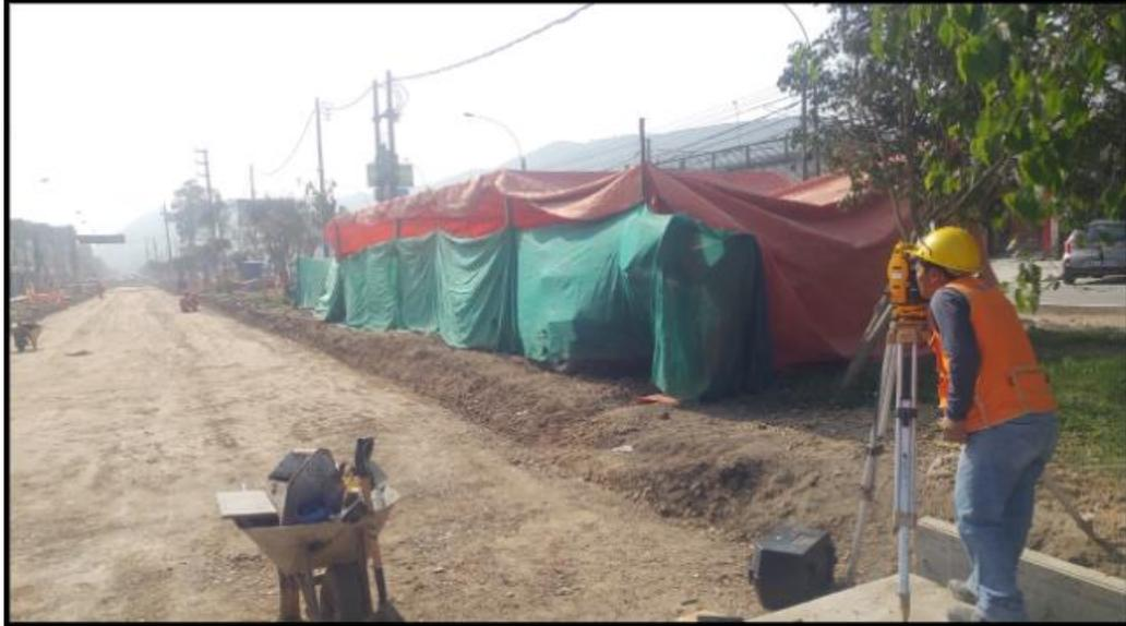
*Ilustración 25 verificación de cotas de terreno a nivel de subrasante con equipo topográfico. Fuente propia*
