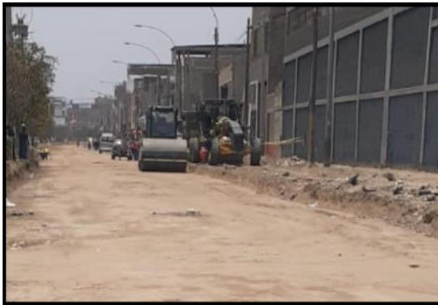
*Ilustración 26 conformación de la subrasante de la vía. Fuente propia*
