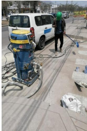
*Ilustración 41 Proceso de limpieza de la fisura. Fuente propia*
