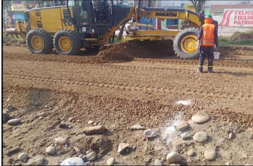
*Ilustración 28 conformación de la base granular e=20cm. Fuente Propia*
