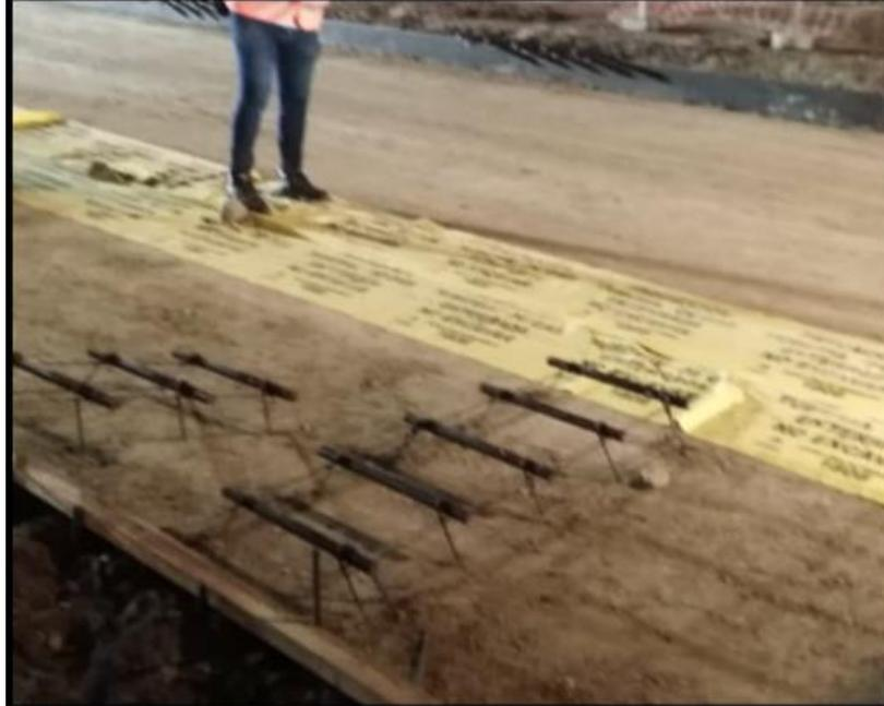
*Ilustración 29 Suministro y colocación de dowells. Fuente propia*
