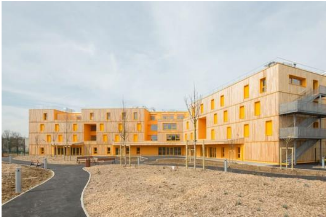
Figura 3 Vista general del caso N°03 Fuente: Archdaily.pe
