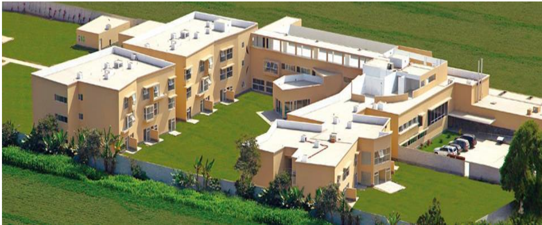
Figura 6 Vista general del caso N°06
