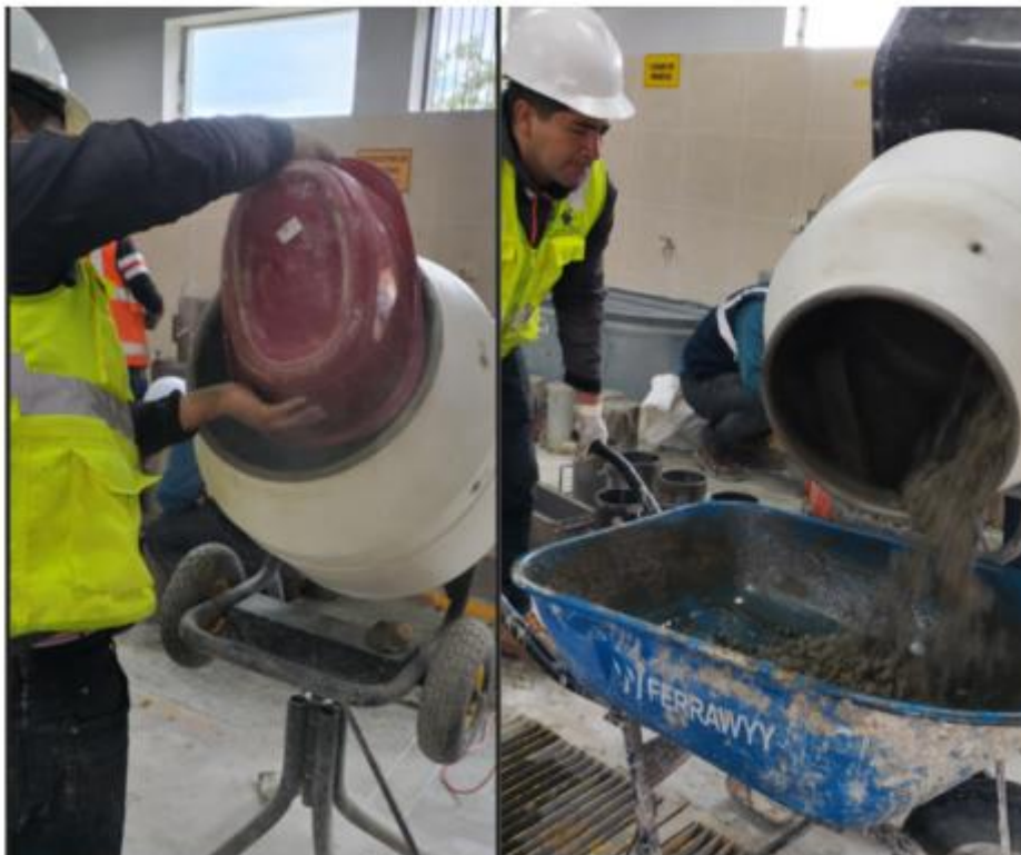
Fotografía 5. Preparación de la mezcla de concreto
