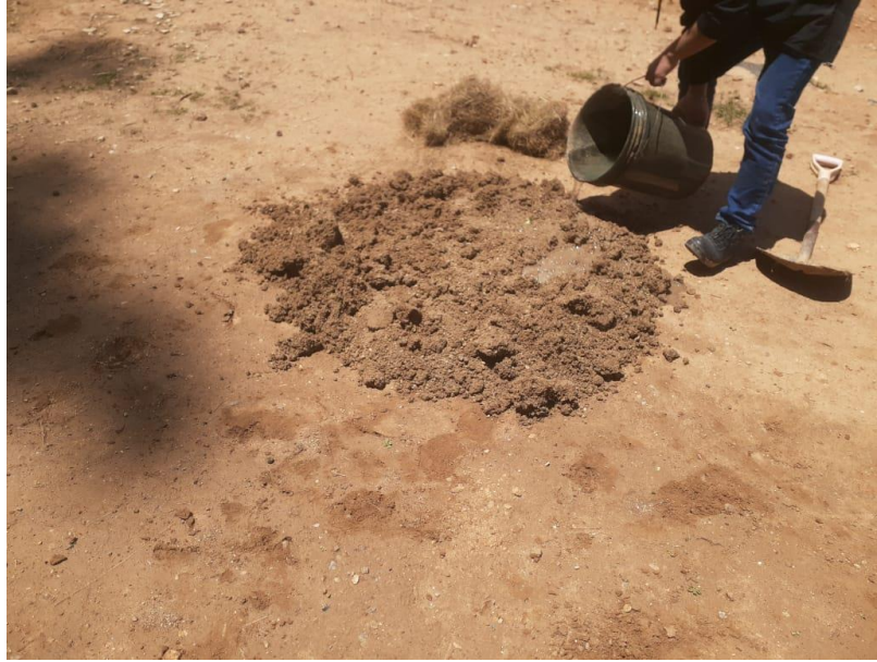
Figura 30. Preparación de suelo para la elaboración de unidades de adobe.
