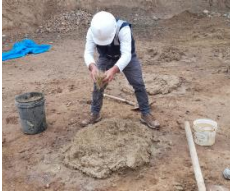
Figura 8. Adición de paja Ichu a la mezcla en preparación
