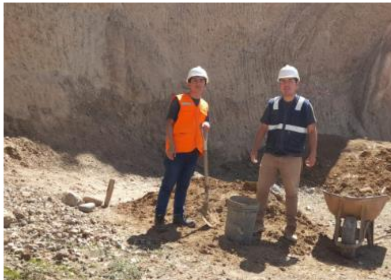
Figura 5. Inicio de extracción de material para elaboración de muestras
