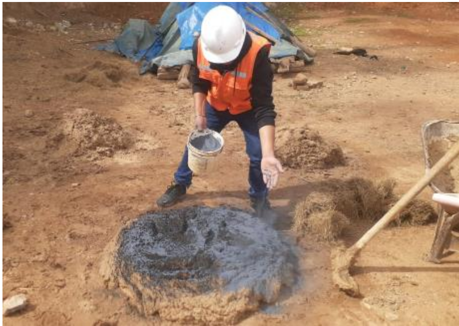
Figura 9. Adición de Humo de sílice condensado a la mezcla
