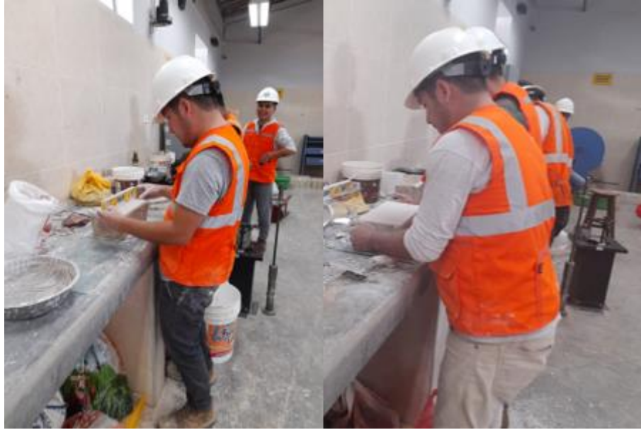
Figura 36. Proceso de refractado de las unidades de adobe.
