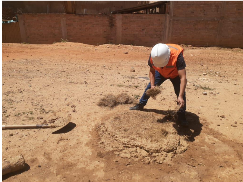
Figura 31. Adición de paja ichu a la composición del suelo para mejorar su resistencia de la unidad de adobe.
