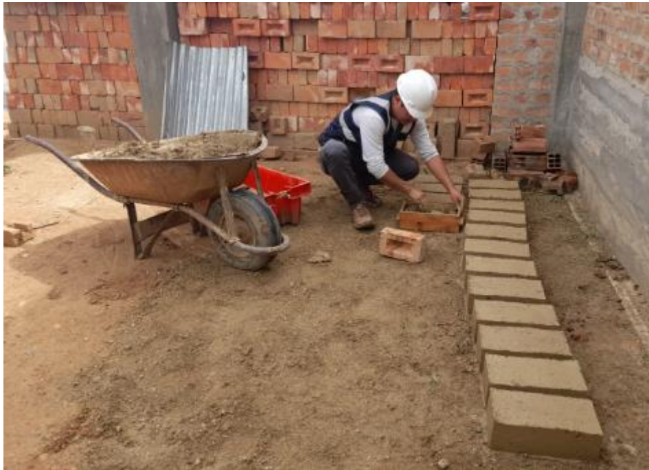
Figura 11. Elaboración de las diferentes unidades de adobes
