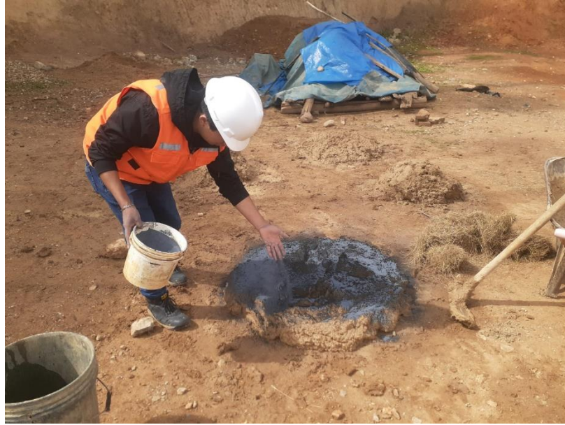
Figura 32. Adición de humo de sílice condensado a la composición del suelo para verificar si mejora la resistencia de la unidad de adobe.
