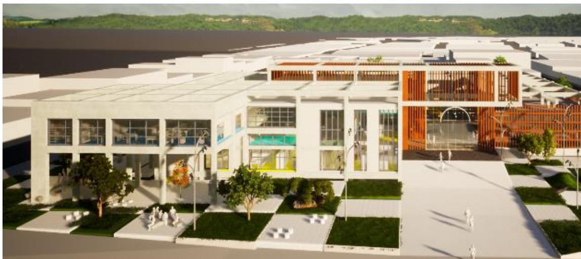
Figura 4.1. Fachada de edificación. Superficies exteriores claras empleadas en el proyecto.
