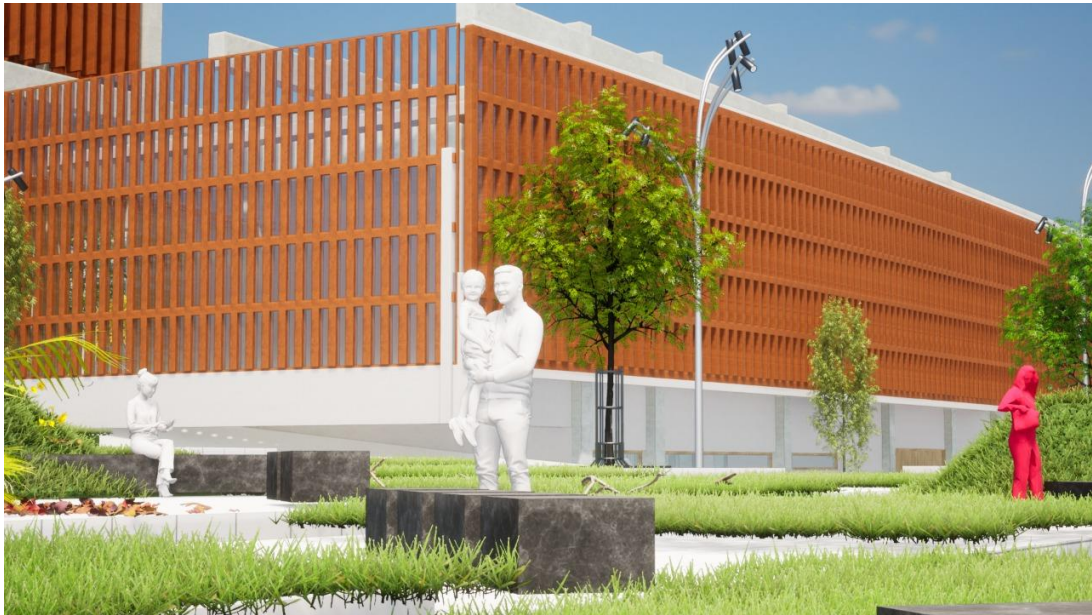
Figura 4.20. Protección solar en el Centro Cívico Municipal – Jaén.
