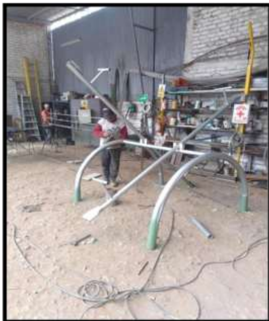
Instalaciones de planta
