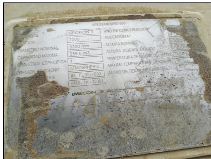
Figura 9: Características del tanque.
