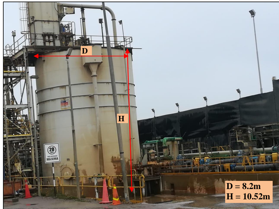
Figura 10: Medidas del tanque.
