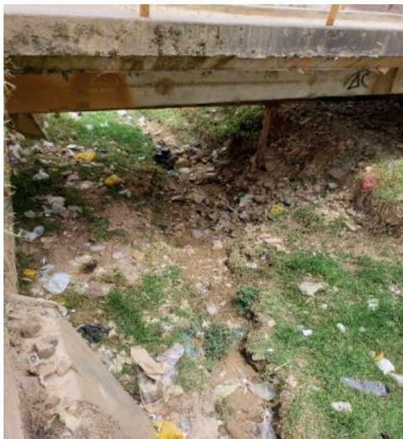
Figura 3 Inspección de la zona de estudio
