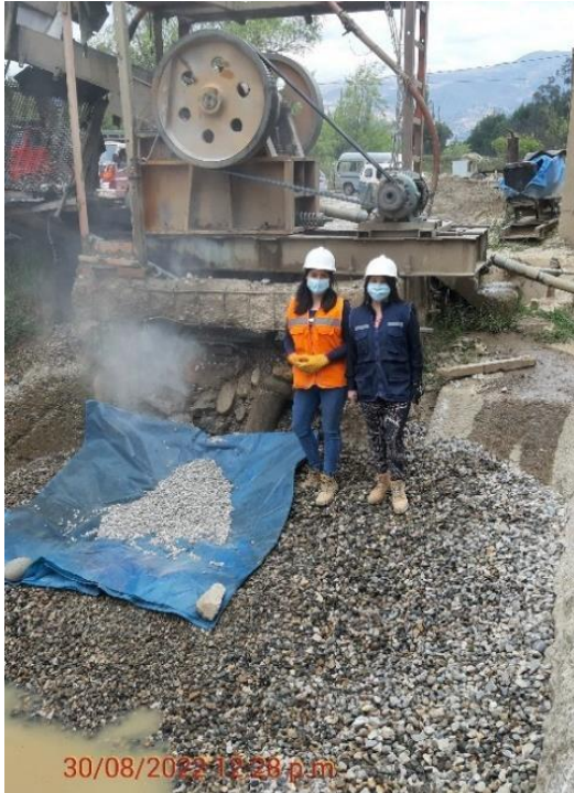
Fotografía N° 5: Agregado reciclado de concreto procesado en la planta trituradora de agregado.
