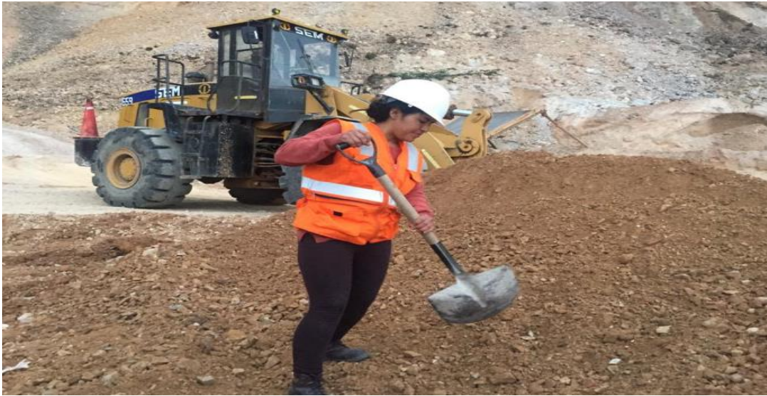
Figura 5 Extracción del material de cantera para subbase "Cantera Aquino - El Gavilán".
