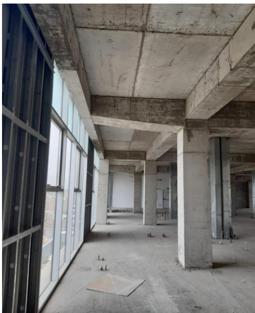
Estructuras de la Clínica Aviva
