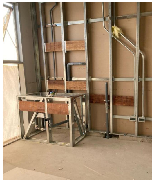
Estructura del Sistema drywall
