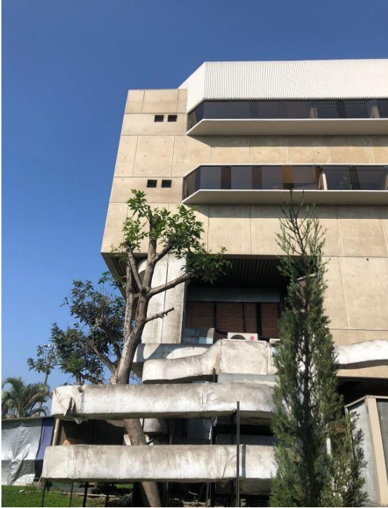
Conexiones visibles de instalaciones
