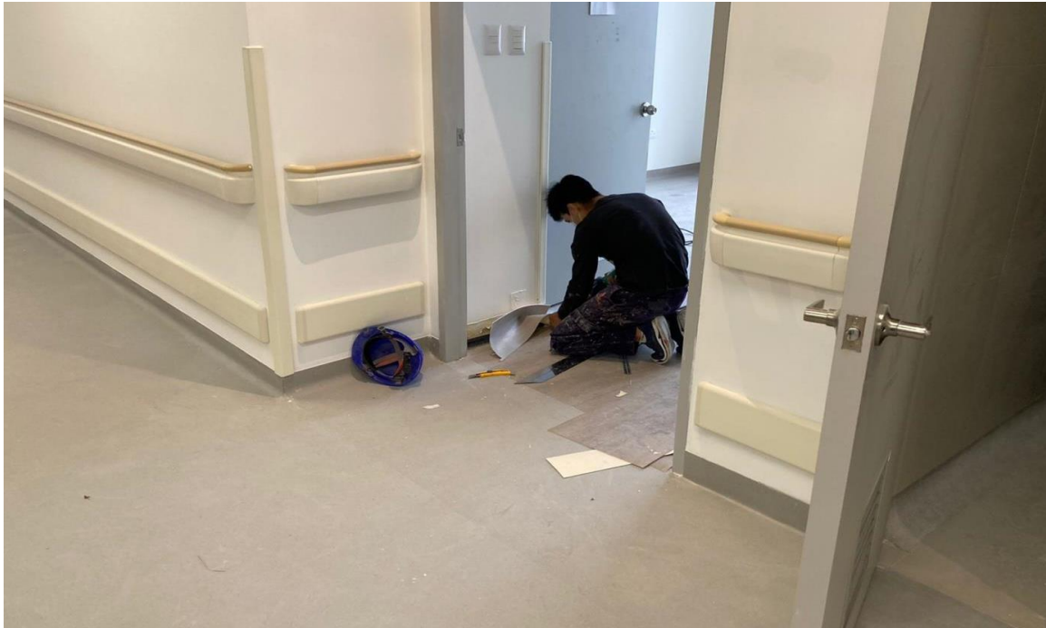
Instalación de zócalos
