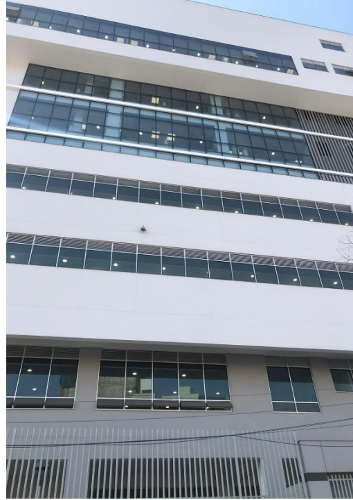
Fachada del nuevo bloque de prevención del INEN
