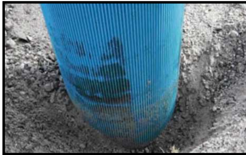
Figura 12: Pozo sin cementar
