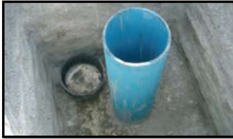
Figura 10: Tubería para revestimiento de pozo
