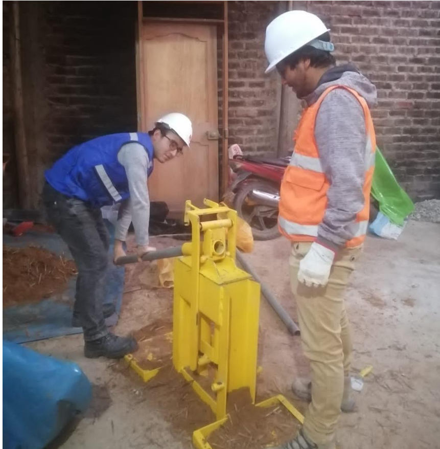
Fotografía 27. Compactación de suelo para la elaboración de adobes.
