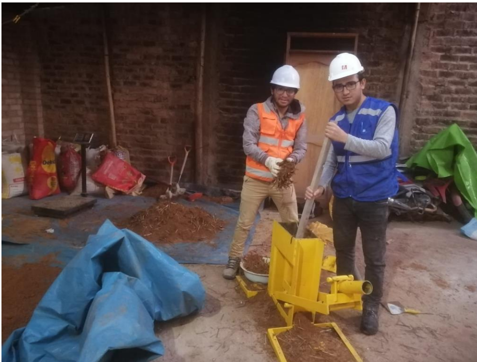
Fotografía 26. Colocación de suelo a la maquina Cinva RAM.
