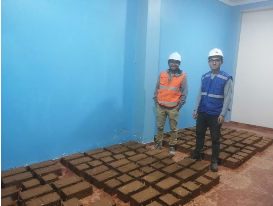
Fotografía 33. Colocación de adobes compactados en un ambiente apropiado para secado.
