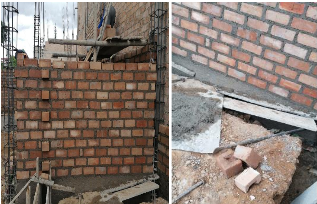
Obra 11: Asentado de muro y desperdicio de ladrillo
