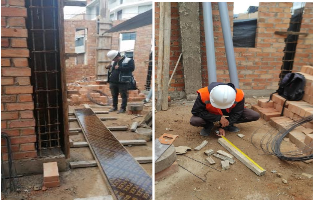
Obra 1: Encofrado de columna y su desperdicio de madera
