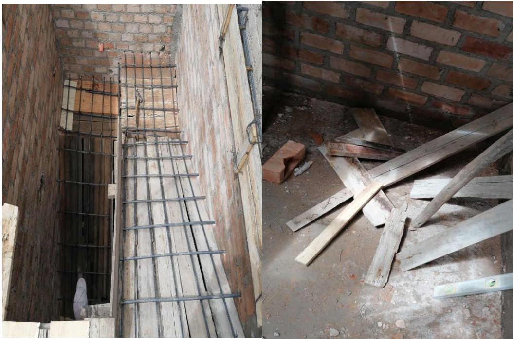
Obra 11: Encofrado de escalera y desperdicio
