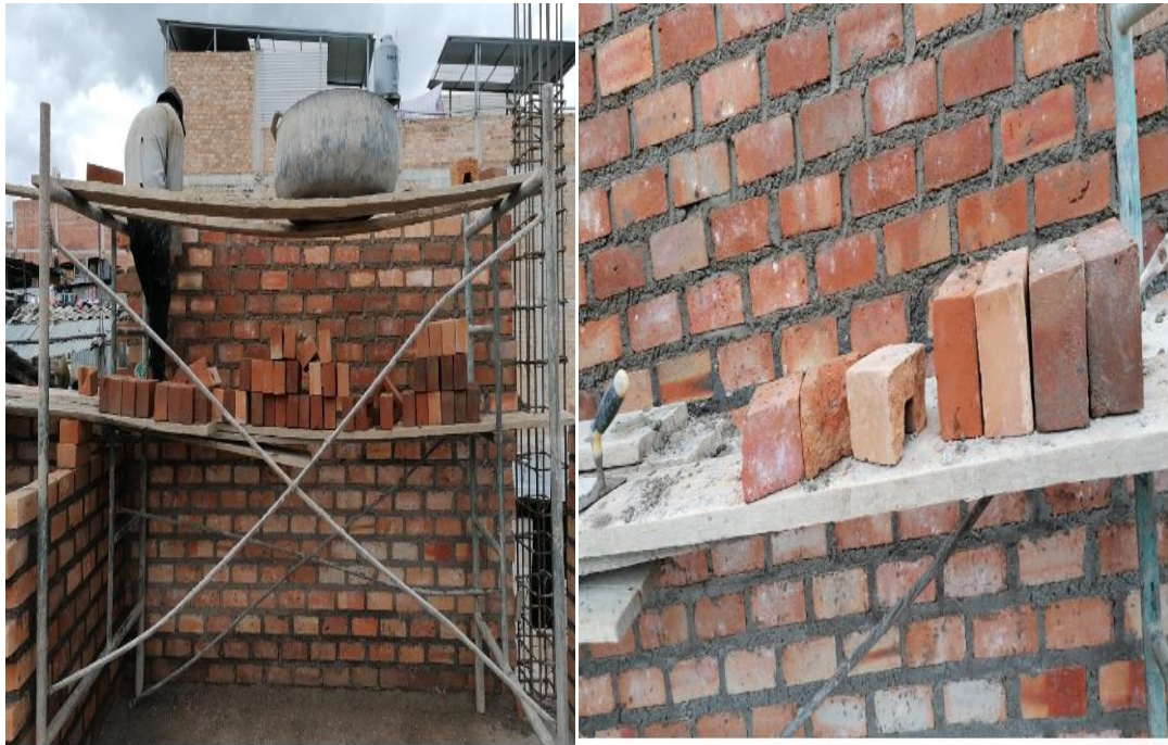
Obra 9: Asentado y desperdicio de ladrillo
