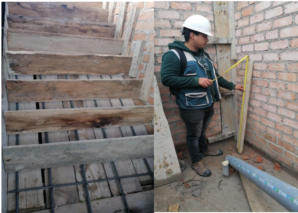
Obra 2: Encofrado de escalera y desperdicio de madera
