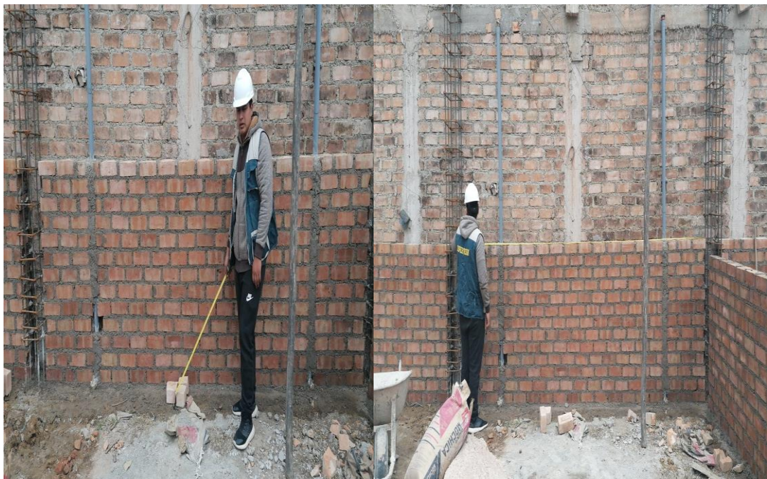
Obra 4: Asentado de muro y desperdicio de ladrillo
