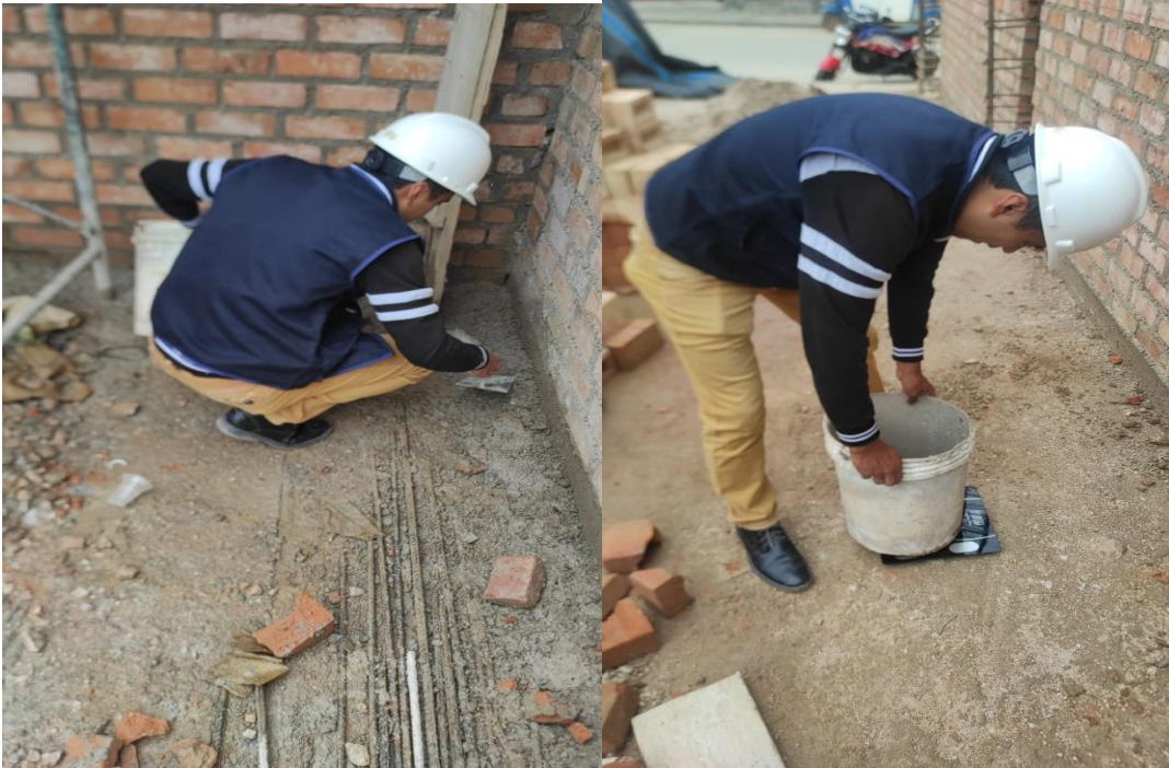
Obra 5: Mortero en muros y pesaje del desperdicio
