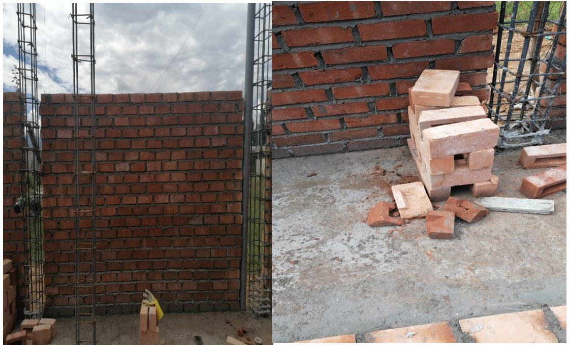
Obra 10: Asentado de muro y desperdicio de ladrillo
