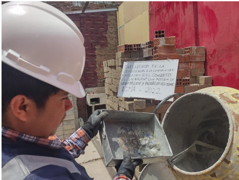
Figura 82. Preparación de la mezcla
