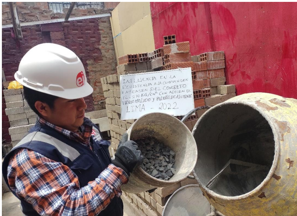
Figura 80. Preparación de la mezcla
