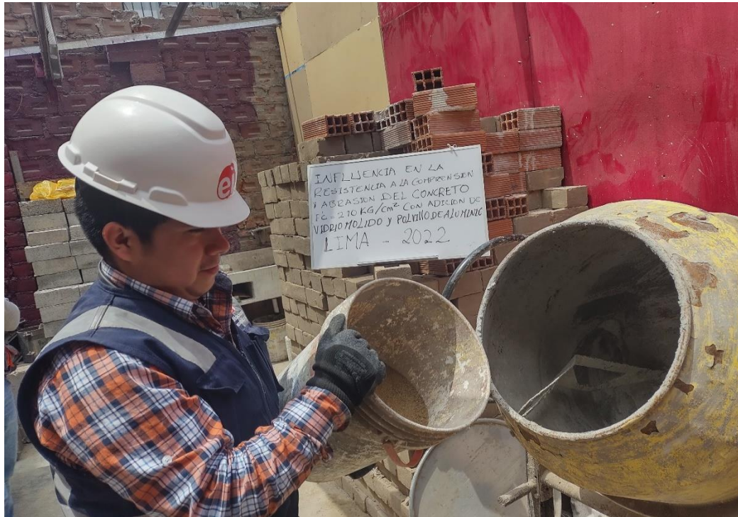
Figura 79. Preparación de la mezcla
