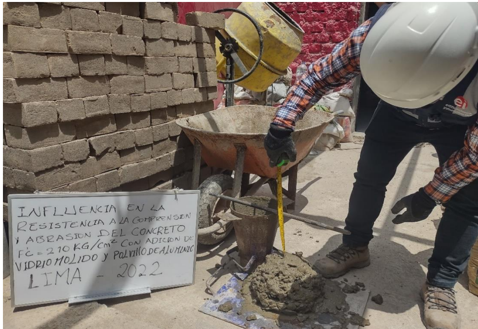
Figura 86. Prueba del Slump
