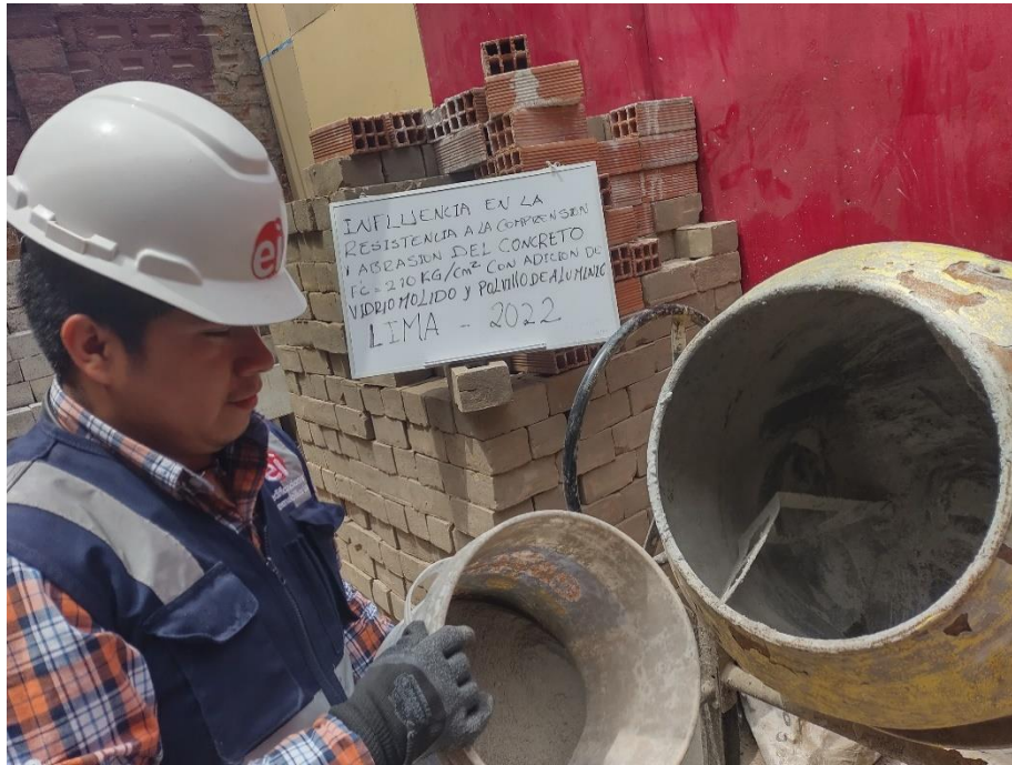
Figura 81. Preparación de la mezcla
