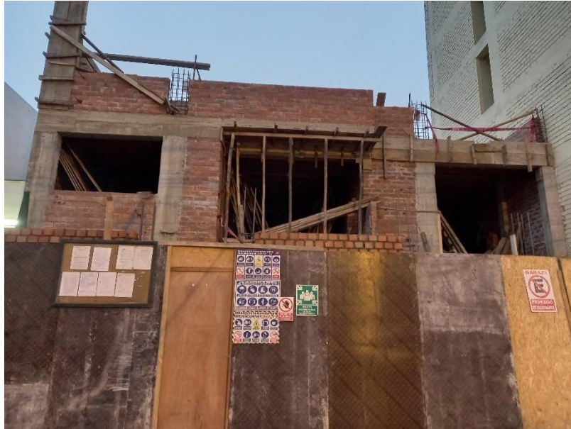
Nota: Imagen de la fachada del multifamiliar Huayna Cápac
