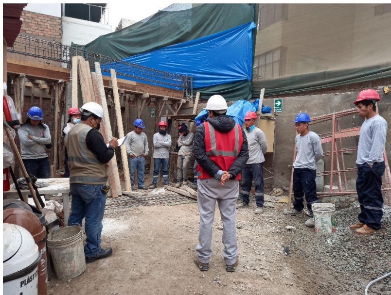
Nota: Charla de seguridad en el multifamiliar Huayna Cápac
