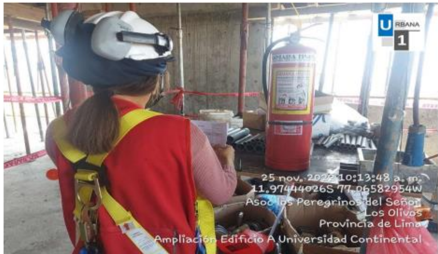
Foto N°5: Inspección de extintores.
