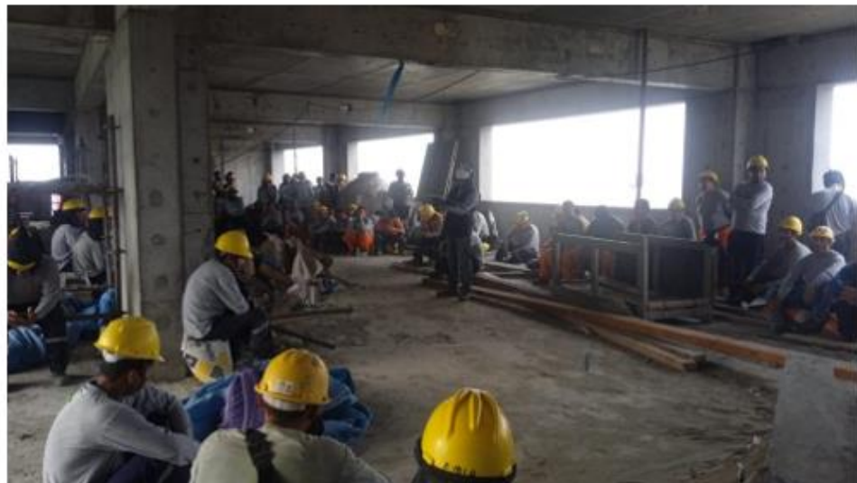
Foto N°12: charla diaria de seguridad por cuadrillas
