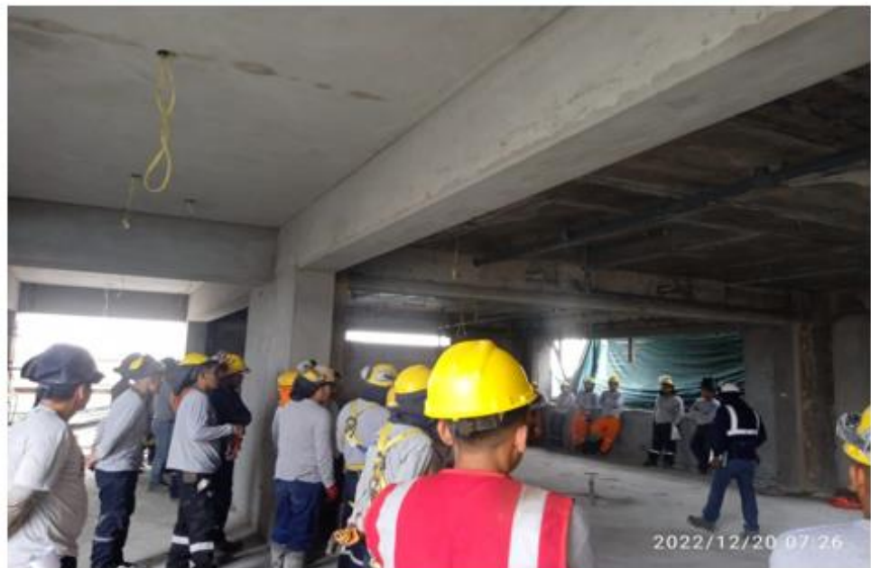
Foto N°6: Charla diaria de seguridad en piso 7 por cuadrilla.
