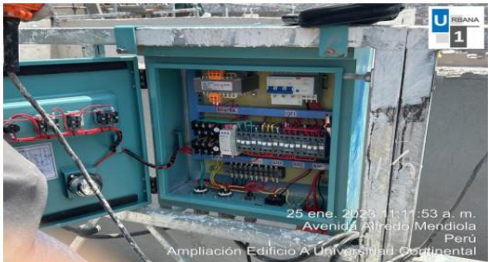
Foto N°8: Inspección de tablero de andamio colgante
