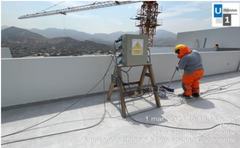
Foto N°3: Inspección de tablero eléctrico piso 13
