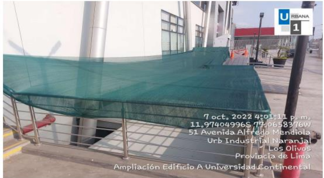
Foto: Colocación de malla raschell para evitar caídas de partículas y otros (área de laboratorios)
