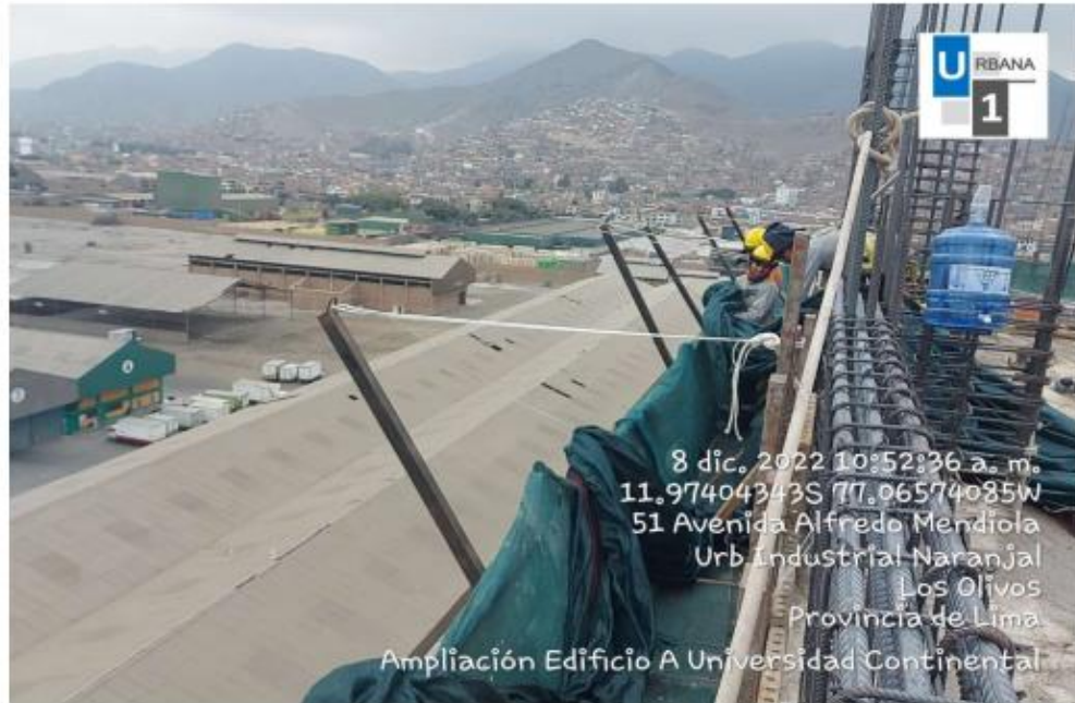
Foto N°10: Instalación de estructura de sistema de malla anticáida.
