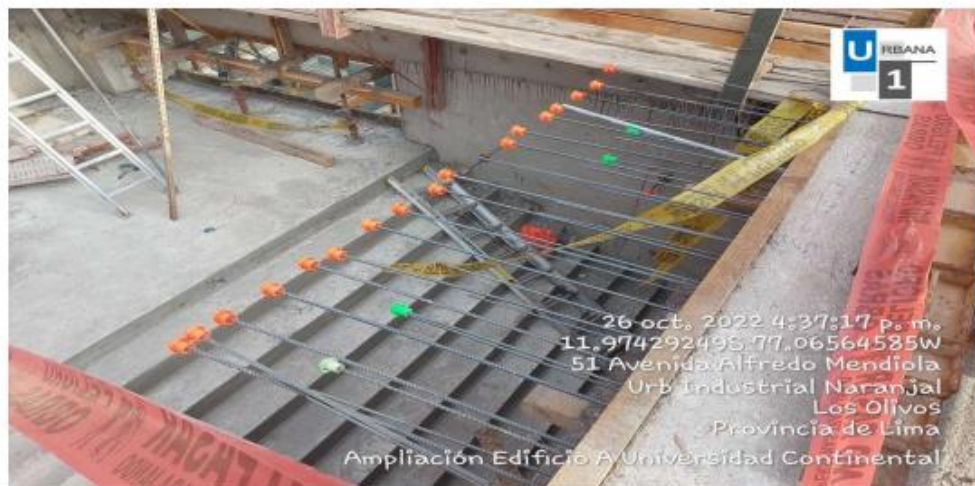
Foto; Colocación de capuchones en el piso ocho.
