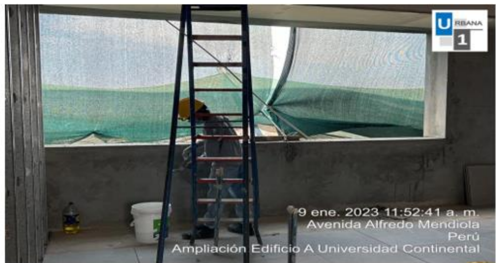
Foto N°3: Personal de la cuadrilla de empaste y pintura vienen haciendo uso de las escaleras de obra, lo cual se solicitó que realicen un check list de escaleras.
