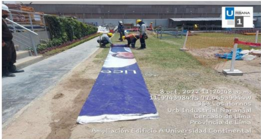
Foto: Se realiza el guardado de paneles publicitarios y otros de la Universidad Continental.
