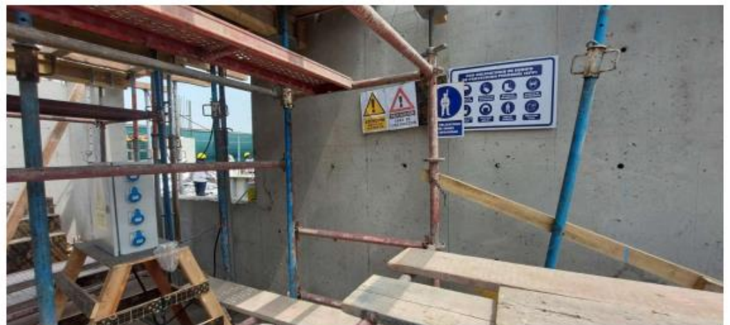
Foto: Colocación de carteles de señalización en 7mo piso.
