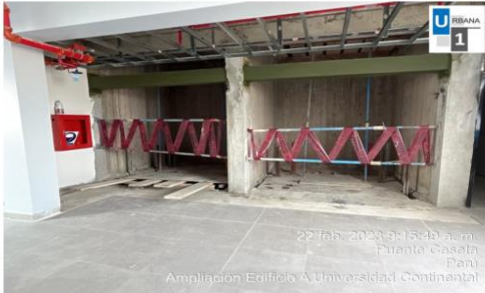
Foto N°21: señalización en zona de ascensor
