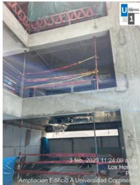
Foto N°19: señalización de obra permanente
