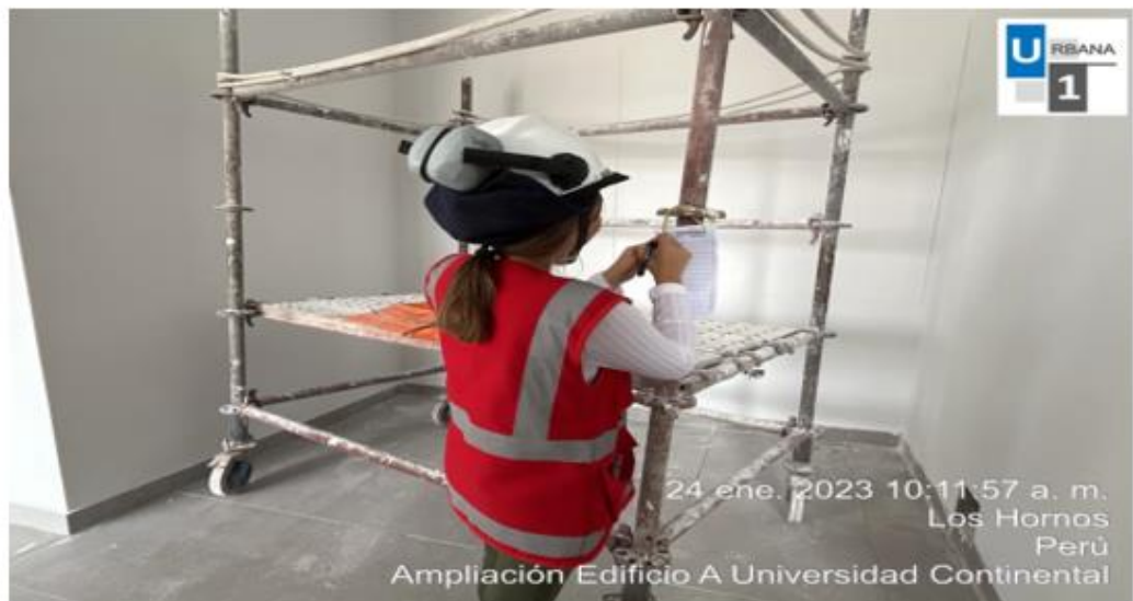
Foto N°4: Inspección andamio piso 7 (interiores)
