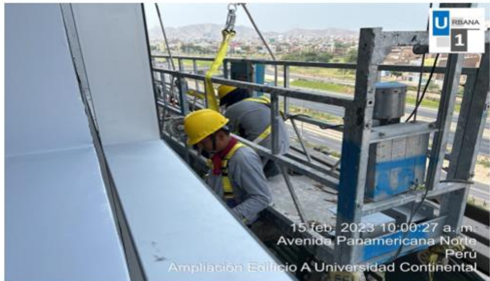
Foto N°2: Inspección de andamio colgante en fachada
