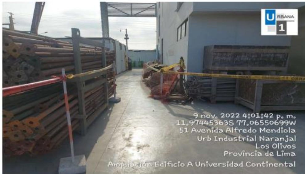
Foto N°12: orden y limpieza de materiales en primer nivel.
