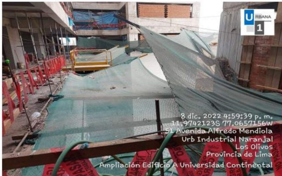
Foto N°12: Limpieza de malla anticaídas en el piso 7.
