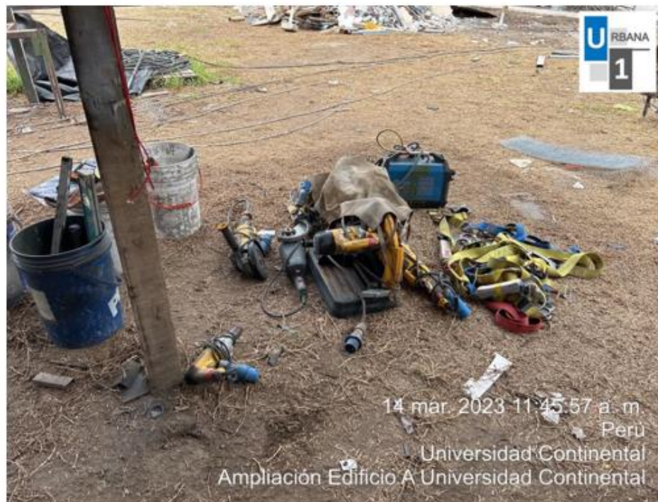
Foto N°1: Inspección de herramientas manuales
