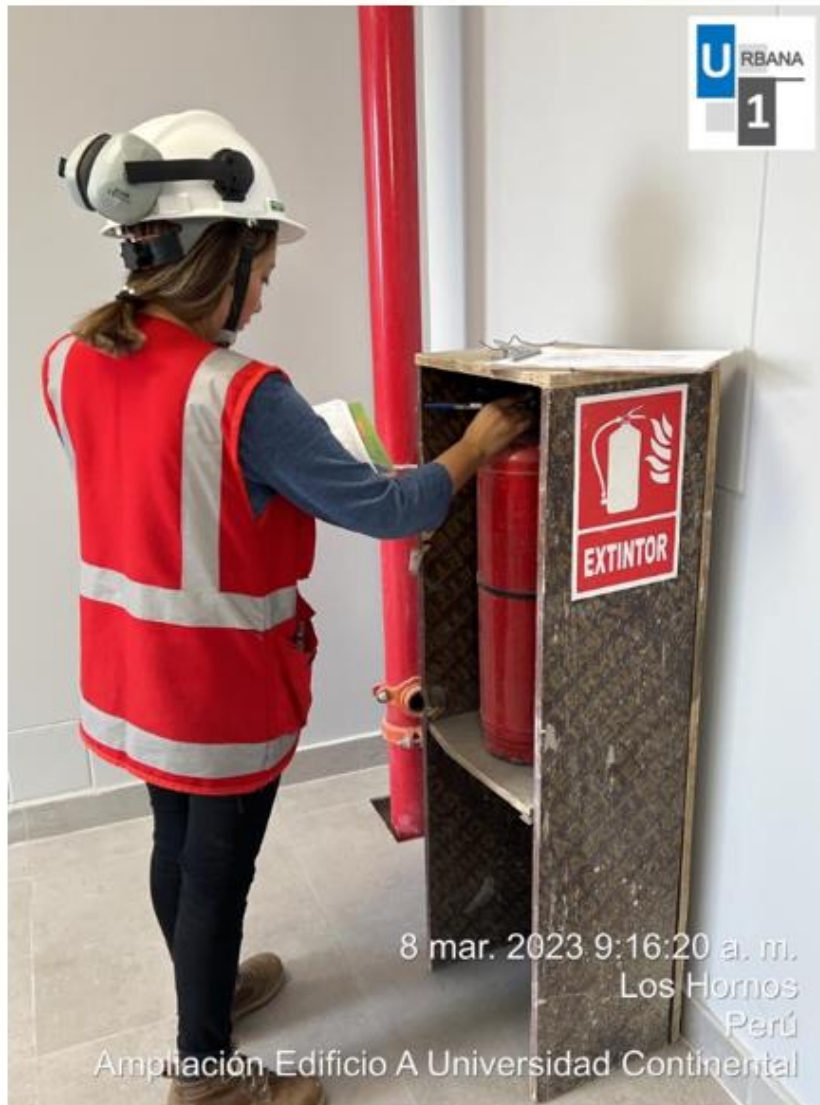
Foto N°4: Inspección de extintor piso 7
