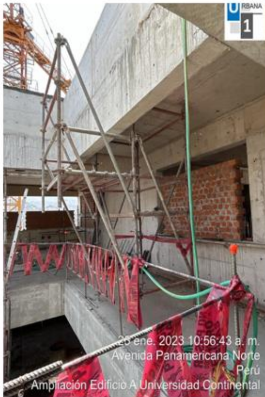
Foto N°1: Inspección andamio piso 12
