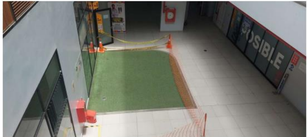
Foto: Señalización de sótano con malla naranja, cachacos y cinta.
