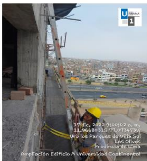
Foto N°5: Inspección de barandas en fachada sector 4 y 5.
