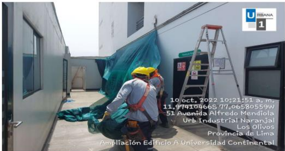
Foto: Colocación de malla raschell para evitar caídas de partículas y otros.
