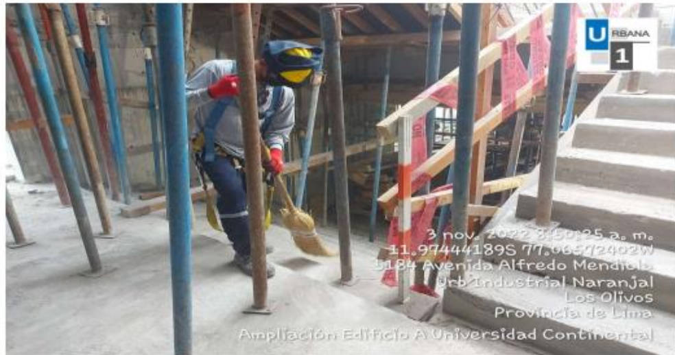
Foto N°4: Orden y limpieza en áreas comunes.
