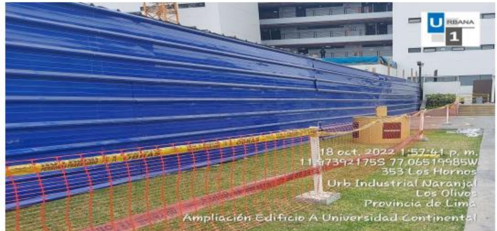
Foto: Señalización externa de obra.
