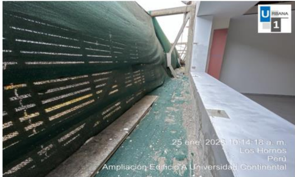
Foto N°5: Inspección de barandas en fachada piso 7 sector 2.
