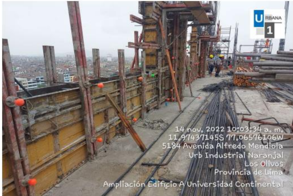
Foto N°18: Colocación de capuchones en espárragos.
