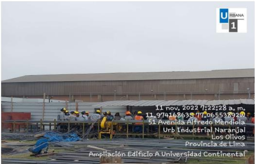
Foto N°2: Charla diaria de seguridad por grupo (acero).
