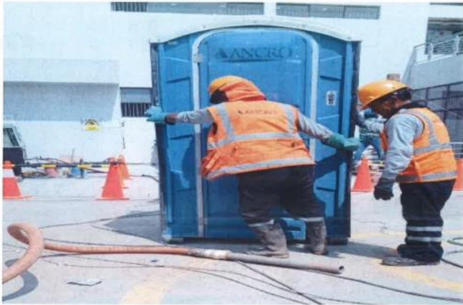
Foto N°15: limpieza de baños químicos de obra
