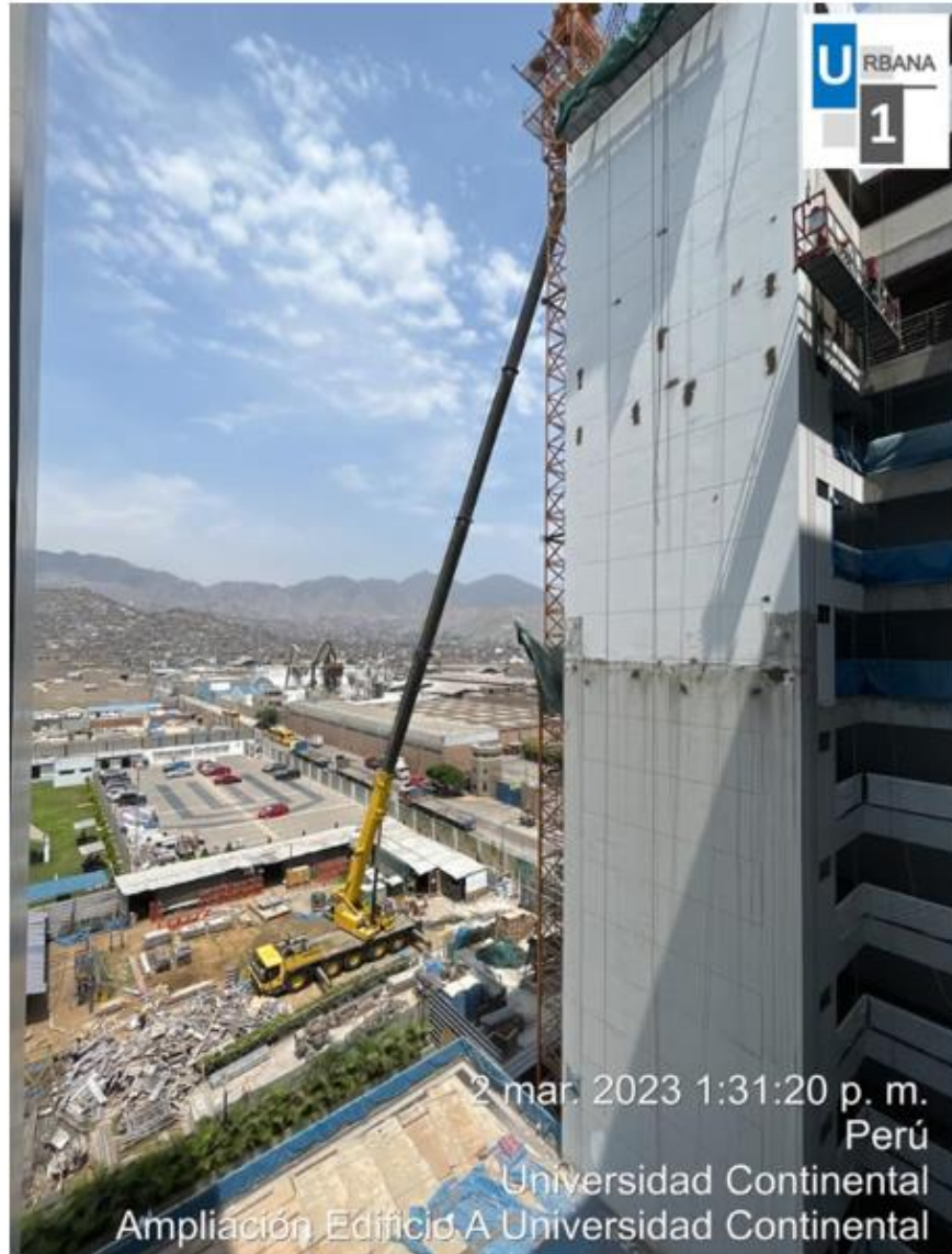
Foto N°9: Desmontaje de torre grúa
