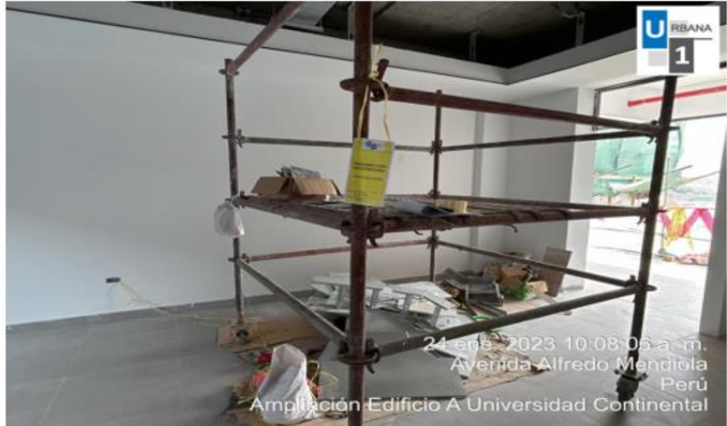
Foto N°3: Inspección andamio piso 8
