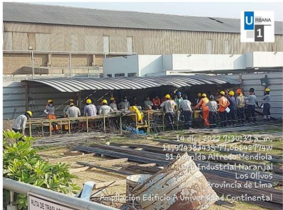
Foto N°7: Charla diaria de seguridad área de acero.
