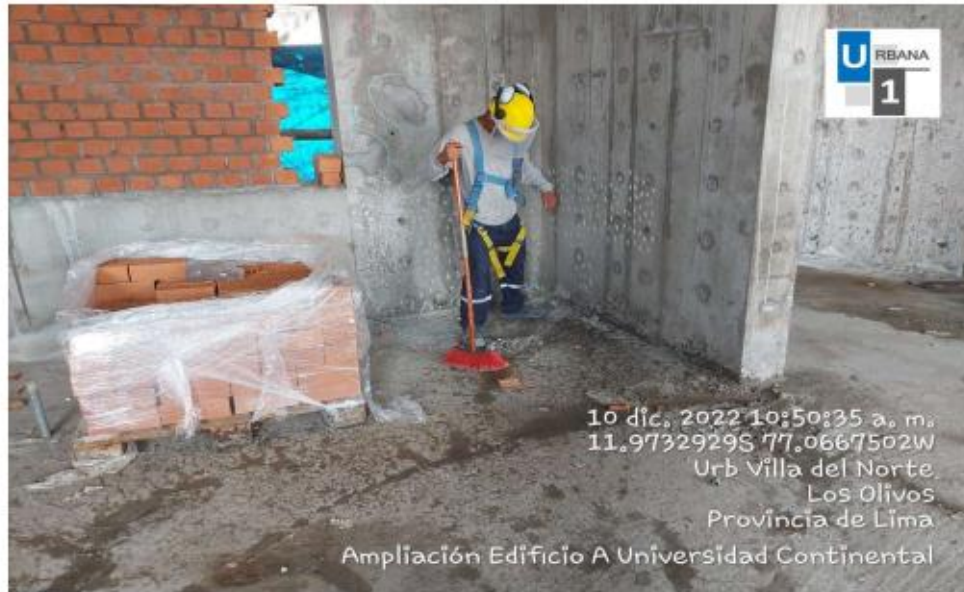
Foto N°14: Orden y limpieza del área de albañilería.
