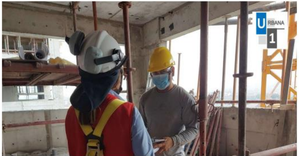
Foto N°7: Inspección de herramientas manuales.
