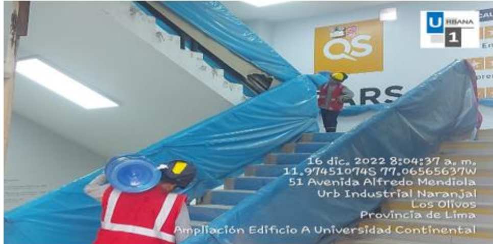
Foto N°8: Colocación de bidones de agua por piso de trabajo.
