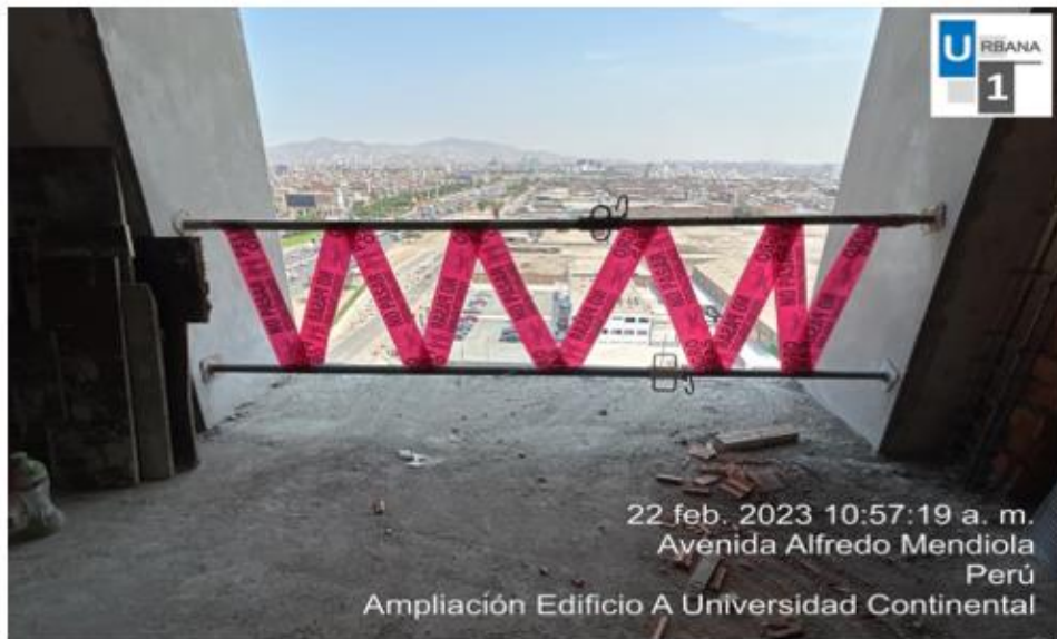
Foto N°22: señalización lado norte de la UC piso 13
