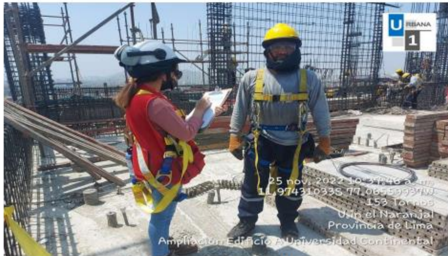
Foto N°4: Inspección de arnés y línea de vida
