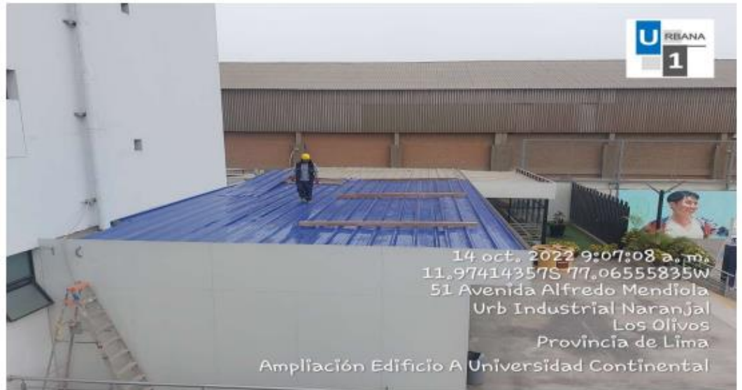
Foto: Doble forrado con TR4 en techo de cafetería.
