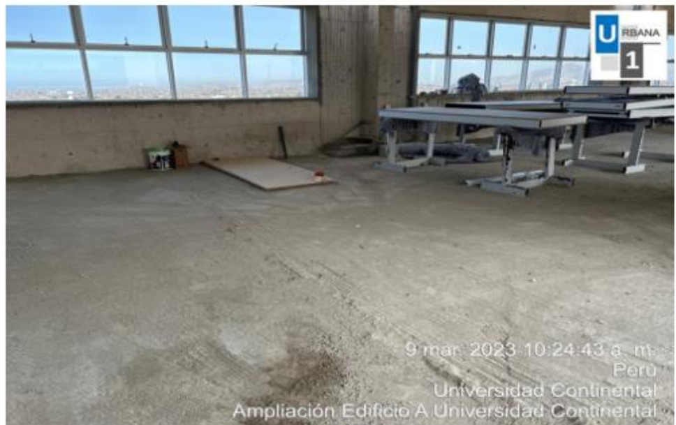
Foto N°8: Verificación de orden y limpieza piso 12
