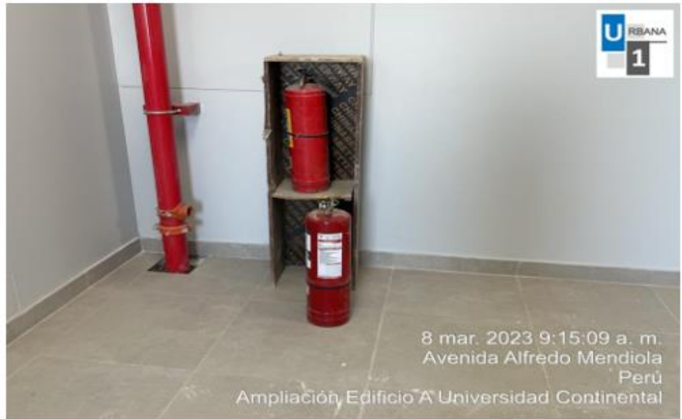
Foto N°5: Inspección de extintor piso 8
