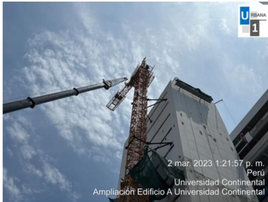
Foto N°10: Desmontaje de torre grúa
