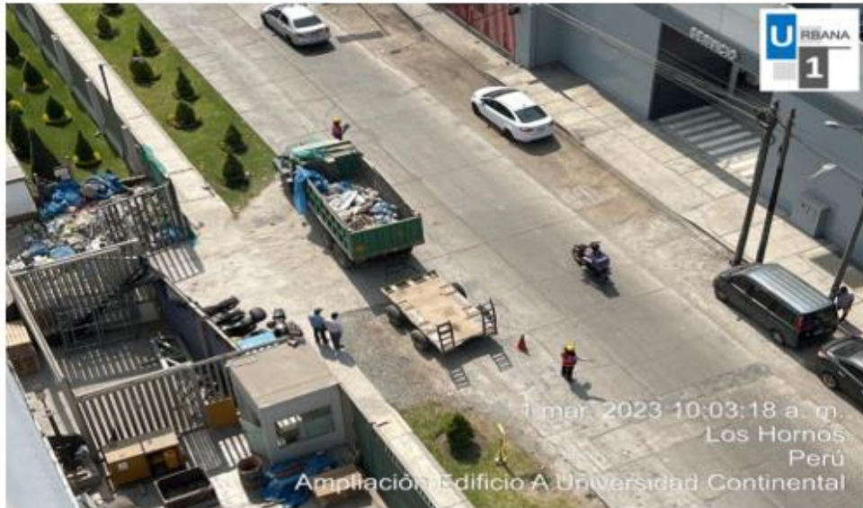
Foto N°16: eliminación de residuos sólidos de obra.
