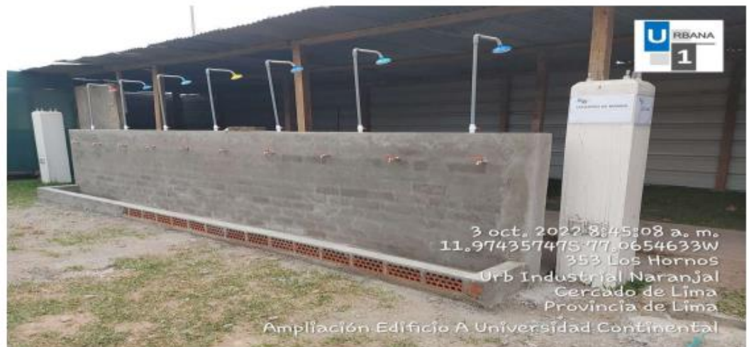
Foto: Acondicionamiento de lavaderos y duchas.
