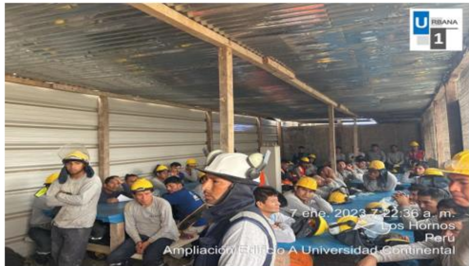
Foto N°13: Charla diaria de seguridad en el comedor de obra.
