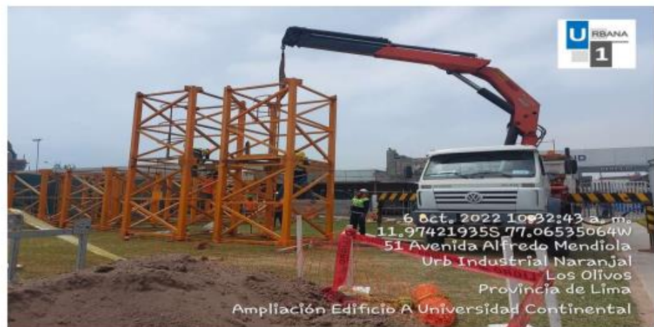
Foto: Señalización para maniobra de torre grúa.
