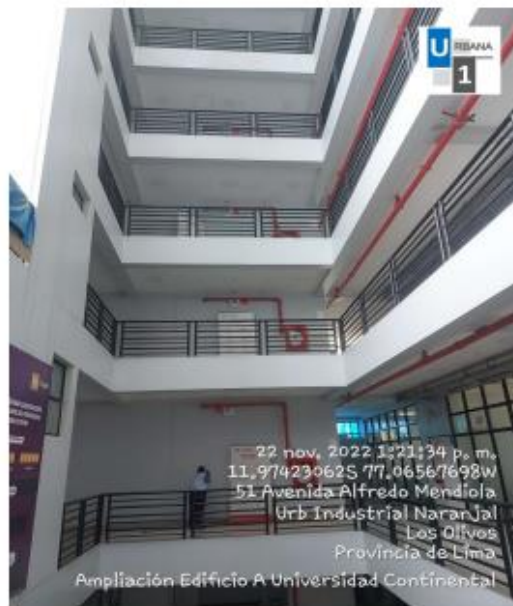
Foto N°15 y N°16: Colocación de plástico blanco en barandas y colocación de barandas y malla raschell en exterior de fachada.
