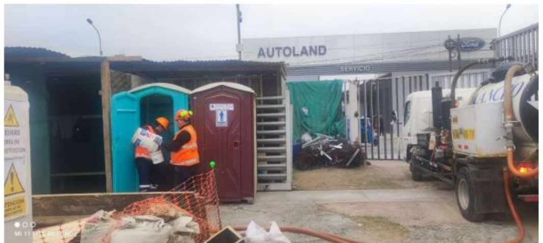
Foto: Implementación y limpieza de baños químicos.
