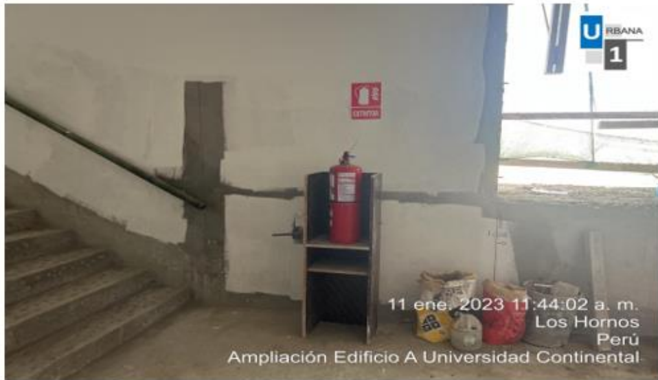
Foto N°18: Instalación de extintores en obra en los pisos 7, 8 y 9.
