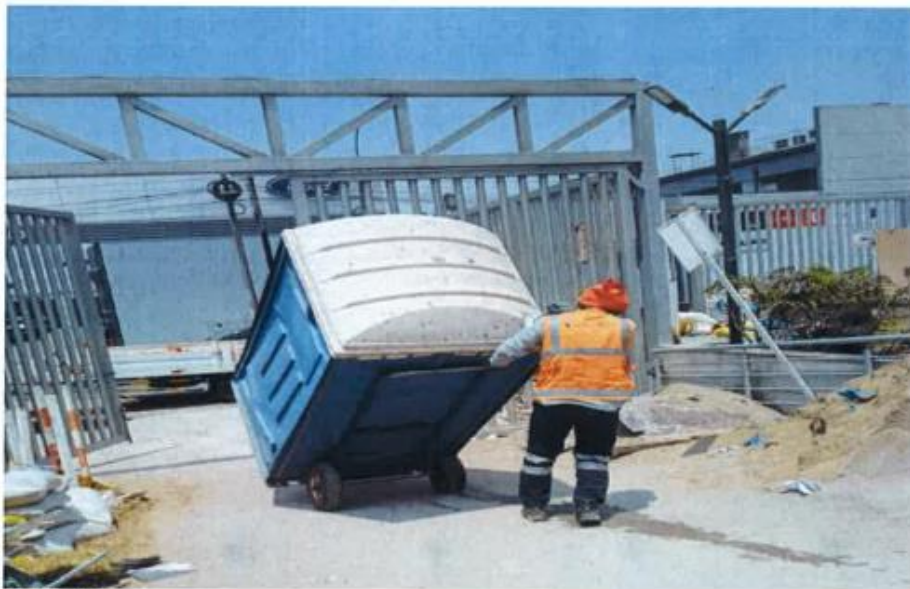
Foto N°16: con fecha 27 de marzo se llevan los dos último baños químicos
