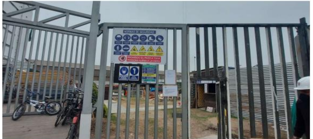
Foto: Cartel de EPP de ingreso a obra.
