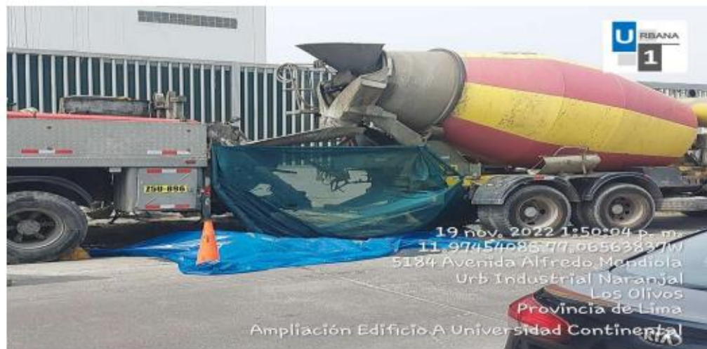
Foto N°13: Colocación de plástico y malla raschell como contención de concreto.
