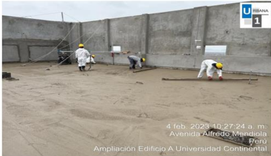
Foto N°20: actividad de vaciado de concreto con los EPP correspondientes
