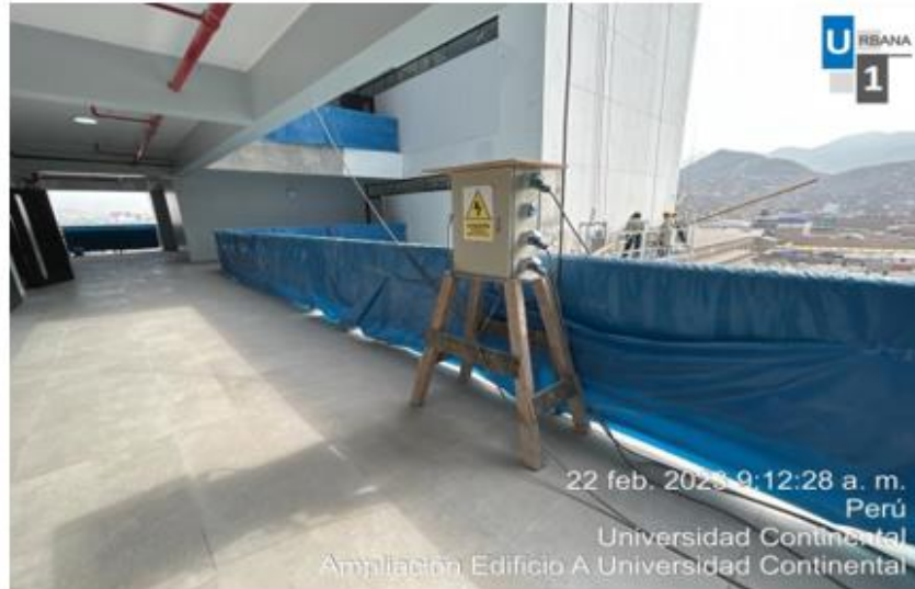
Foto N°4: Inspección de tablero eléctrico piso 7
