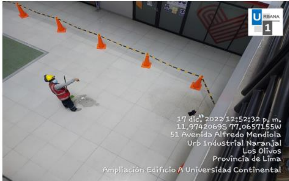
Foto N°10: Limpieza de sótano realizado por monitores y delimitación del área.
