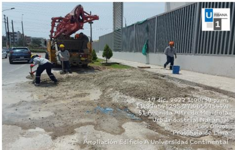
Foto N°11: Limpieza de residuos de la bomba de concreto fuera de la UC.
