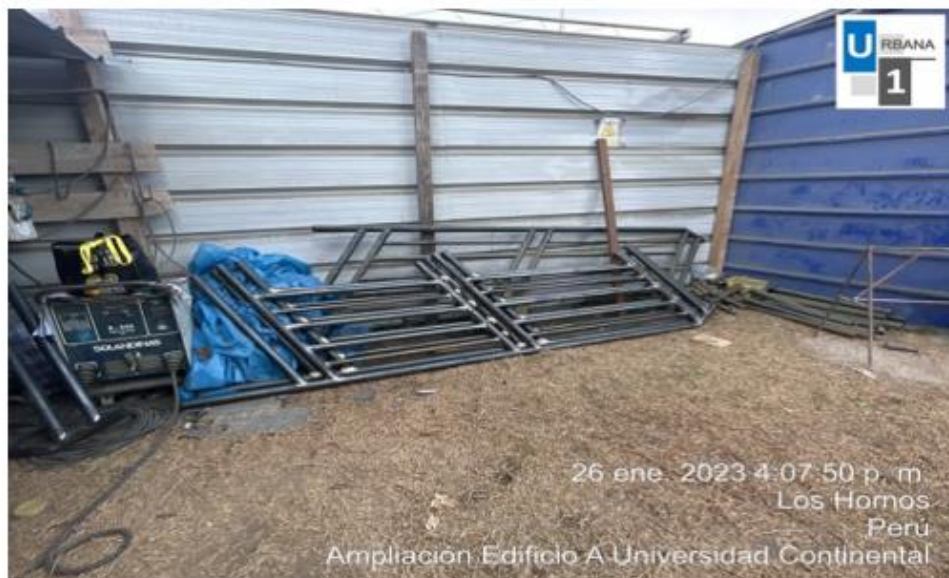
Foto N°19: verificación de orden y limpieza en taller de fabricación de barandas
