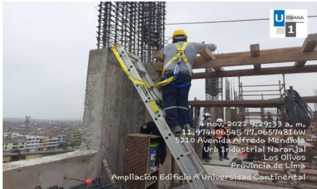
Foto N°6: Seguimiento en campo de uso correcto de escaleras.
