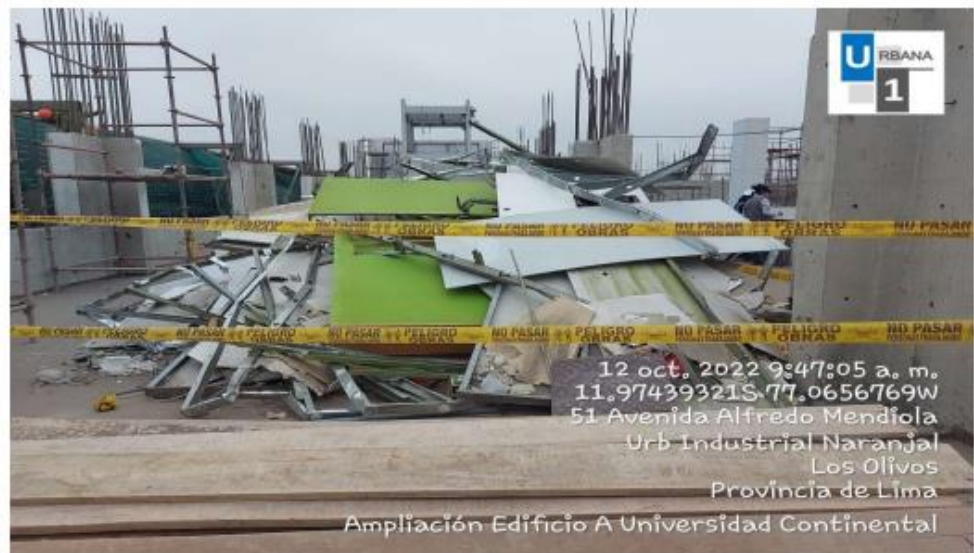
Foto: Cercado de punto de acopio en el 7mo nivel.
