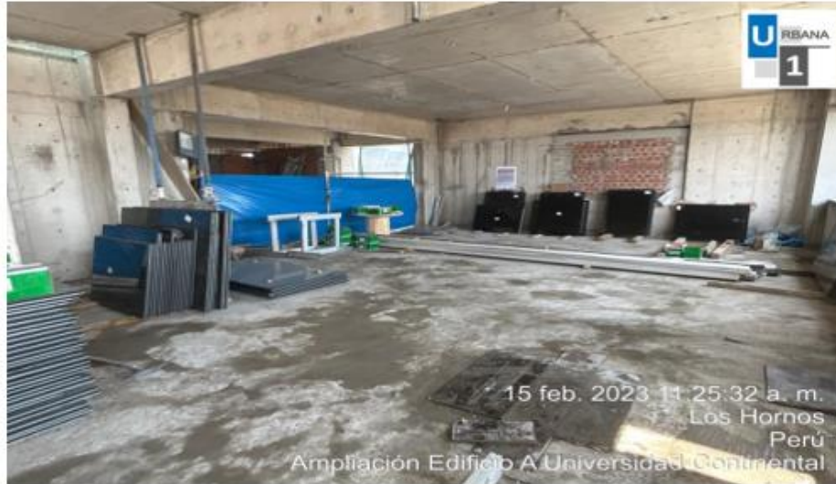
Foto N°18: Orden y limpieza piso 12 talleres de vidrios
