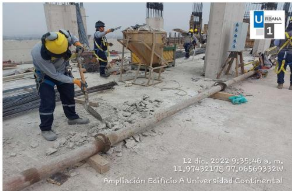
Foto N°15: Orden y limpieza de residuos de concreto.
