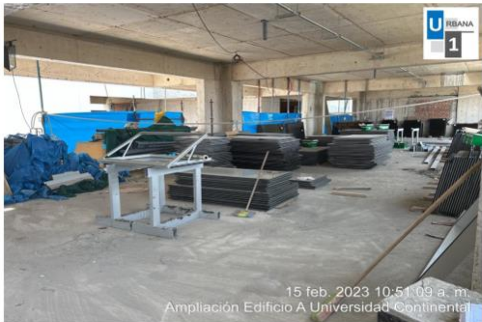
Foto N°17: Orden y limpieza piso 12 talleres de vidrios
