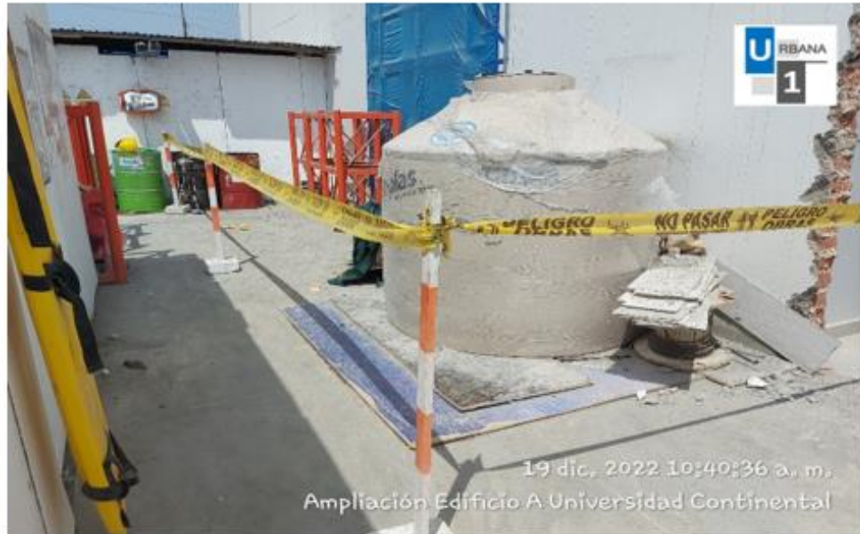
Foto N°12: Delimitación en el primer nivel por la limpieza de mallas en los pisos superiores.
