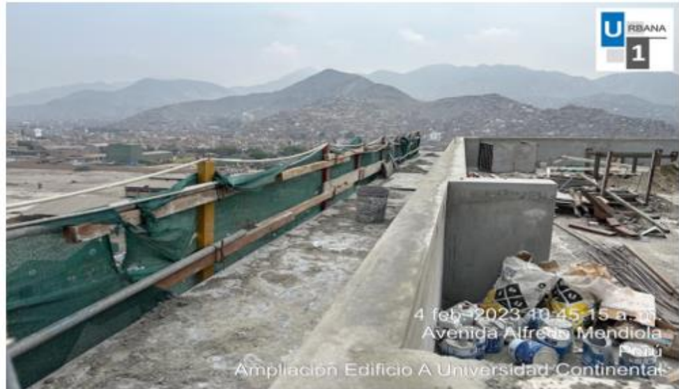
Foto N°4: Inspección de barandas en fachada lado lateral en fachada.
