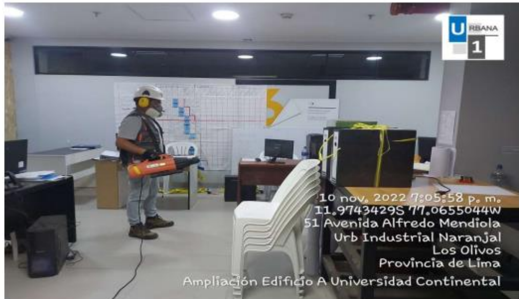
Foto N°14: Desinfección de obra (oficina)
