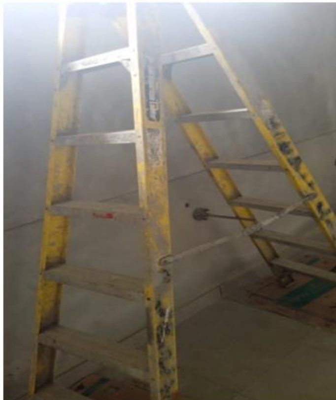
Foto N°1: Inspección de escaleras en obra, se procede a decomisar las escaleras defectuosas e inoperativas.
