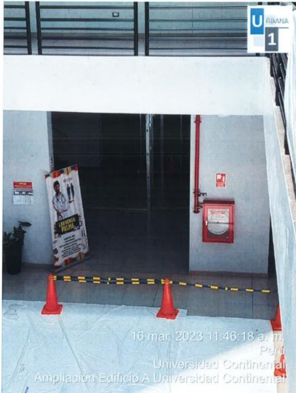
Foto N°10: señalización en sótano UC
