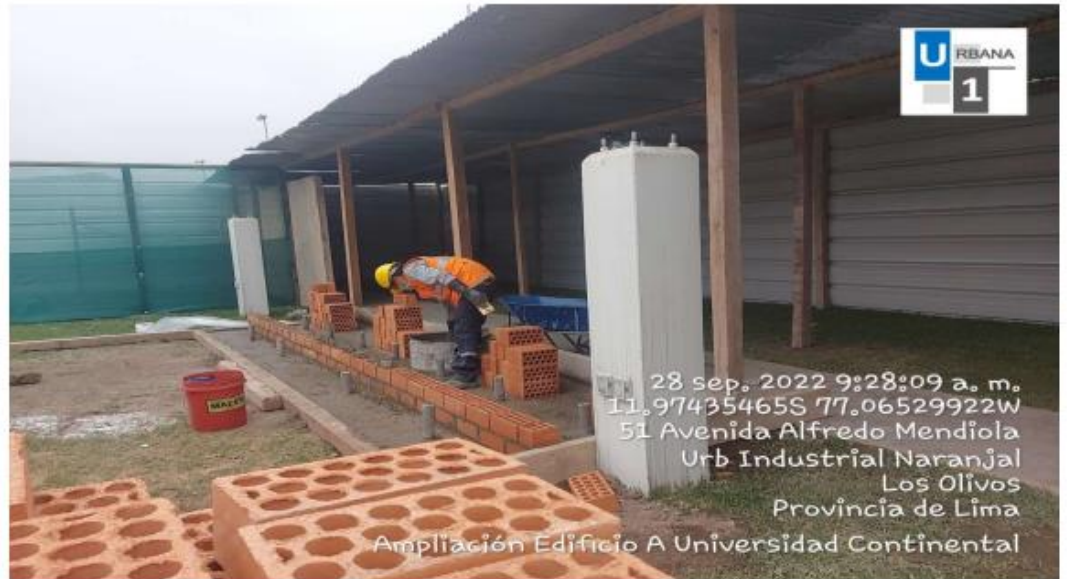
Foto: Acondicionamiento de baños y duchas para el personal obrero.
