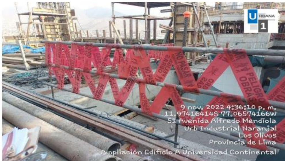
Foto N°13: Señalización de barandas en piso 9 y 10.
