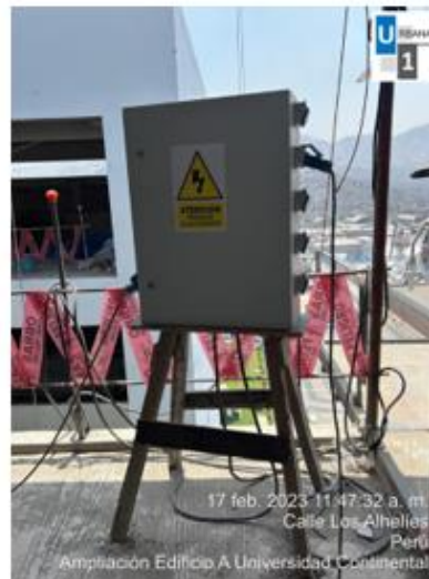
Foto N°3: Inspección de tablero eléctrico piso 10
