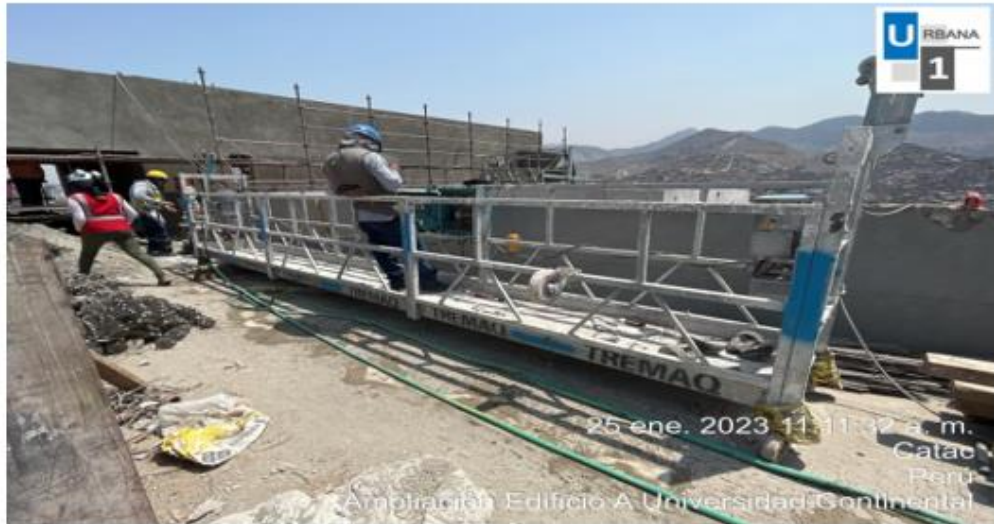
Foto N°7: Inspección de andamio colgante
