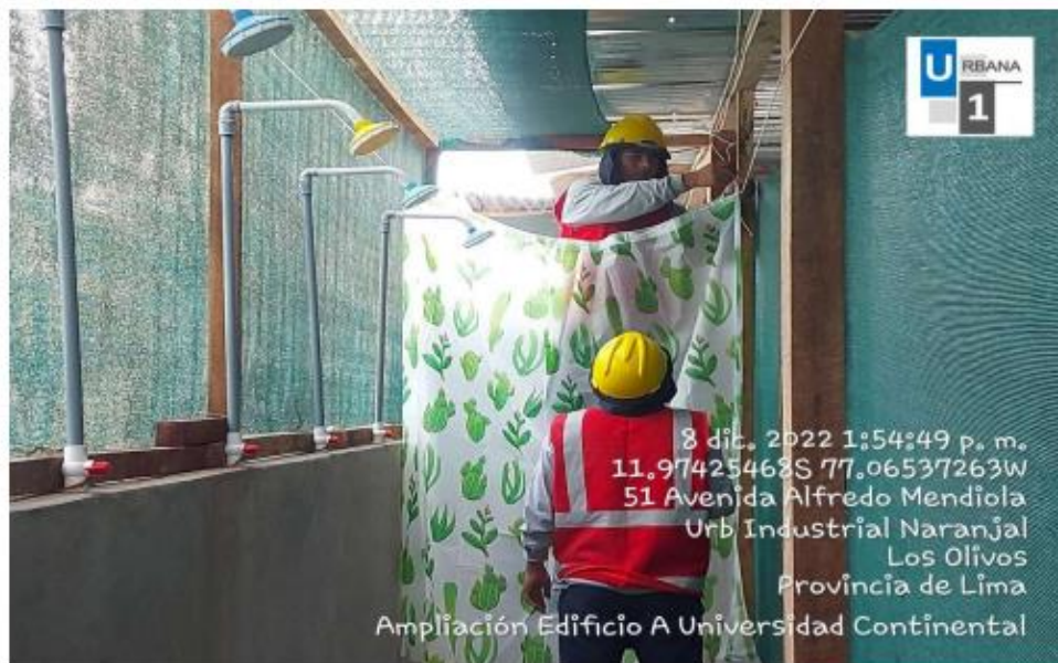
Foto N°11: Instalación de cortinas en duchas de obra.
