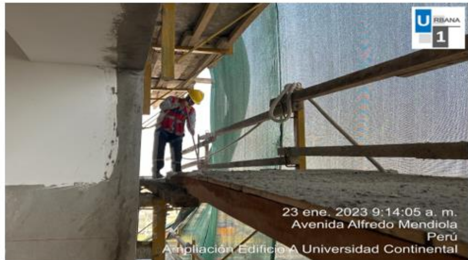
Foto N°6: Inspección de barandas en fachada piso 7 sectores 4 y 5
