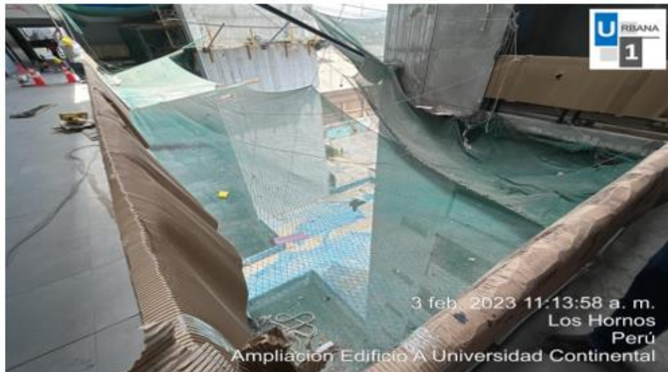
Foto N°15: limpieza de malla anti-caídas y malla raschell
