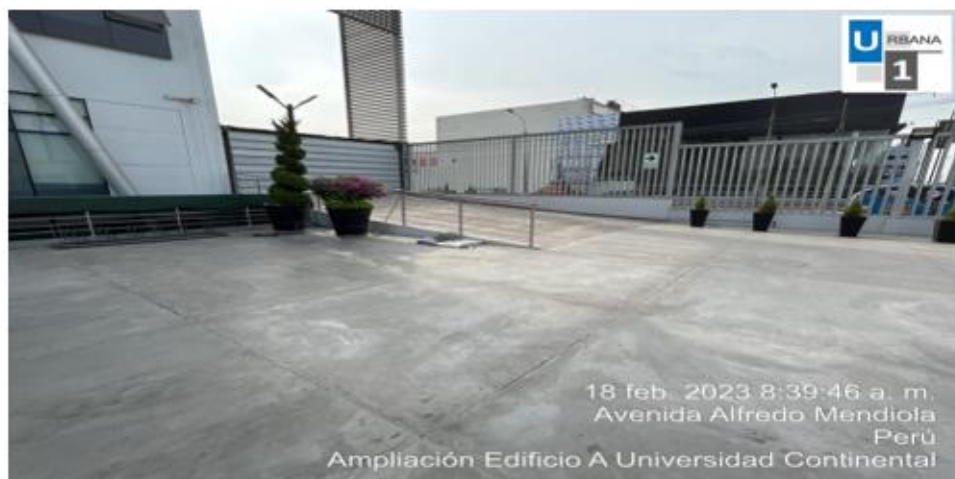
Foto N°16: orden y limpieza frontis de la UC
