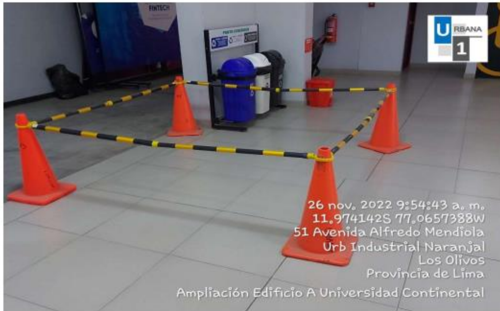
Foto N°17: Colocación de conos y barras retráctiles en sótano.
