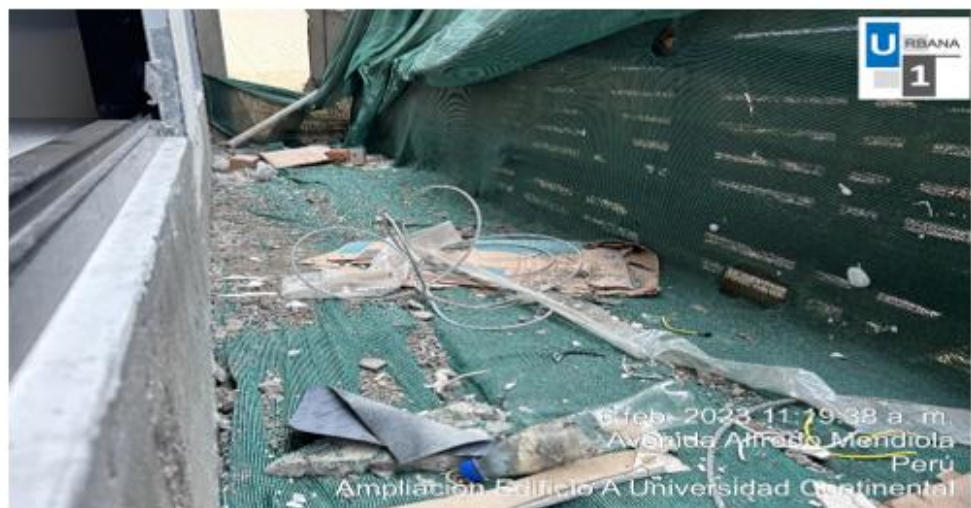
Foto N°3: Inspección de barandas en fachada frontis de la UC
