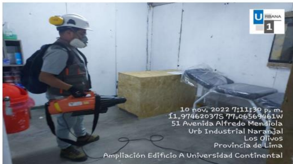
Foto N°15: Desinfección de obra (tópico)
