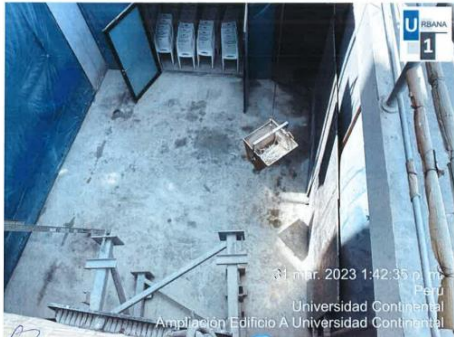
Foto N°14: limpieza final de sótano (base torre grúa)
