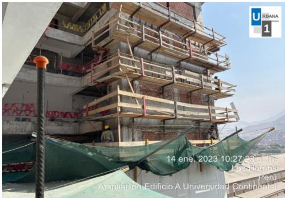
Foto N°19: Acondicionamiento de barandas provisionales en la fachada del edificio.
