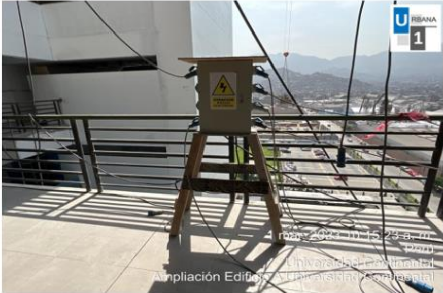
Foto N°2: Inspección de tablero eléctrico.
