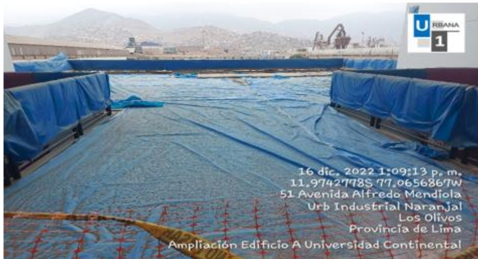
Foto N°9: Limpieza permanente de terraza de la UC.
