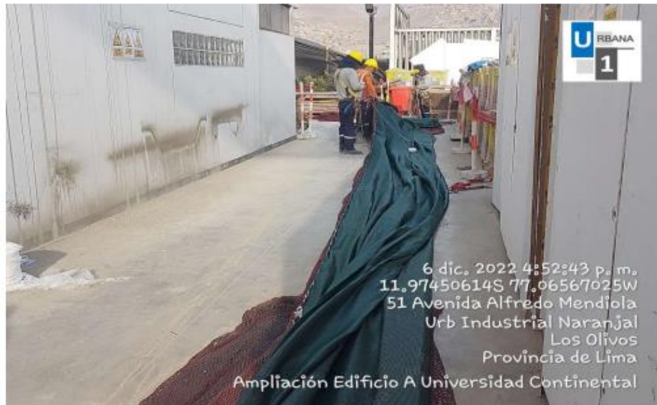
Foto N°8: Colocación de malla anticaídas (segunda corona – piso 11)
