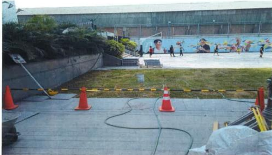
Foto N°13: señalización de tránsito restringido
