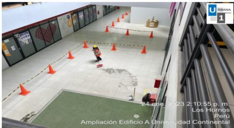
Foto N°21: limpieza diaria del sótano
