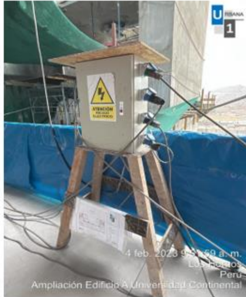
Foto N°6: Inspección de tablero eléctrico piso 7
