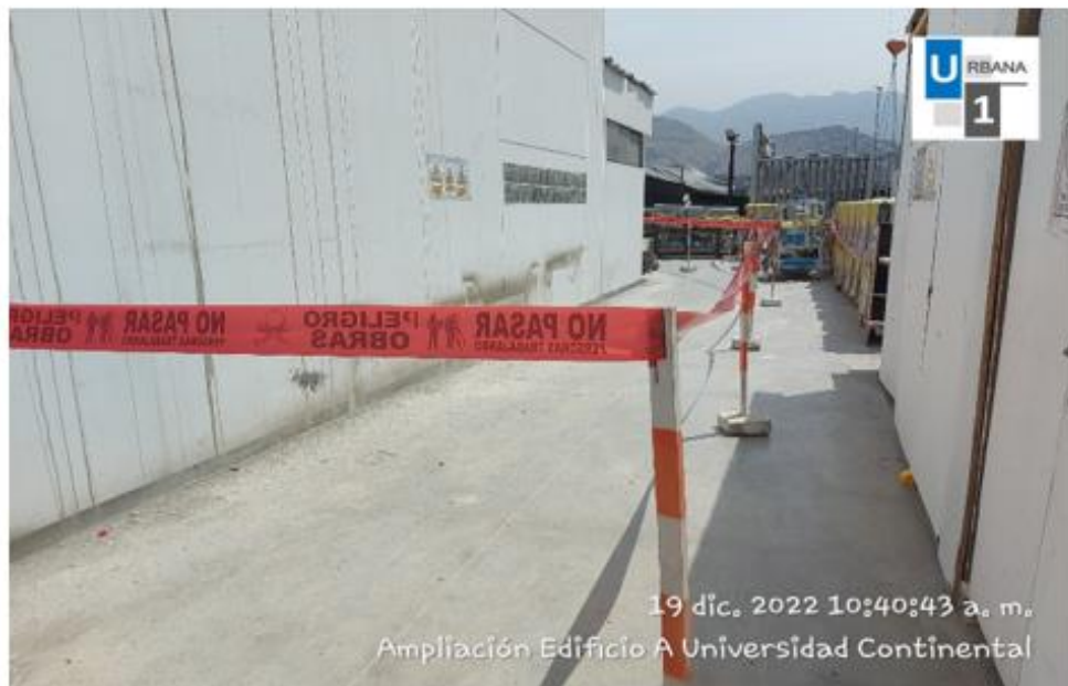
Foto N°13: Delimitación en el primer nivel por la limpieza de mallas en los pisos superiores.
