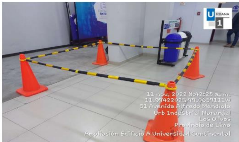
Foto N°17: Delimitación de proyección de ductos en sótano.
