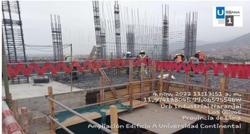
Foto N°8: Colocado de barandas y cinta roja de seguridad en piso 8.
