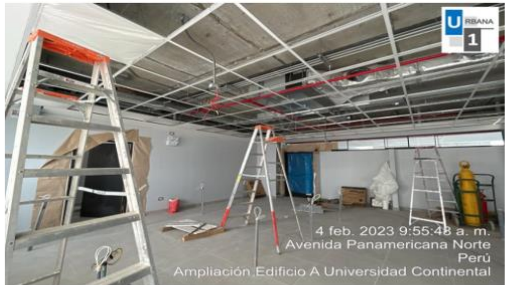
Foto N°1: Inspección de escaleras portátiles
