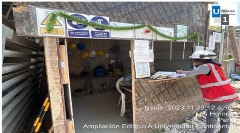
Foto N°15: Inspección de orden y limpieza en obra – primer nivel.
