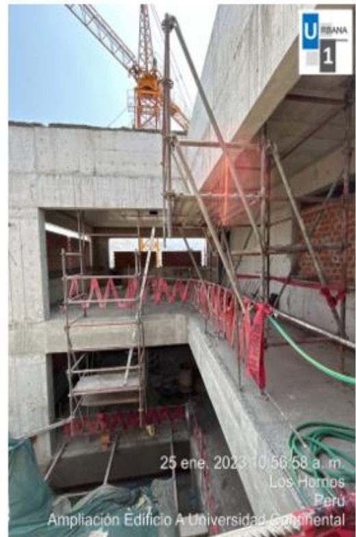
Foto N°2: Inspección andamio piso 11 y 12
