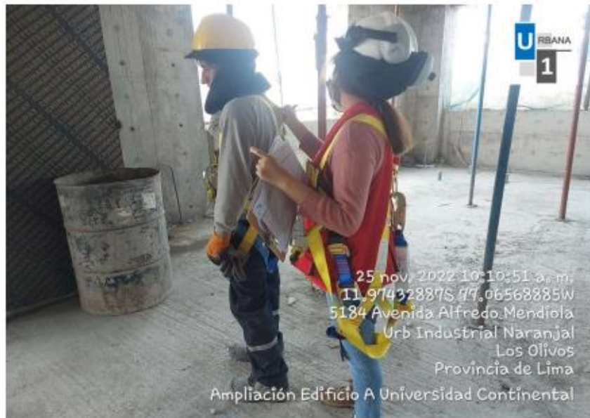
Foto N°3: Inspección de arnés y línea de vida
