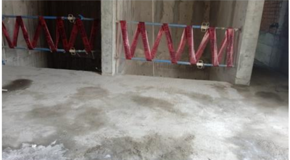
Foto N°7: Verificación de señalización zona de ascensor
