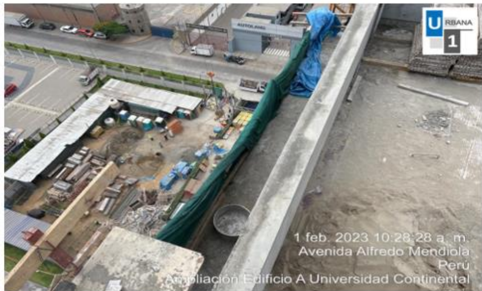
Foto N°5: Inspección de barandas en fachada sector 4 y 5.
