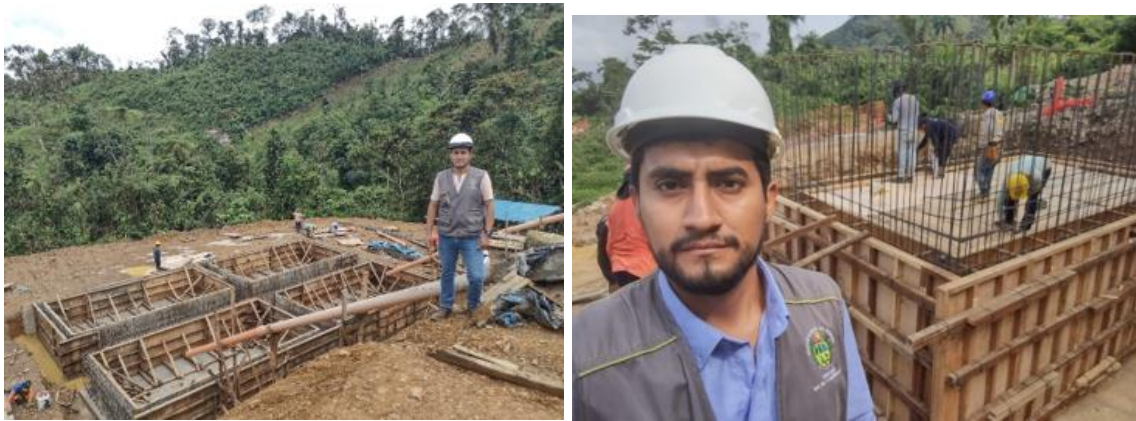
Encofrado de las fuentes de captación
