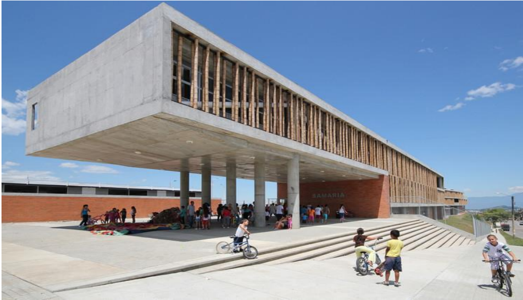
Figura 6: Institución educativa La Samaria (Pereira, Colombia – 2012 – Arq. Campuzana arquitectos). Fuente: Gabriel Campuzano, 2012
