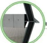
**DETALLE 1:** Anclaje de estructura metálica de columna y viga con loza.
