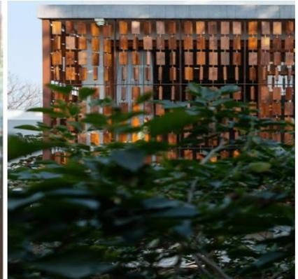
LA COMPOSICIÓN DE ESTE CERRAMIENTO, EN LA CASA DE ÁBACO CON VARILLAS METÁLICAS, CADA PIEZA GIRA. EL CUAL PERMITE TENER UNA FACHADA DINÁMICA.
