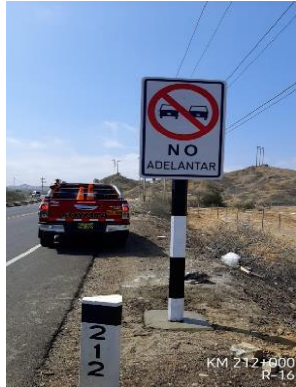
Foto 4 - Colocación de hitos kilométricos
