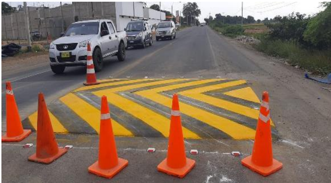
Foto 7 - Construcción de gibas KM 206+070 lado derecho
