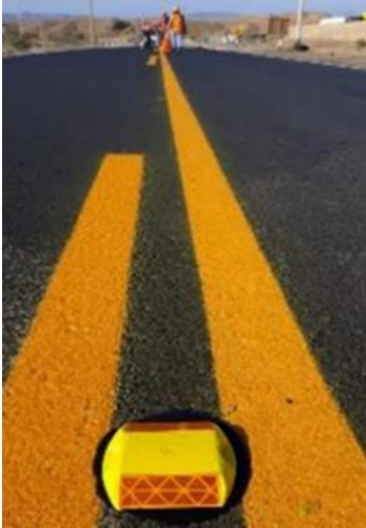
Foto 3 - Pegado de tachas
