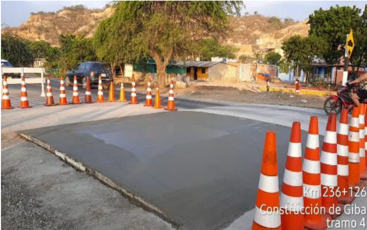
Foto 8 - Construcción de gibas KM 236+126 Tramo 4
