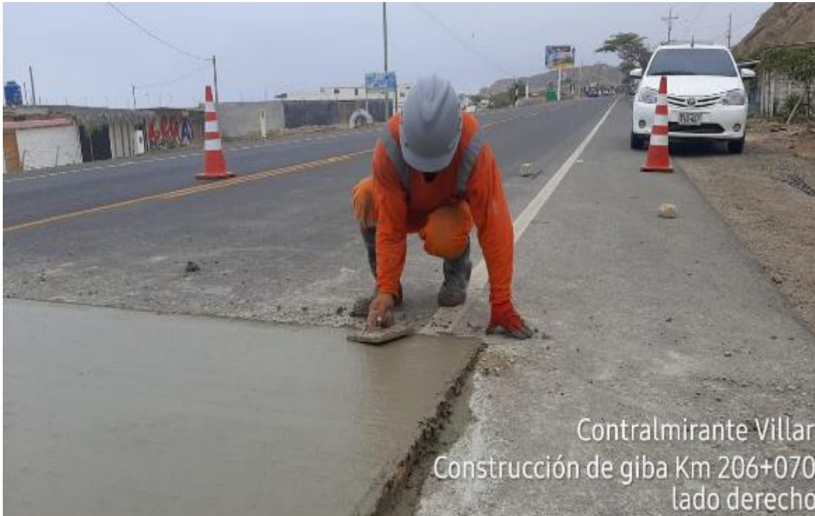
Foto 6 - Construcción de gibas KM 206+070 lado derecho
