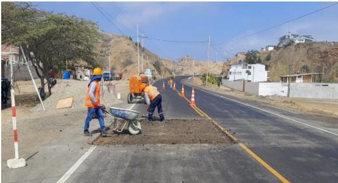
Foto 5 - Construcción de gibas KM 206+070 lado derecho
