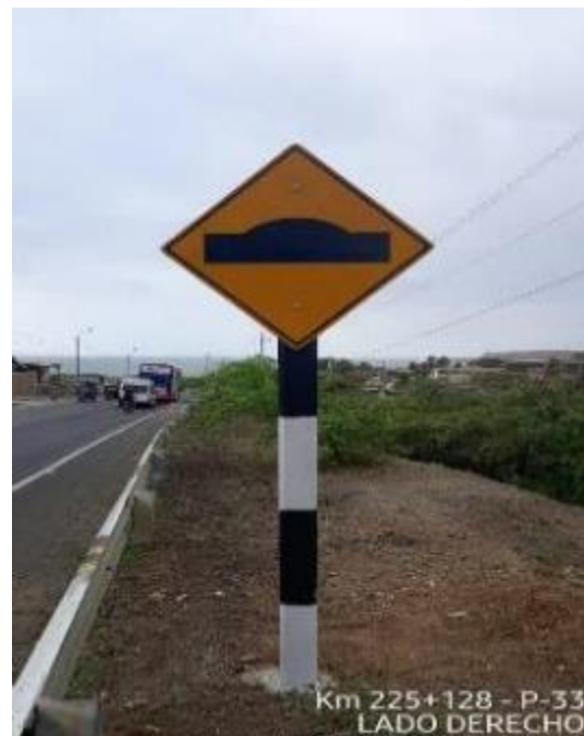
Foto 10 -Reposición de señaléticas KM 225+128
