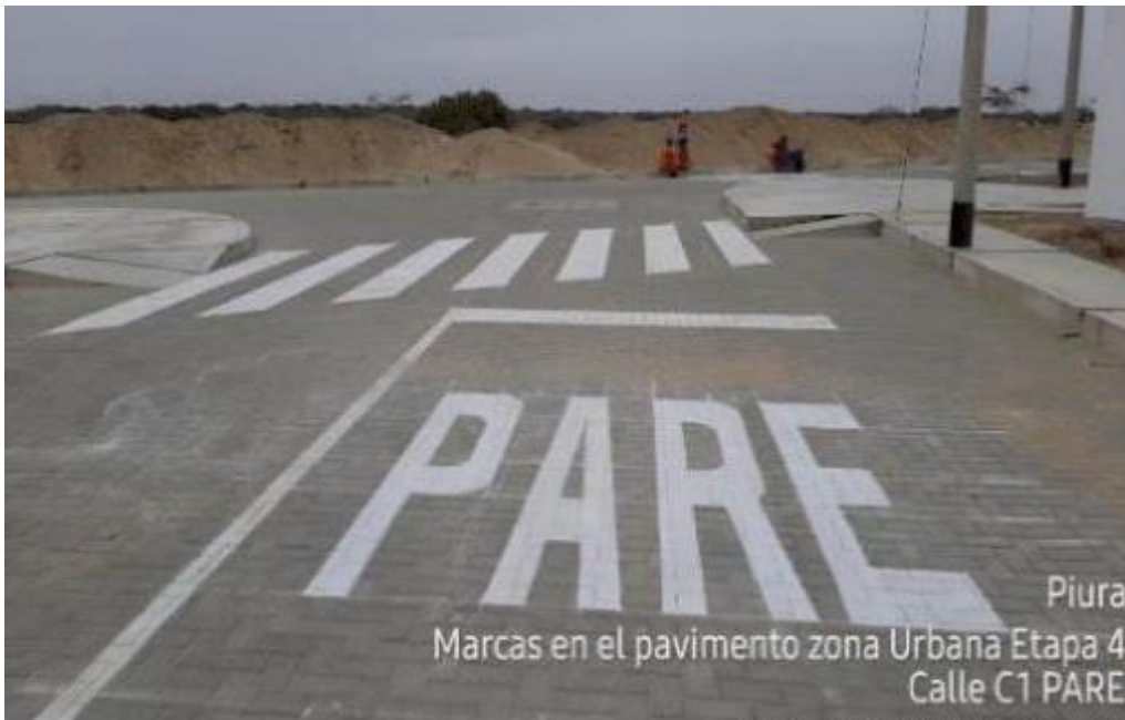
Foto 2 - Marcas en el pavimento zona urbana etapa 4 calle C1 – Piura
