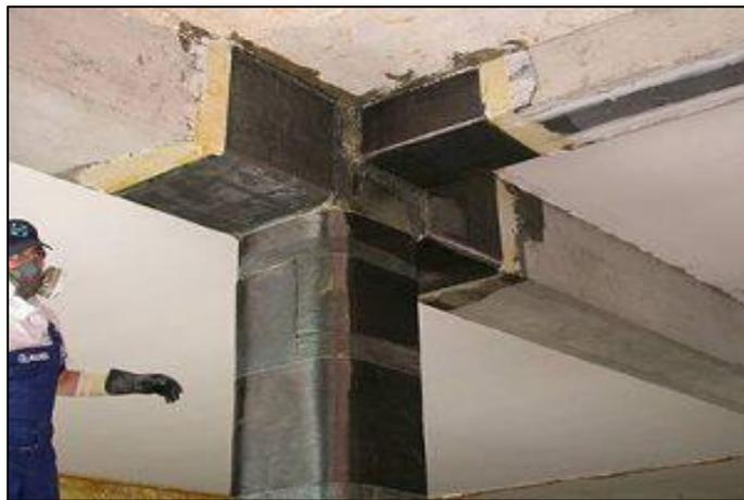
Figura 51. Refuerzo de estructuras con envolturas de FRP
