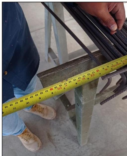
Figura 46: Verificación del gancho en estribos
