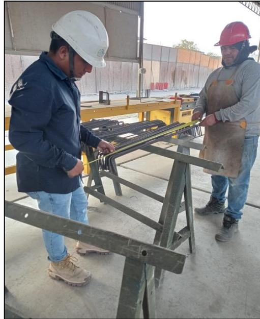
Figura 45: Verificación de la longitud de gancho
