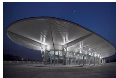
Figura N° 12 Material eficiente de cerramiento de ómnibus de Santiago del Estero.
