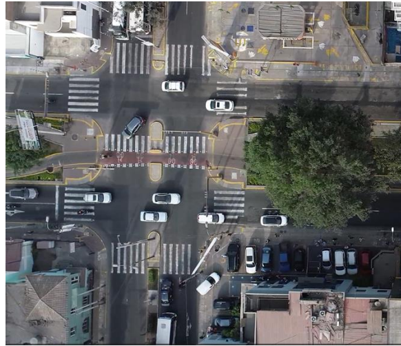
Figura 5 Vista aérea de la intersección entre la Av. Arequipa – Av. Pardo de Zela
