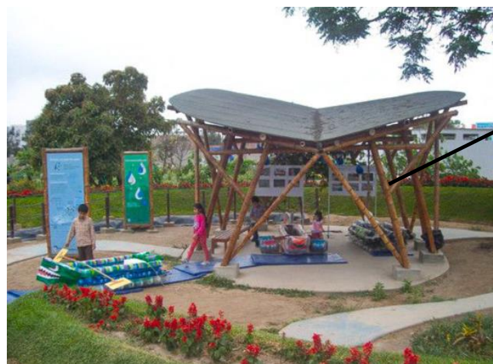
Figura 27: Estructura del CREALIMA Huáscar
