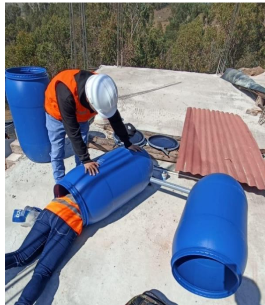
Imagen N° 22: Pegando tubería y posicionando
