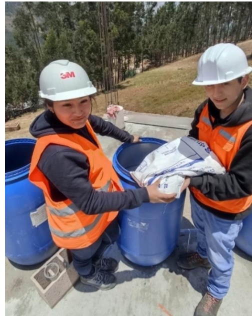
Imagen N° 30: Agregando carbón activado al tercer filtro
