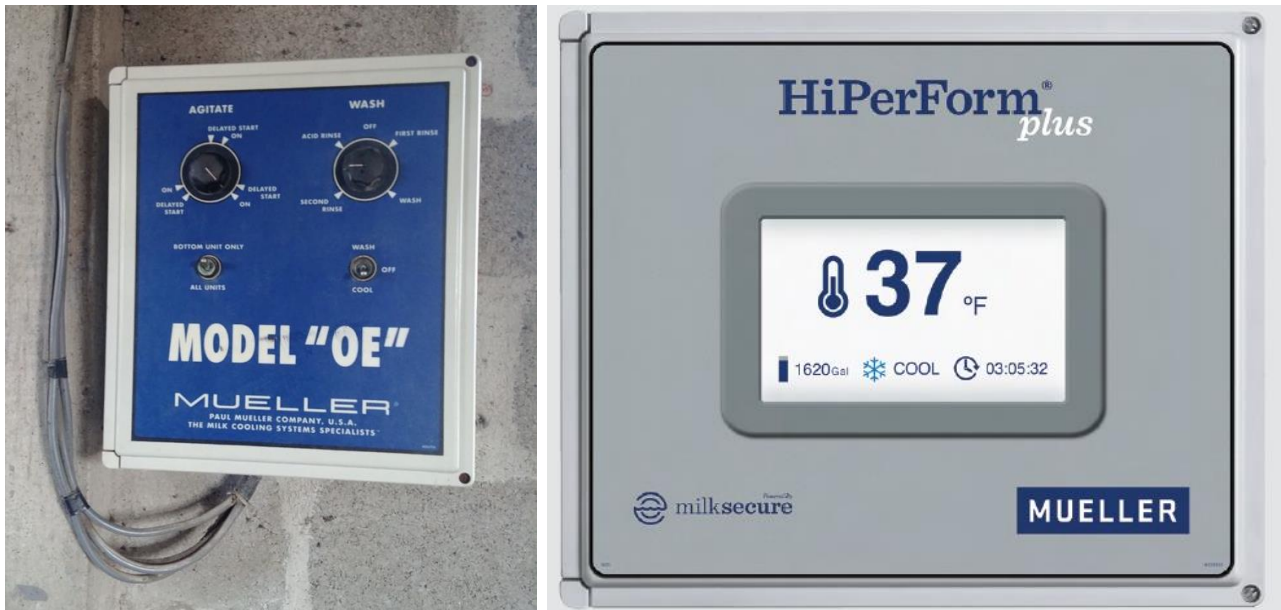
Figura 20. Derecha-Tablero control de temperatura HiPerFormplus propuesto/Izquierdo-Tablero control de temperatura OE actual.
