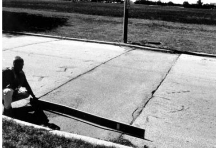
Figura 36 Parqueo y acometidas de servicios públicos de severidad media
