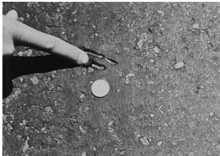
Figura 9 Exudación de severidad media
