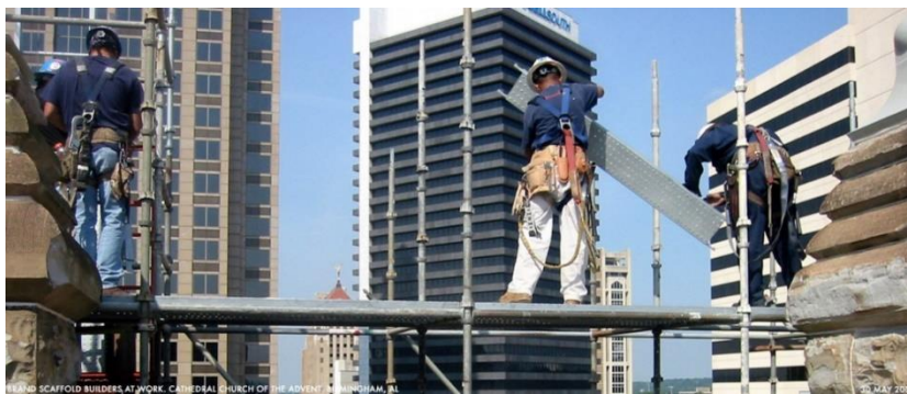
Figura 3. Seguridad en Obra
