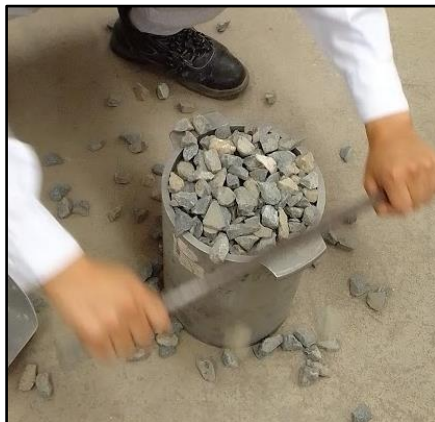
Figura N° 46 Retiro del Exceso del Material
