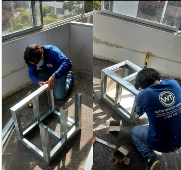
Figura 10: Fabricación de módulos de Drywall
