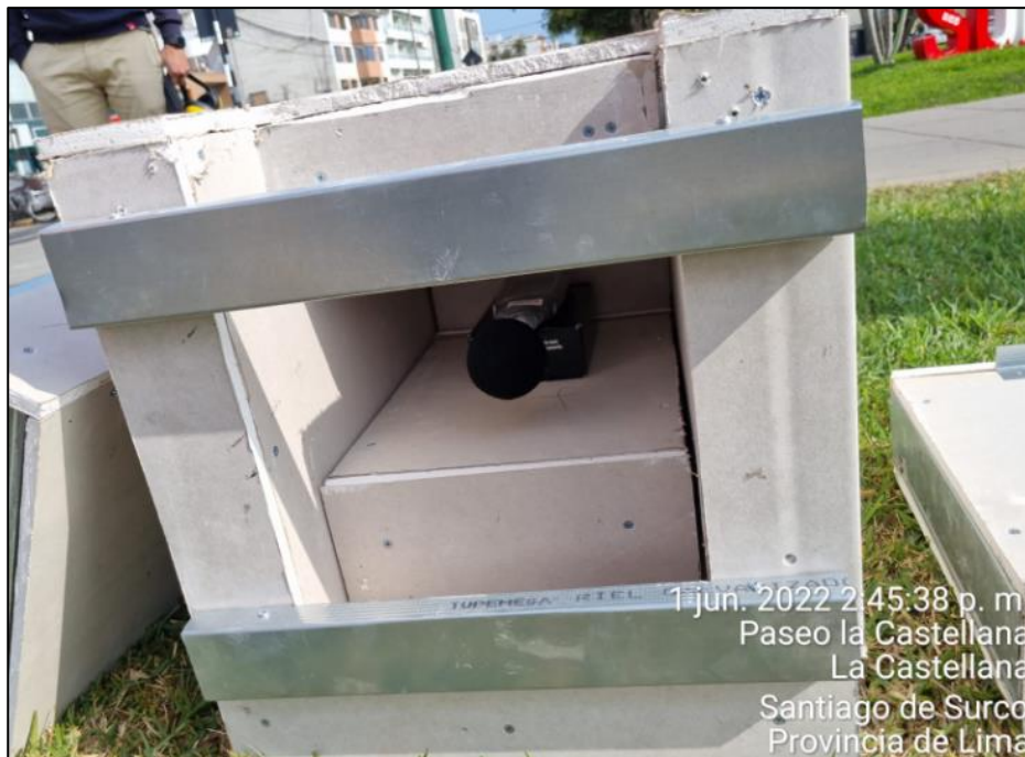
Figura 15: Instalación de sonómetro en tabique de Drywall tipo estándar
