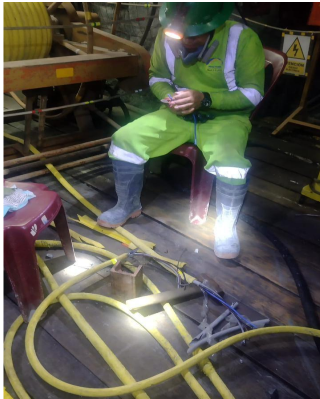
Foto 02: Tamboras e instalación del cable electro para el equipo Alimak y Alicab
