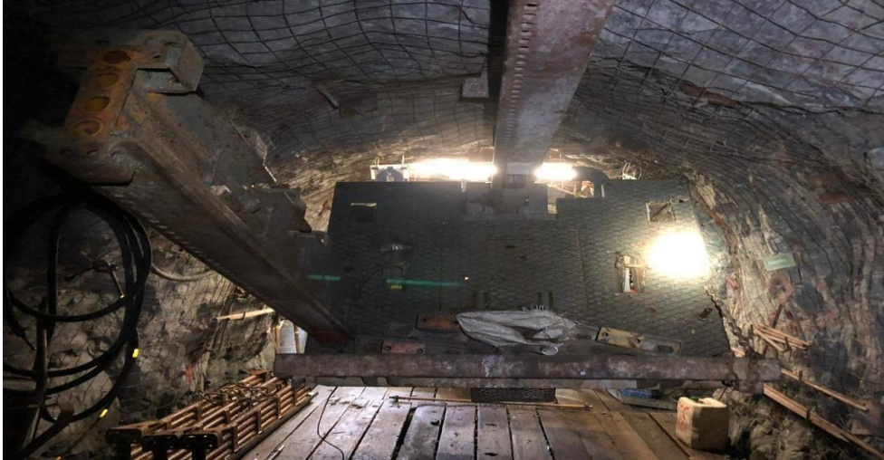
Foto 04: Equipo Alimak en la que los trabajadores suben a la chimenea
