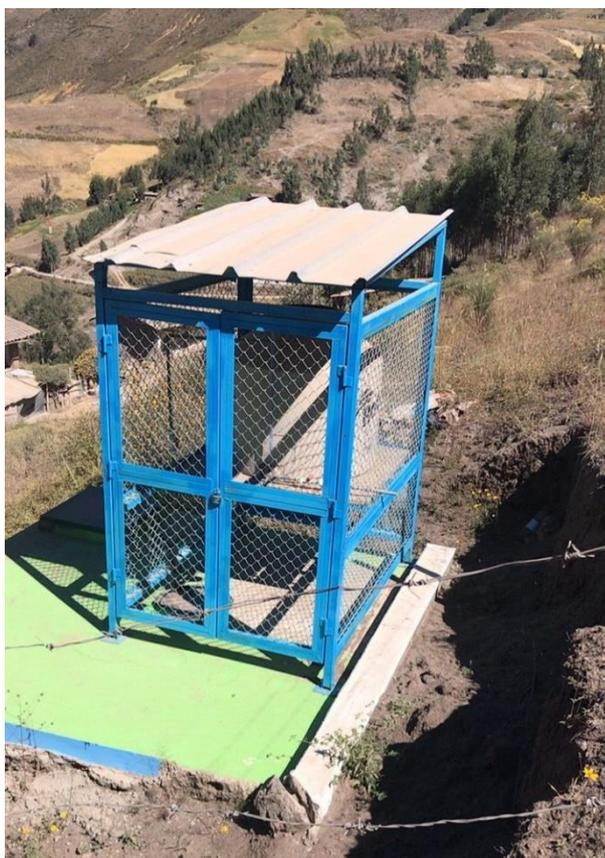
*Ilustración 2: Tanque del sistema de agua potable*
