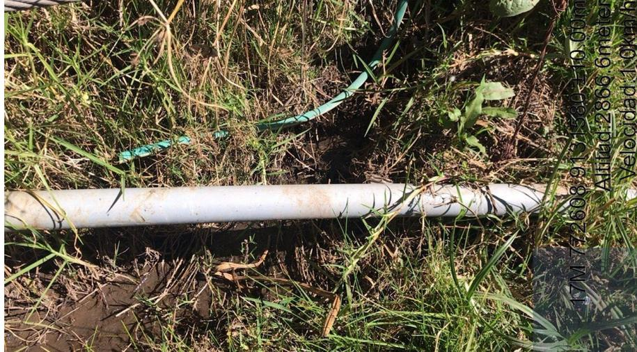
*Nota:* En la Figura 4, observamos un tramo de tubería PVC expuesta que forma parte de la línea de conducción de la red existente en el Sector La Pampa - Huangamarca. Fuente: Elaboración propia.
