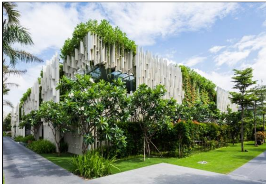
Figura 02: Vista general de proyecto
