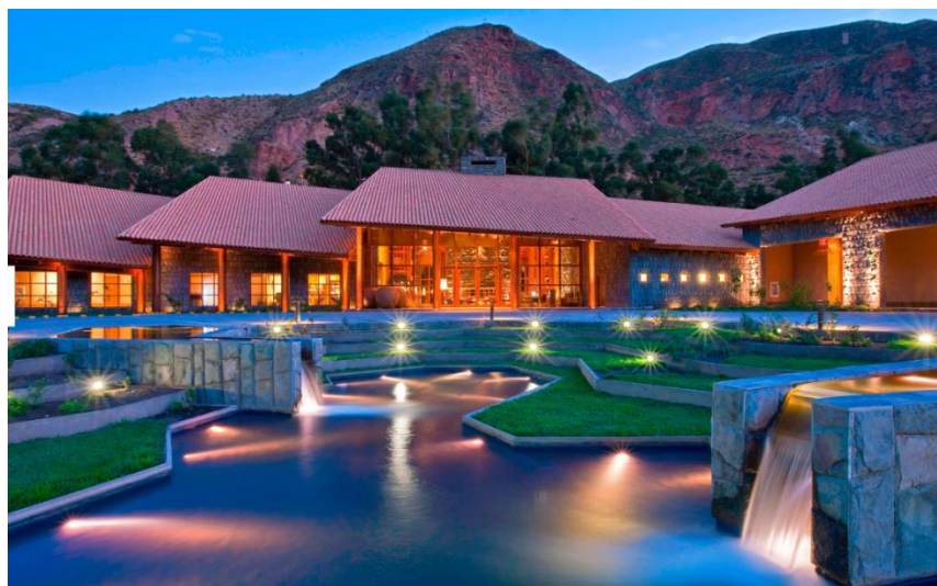
Figura 06: Vista general de proyecto
