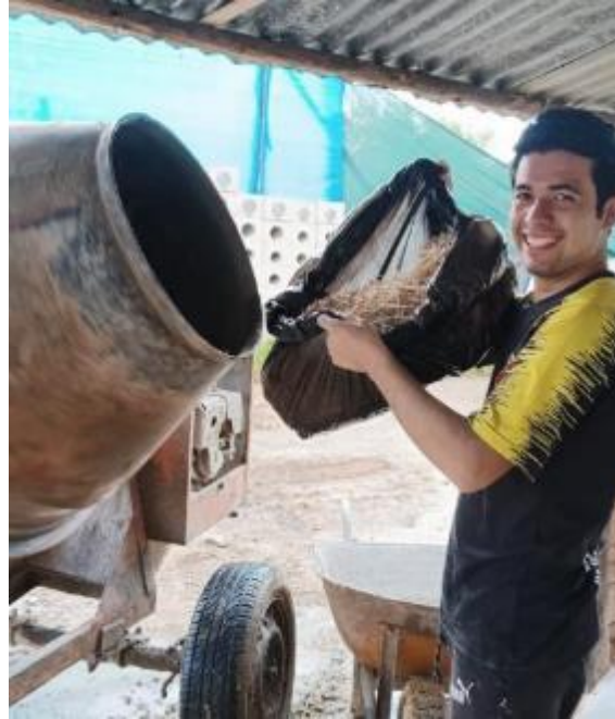
Figura 42 Adición de fibra de polipropileno a la mezcla
