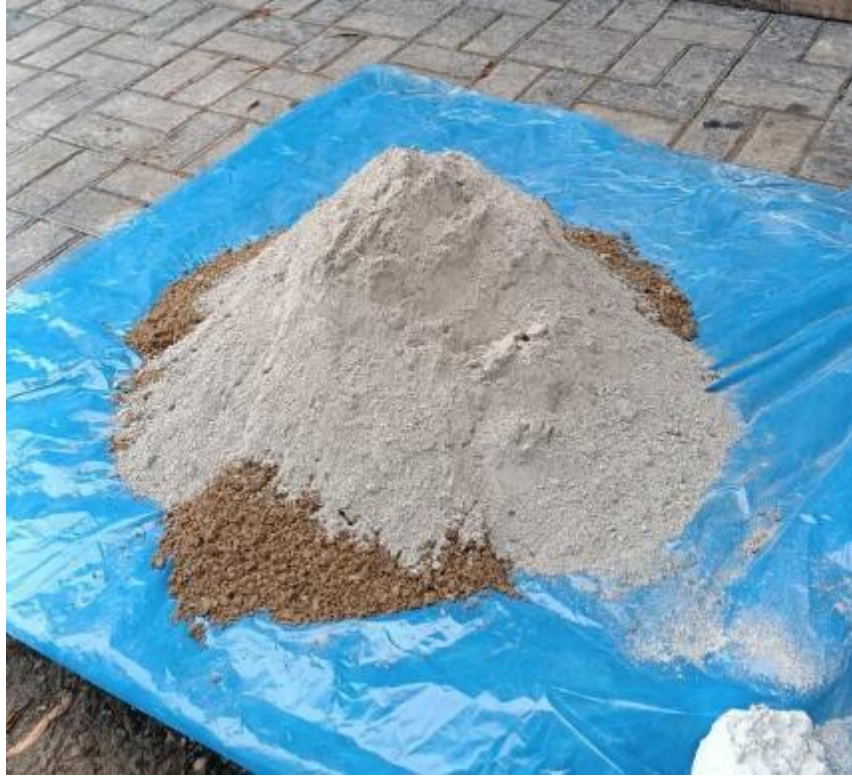
Figura 52 Preparado de mortero
