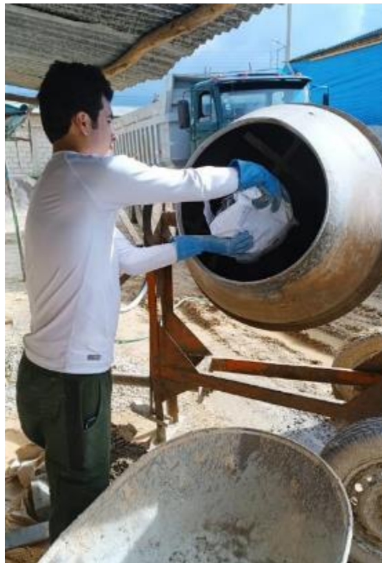
Figura 42 Adición de fibra de polipropileno a la mezcla
