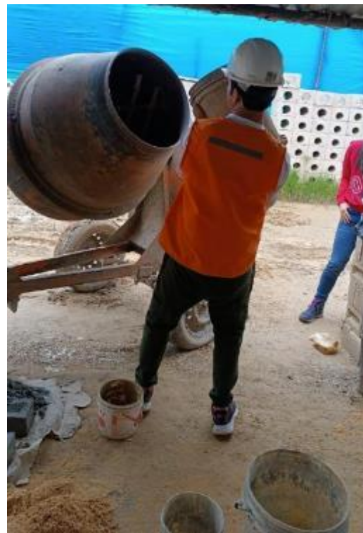
Figura 40 Preparado de la mezcla para cada porcentaje de fibra
