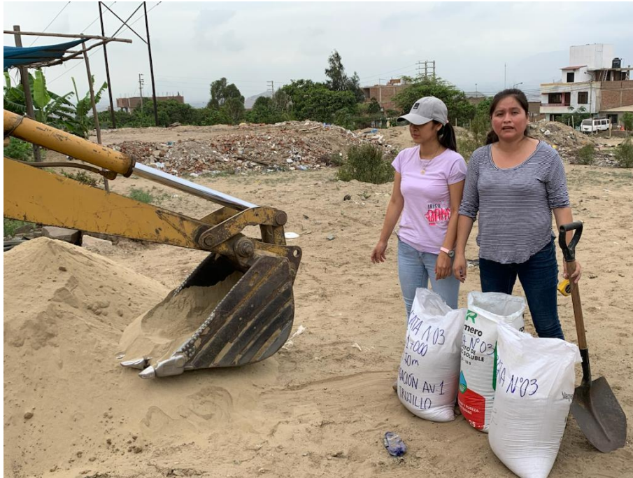
Extracción de muestras de la Calicata N° 03 en la progresiva Km 1+000
