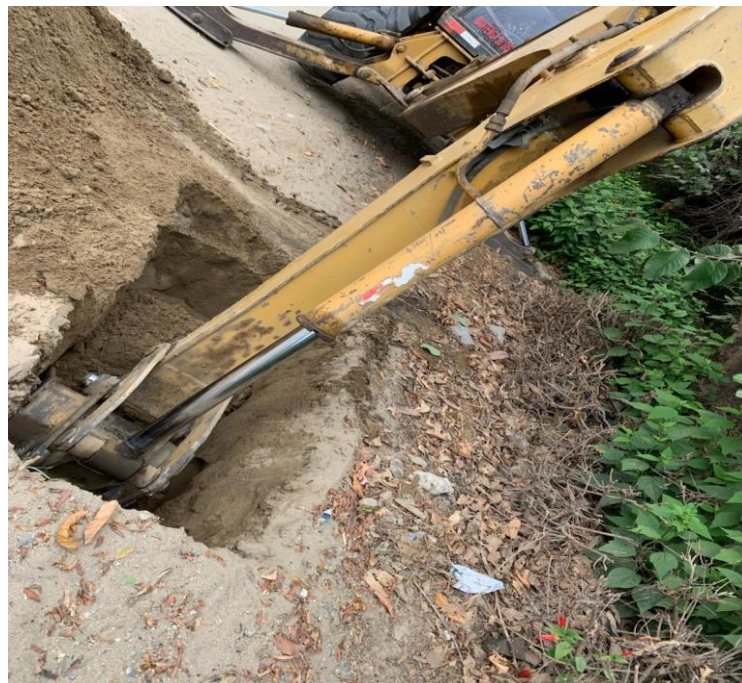
Excavación de material la calicata N° 04 en la progresiva Km 1+500
