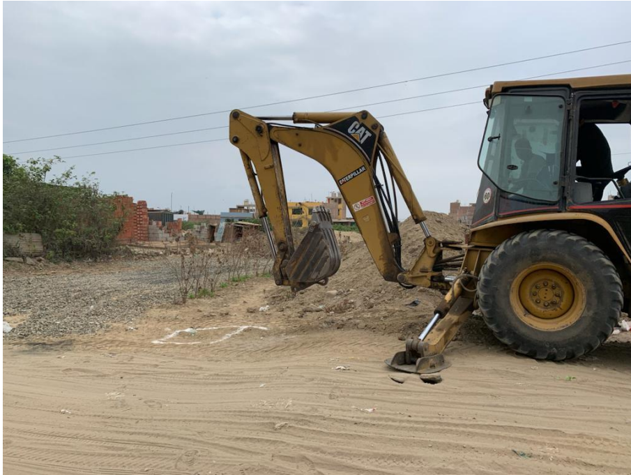
Trazo de dimensiones a excavar de la Calicata N° 05 en la progresiva Km 2+000
