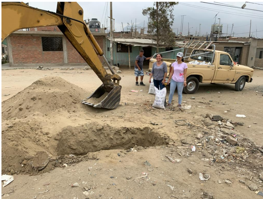
Excavación y extracción de muestras de la Calicata N° 08 en la progresiva Km 3+700
