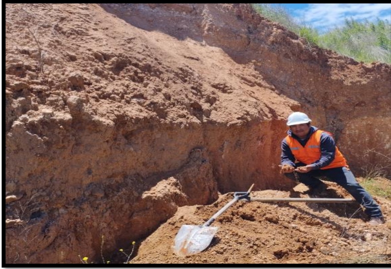
Fotografía N°02: Recojo de tierra de cantera La Victoria- Llacanora.
