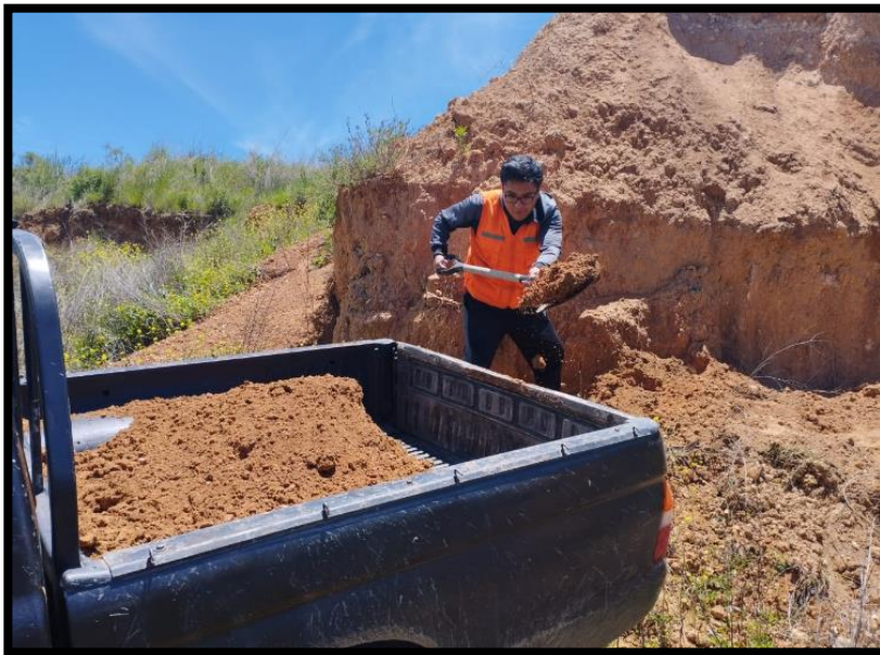
Fotografía N°01: Recojo de tierra de cantera La Victoria- Llacanora.
