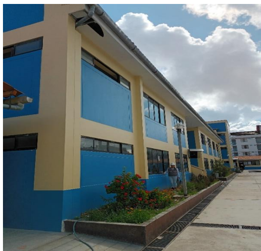
Nota. Panel fotográfico vista bloque 1 exterior
