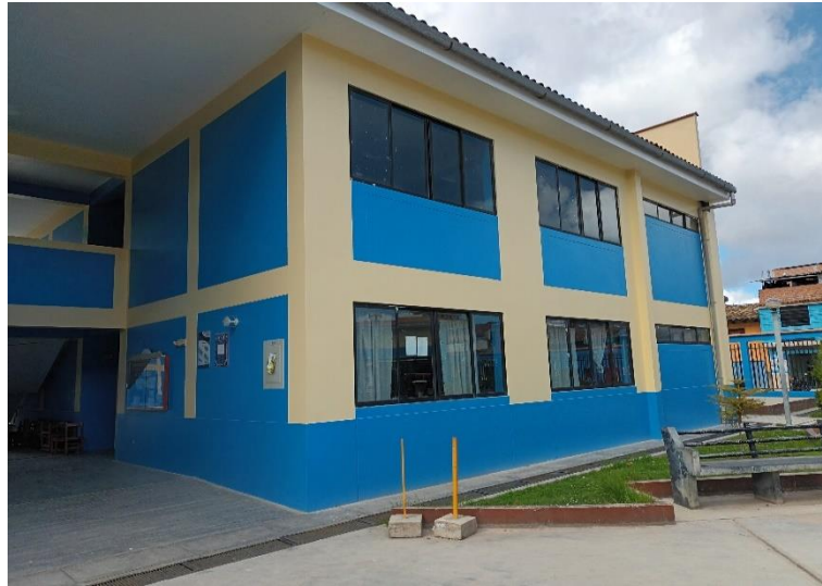
Nota. Panel fotográfico bloque 1 parte exterior frontal
