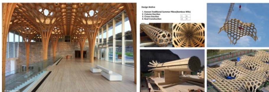
Figura N° 22. Lineamiento en estructura arquitectónica 2. Fuente: Espacios de madera.
