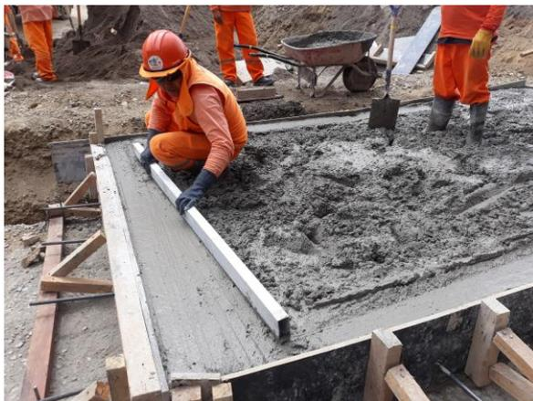
**Nota:** se realizó el vaciado de concreto sobre la malla ya puesta en el área del paño para proceder a los retoques finales q son reglados del paño.
