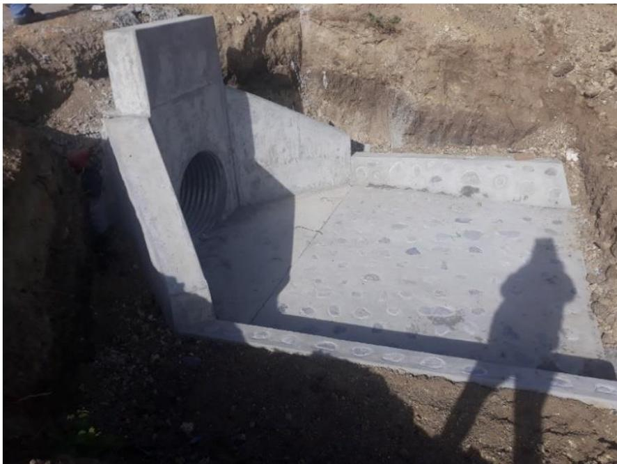
**Nota:** se aprecia la salida del emboquillado de la alcantarilla ya terminada en un tramo de 36”.
