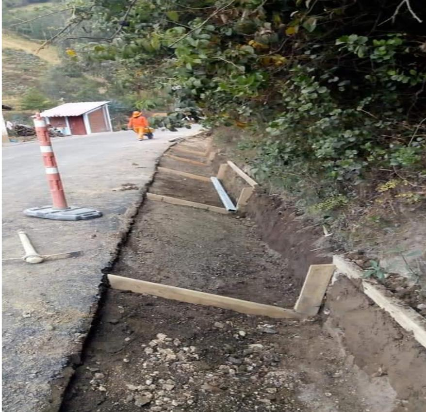
*Nota:* se aprecia el cerchado listo para iniciar con los vaciados luego de realizar las compactaciones y los perfilados.
