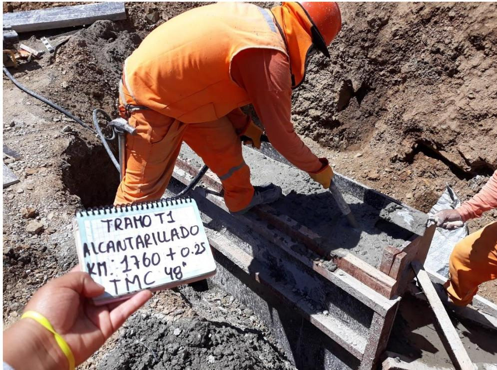
*Nota:* en esta figura mostramos nuestro vaciado de concreto en el km: 176+0.25 con un tmc de 48”, apreciamos que también usamos la vibración para poder tener mejores resultados y no dejar vacíos en el vaciado del concreto.
