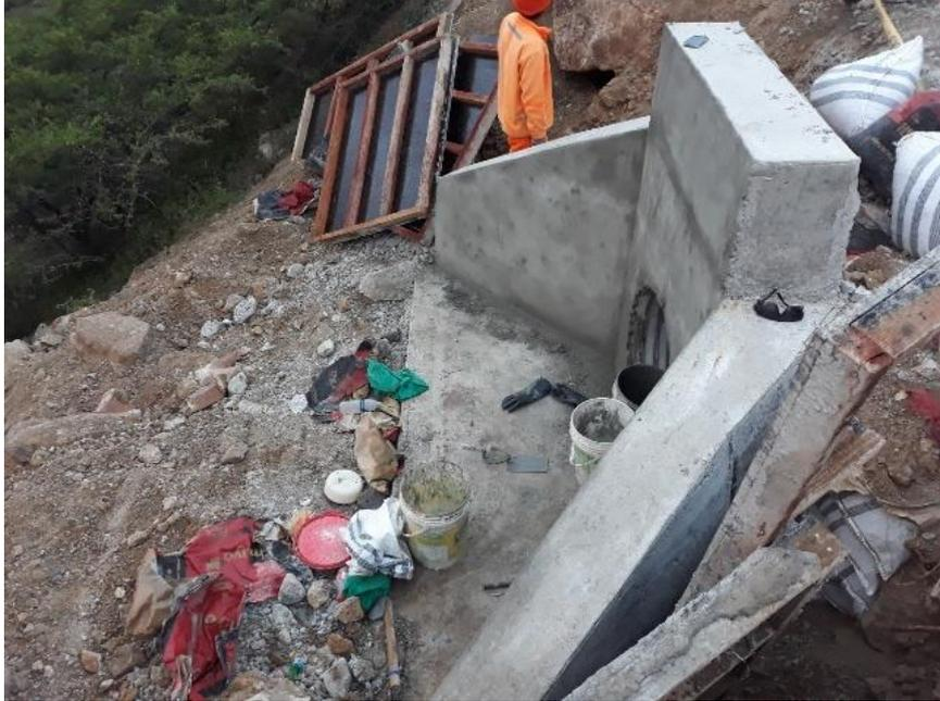
*Nota:* desenfofrado de alero se aprecia que quedo muy bien sin tener ningún vacío de concreto durante el vaciado se usó un vibrador para poder llenar cualquier aire que quede acumulado
