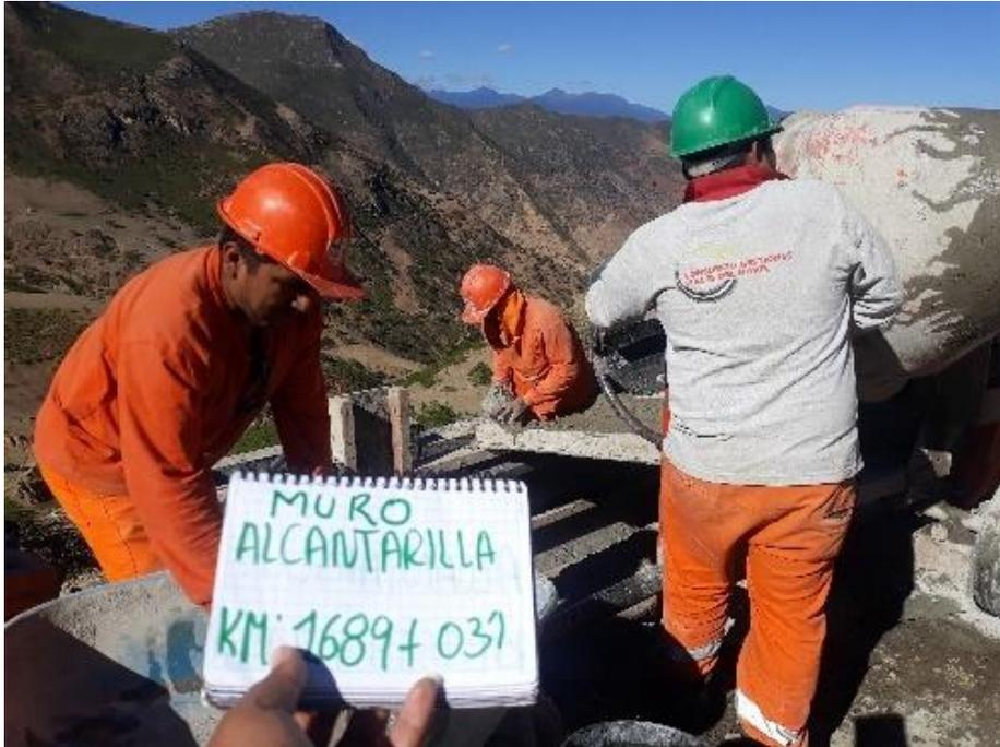
*Nota:* vaciado de concreto para los aleros y cajas de entrada y salida de las alcantarillas
