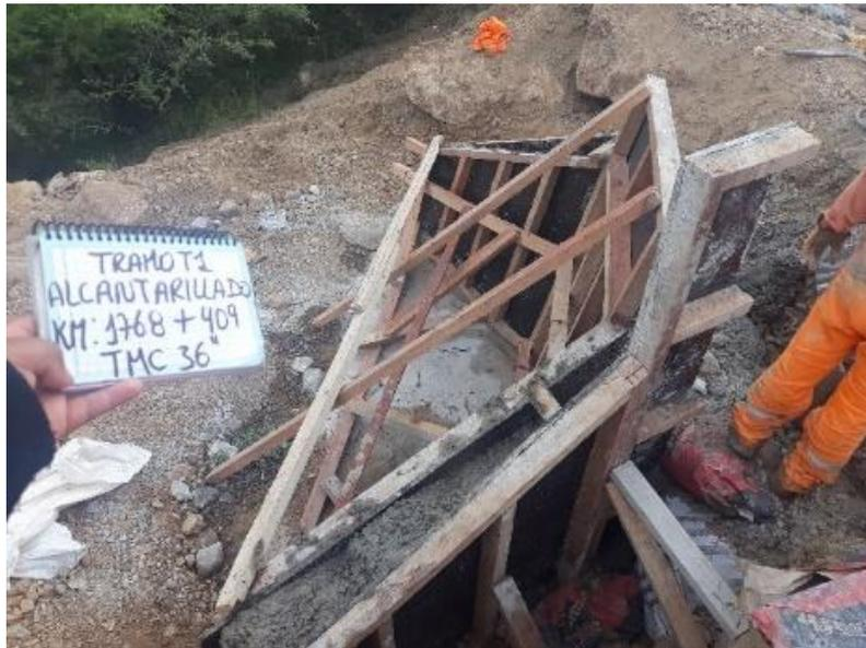
**Nota:** encofrado de la entrada y salida de las alcantarillas, en lagunas se usaron cajas de entradas y en otros casos se usaron en ambos extremos aleros.
