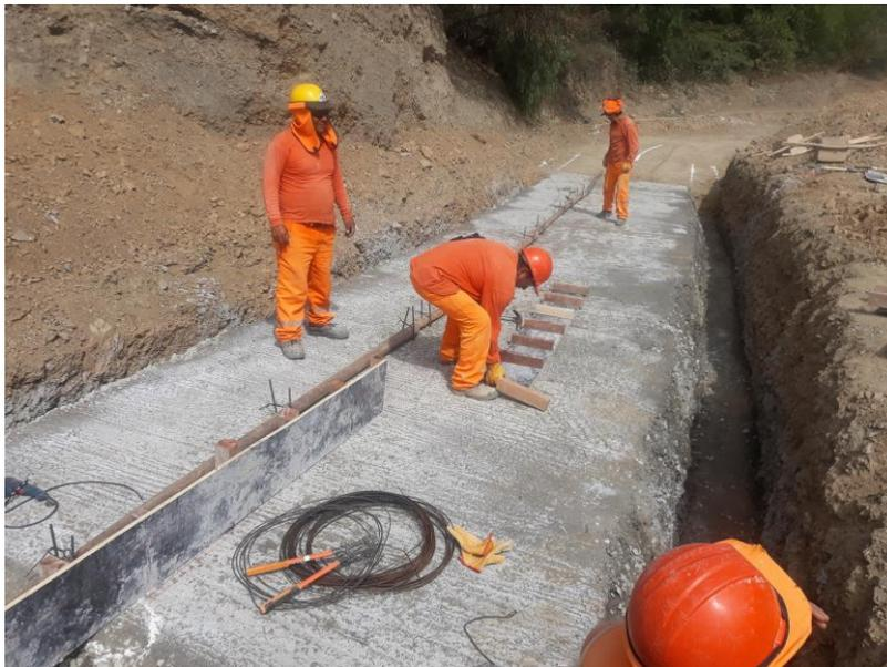
**Nota:** Se realizo el vaciado de solado f’c 100kg/cm2. Del km.2036+782.5- km. 2036+797.5. con una longitud de 15 metros.
