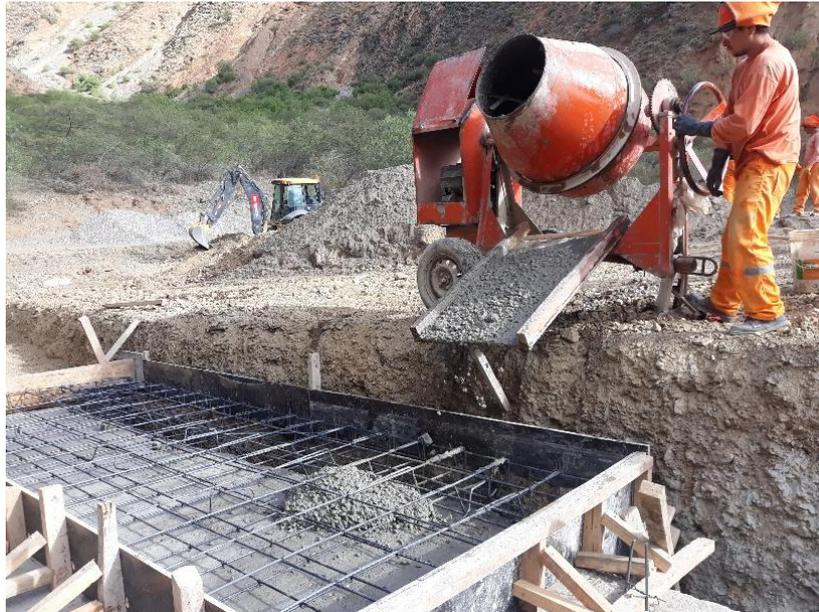
**Nota:** se realizó los vaciados de concreto en cada paño, realizando vibraciones en toda el área para que no quede vacío de aire y no tener ningún inconveniente luego con su capacidad.
