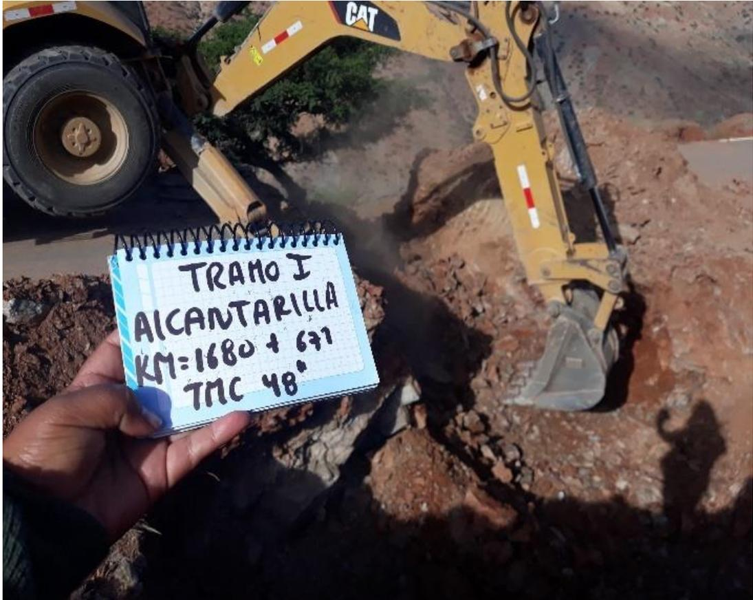
*Nota:* En esta figura podemos apreciar como se realiza la excavación para poder proceder con las compactaciones y las medidas de acuerdo a los puntos topográficos como también a las medidas que nos indica cada plano.
