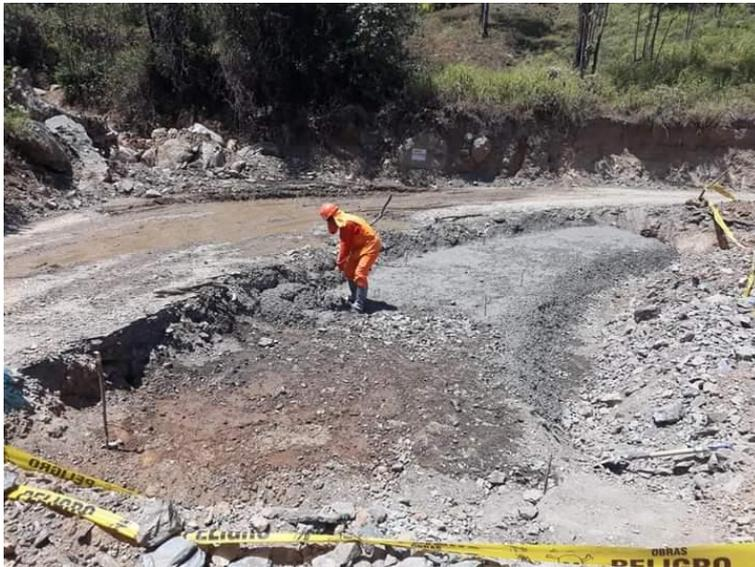
Nota: aplicamos el solado f'c 100kg/cm, en la parte de la plataforma donde va las mallas.
