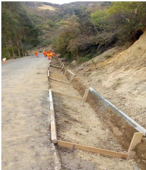
*Nota:* En esta imagen se muestra el trabajo desarrollado en perfilación y compactación de cada paño para poder sucesivamente realizar los vaciados de concreto
