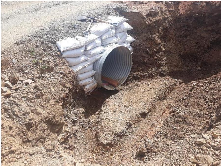
*Nota:* En esta figura tenemos una pequeña muestra de la excavación de uña con unas medidas de 0.30cm \* 0.40 cm.
