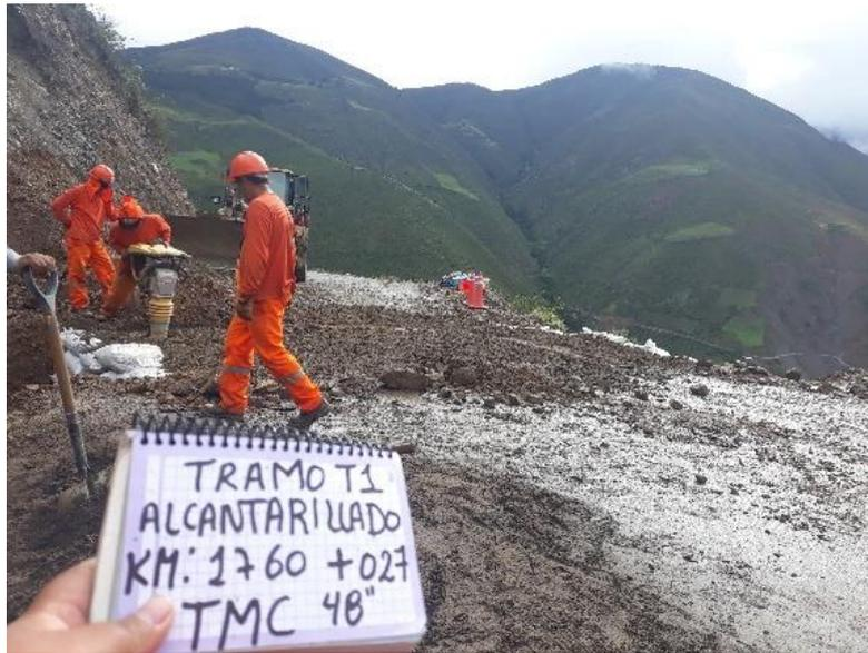
*Nota:* en esta figura justamente se está compactando la parte final de la corona de la alcantarilla hasta el nivel de la giba o nivel de trocha.
