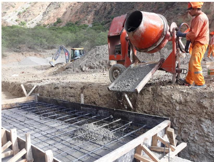
*Nota:* Se realizó el vaciado de concreto luego de a ver clocado correctamente la malla de acero siempre sobre la plataforma que estaba ya vaciado con el solado, tener en cuneta q las mallas tienen los dados de 0.5 cm, para los recubrimientos a la hora de hacer los vaciados.
