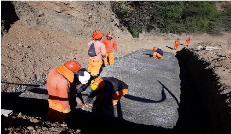
*Nota:* en esta figura apreciamos que se realizó el vaciado de solado en la parte de donde su ubica la malla de acero.
