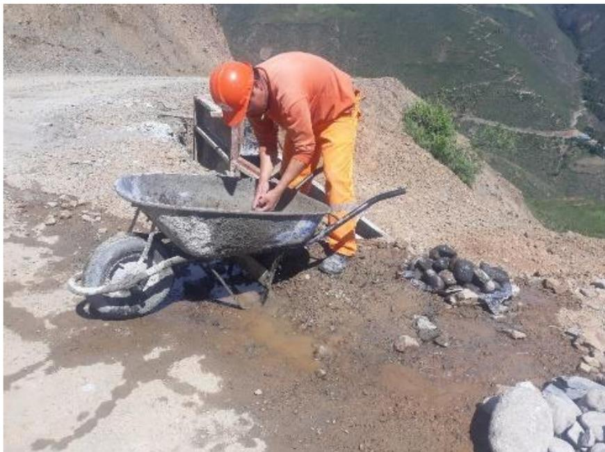
**Nota:** en esta figura mostramos como estamos lavando las piedras para tener un buen diseño de emboquillado
