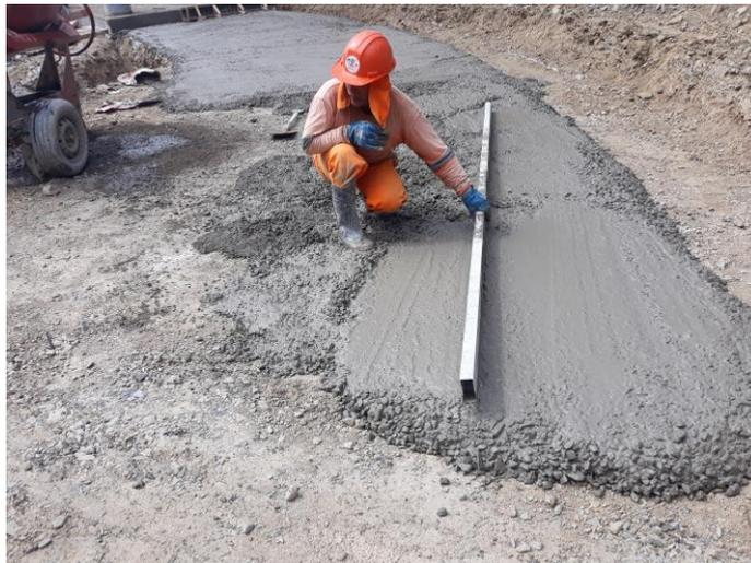
**Nota:** vaciado de solado en la plataforma de donde va ubicado la malla de acero.
