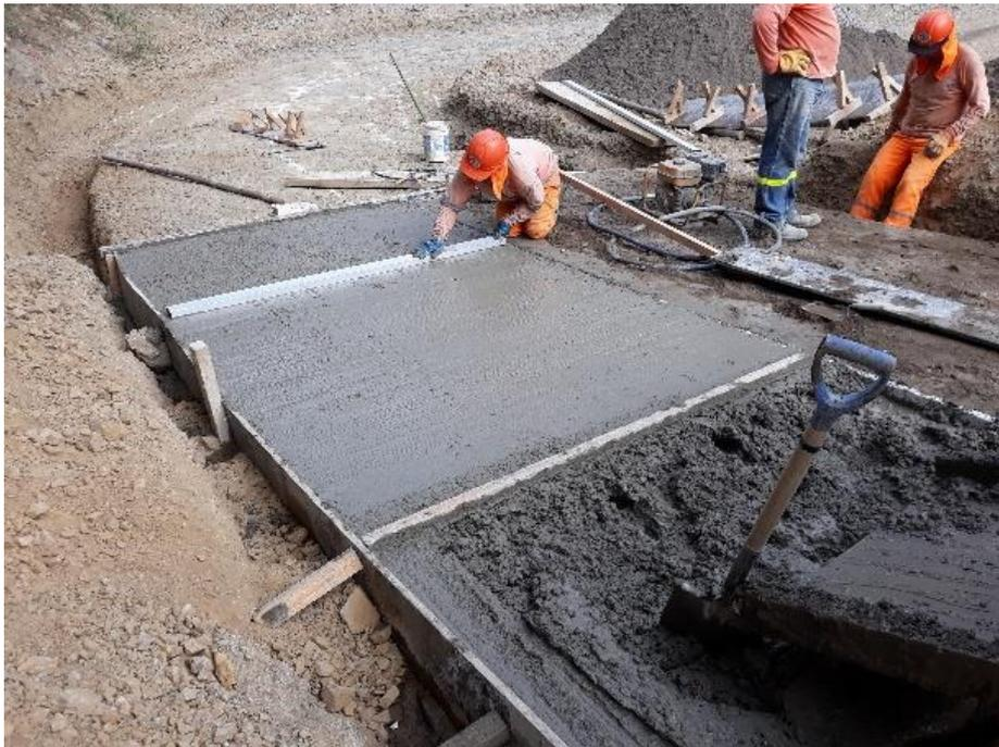
**Nota:** en esta figura se aprecia el proceso constructivo del vaciado de concreto en los paños del baden.
