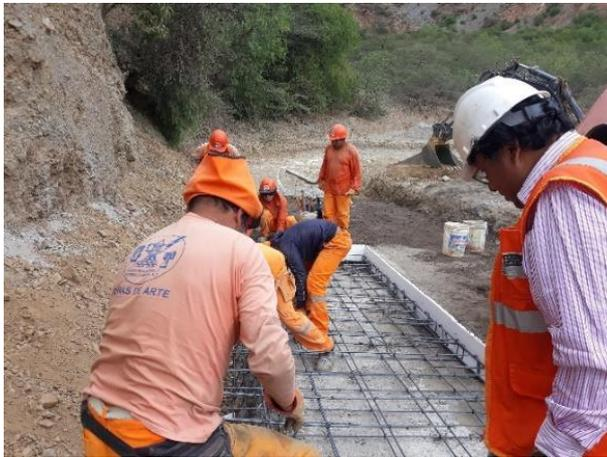
**Nota:** colocacion de la malla en cada paño para luego colocar los dados , realizar las nivelaciones para finalizar con los vaciado de concreto.
