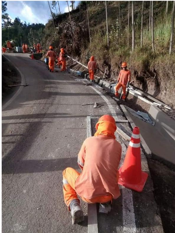
Nota: En esta imagen mostramos uno de los avances diarios como es el vaciado de concreto de acuerdo a las especificaciones técnicas, usando un concreto f'c 175 kg/cm<sup>2</sup>.
