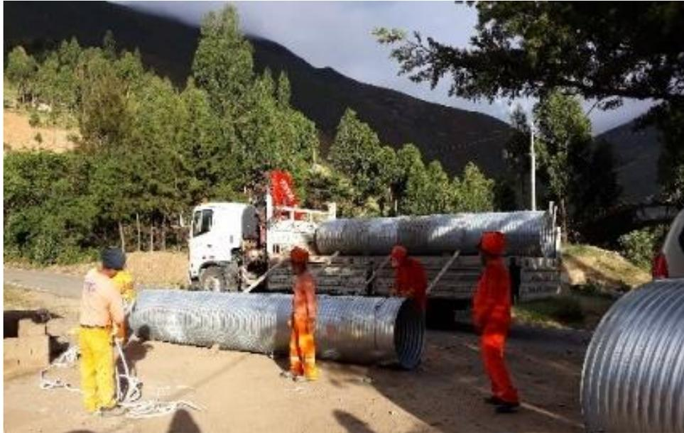
*Nota:* En esta figura demostramos el armado de nuestros TMC de 36” y 48”, teniendo un lugar adecuado y amplio para hacer el trabajo de armar cada lamina de tmc.
