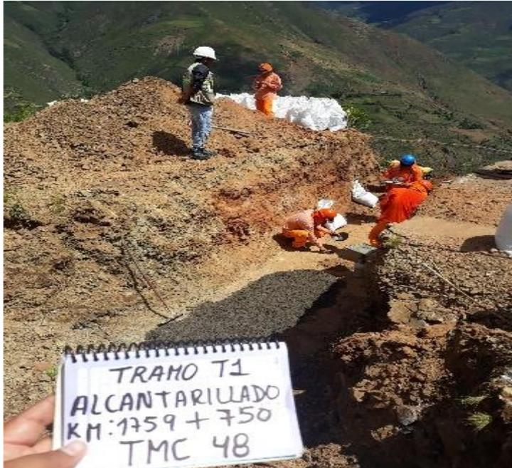
*Nota:* se aprecia la colocación de cama arena previo a eso se realiza el análisis de suelos, en este caso aplicamos una capa de arena de 10cm como nos indica las tablas del plano.
