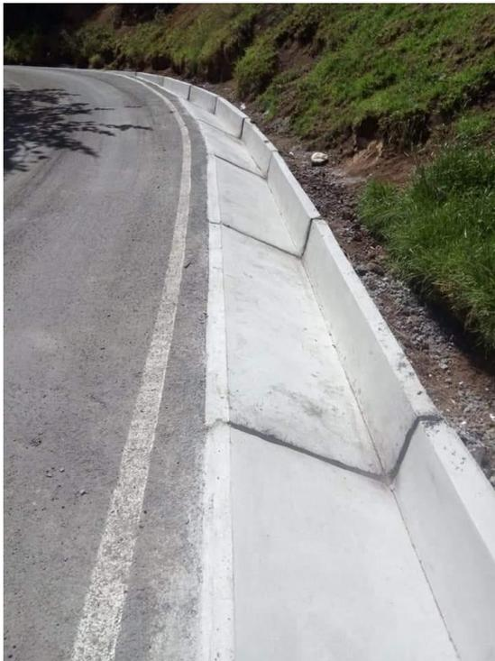
**Nota:** Apreciamos los resultados de nuestro proyecto de cunetas el cual esta terminado con las juntas de relleno mastic asphaltico.
