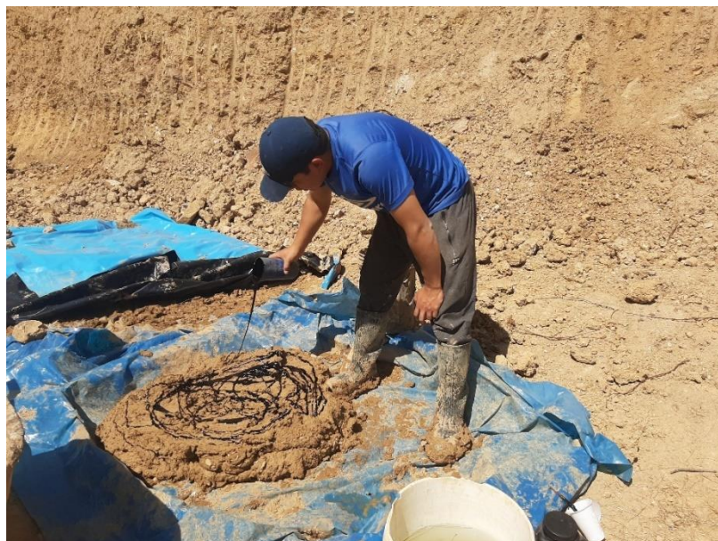
Adición de emulsión asfáltica al barro.
