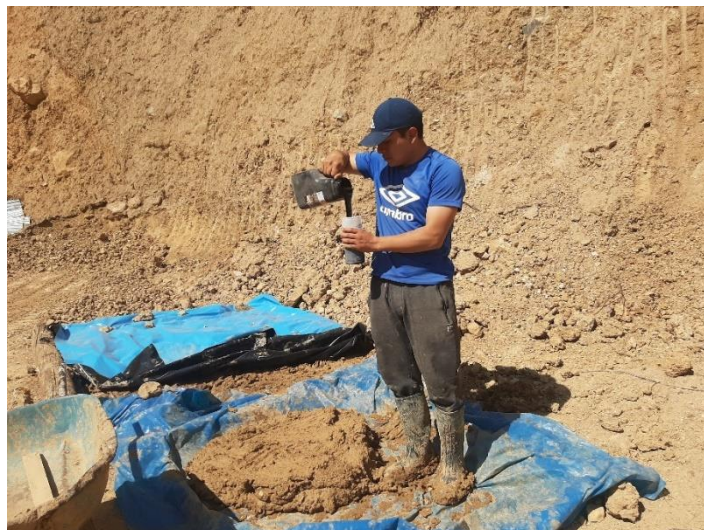
Midiendo dosificación de emulsión asfáltica.
