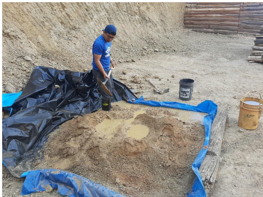
Agregando agua a la mezcla.
