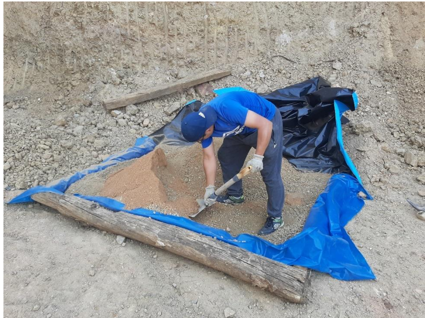
Preparación de tierra para adobes.
