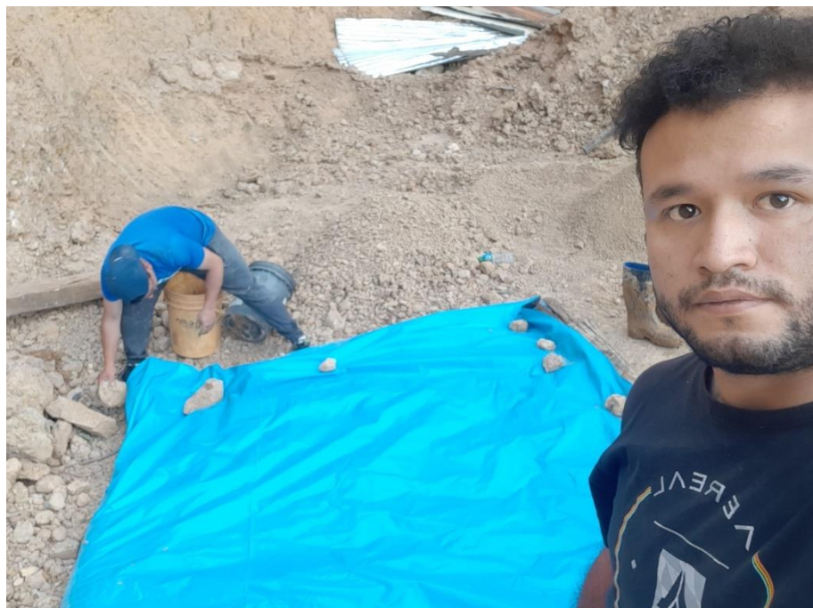
Cubriendo la mezcla para dejarla reposar 24 horas.
