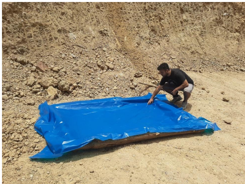
Preparación de superficie para elaboración de mezcla.
