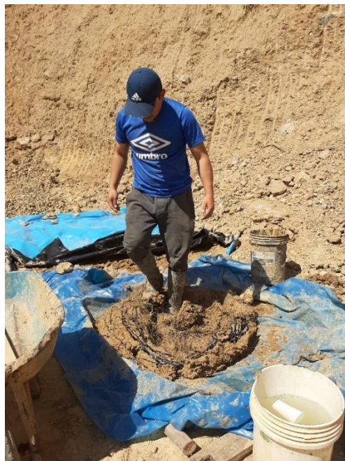
Integración del barro, emulsión asfáltica y paja.
