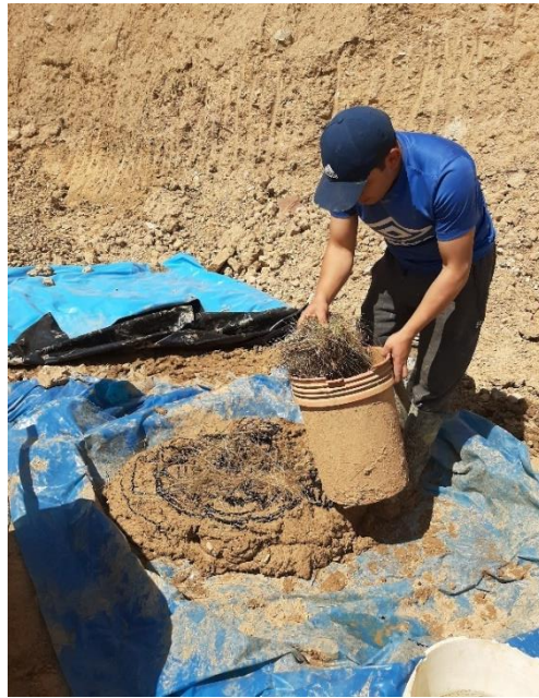
Adición de paja a la mezcla con emulsión asfáltica.
