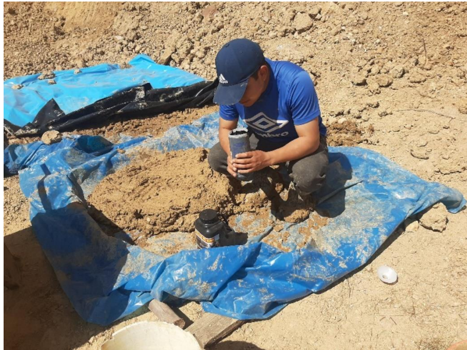
Emulsión medida para incorporarla a la mezcla de barro.
