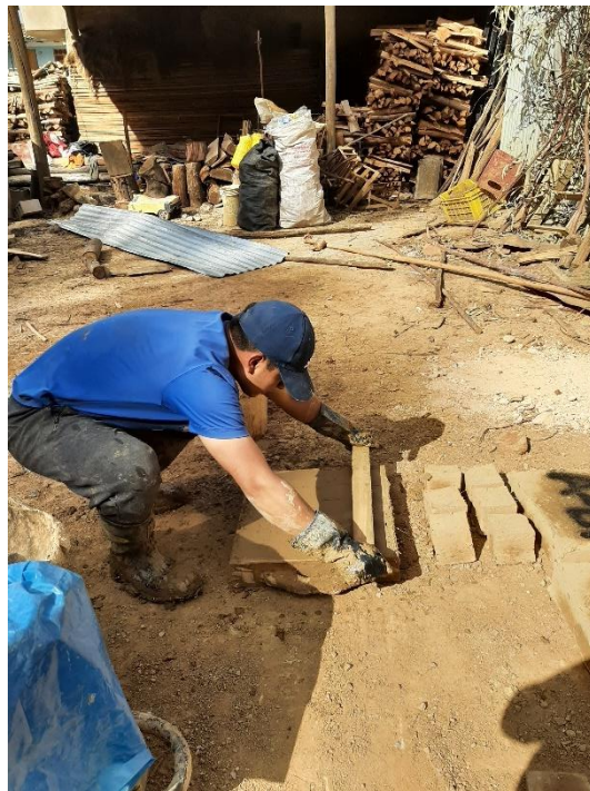
Nivelado del adobe con regla de madera húmeda.
