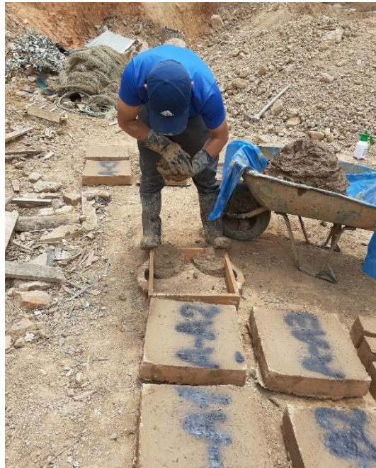
Llenado del molde de adobe según guía de elaboración.
