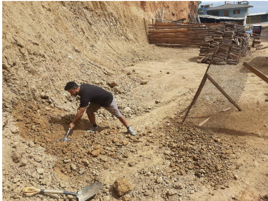
Tamizado de suelo para elaboración de adobes.
