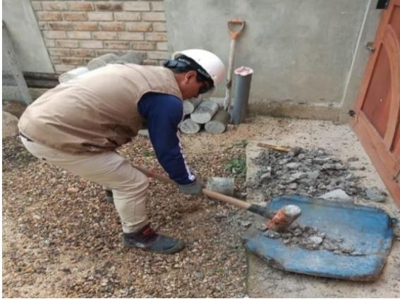
**FOTO 06:** Agregado reciclado después del proceso de trituración, proveniente de cerámica y concreto.
