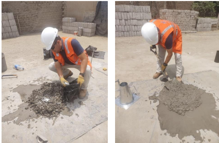
Ilustración 13. Preparación de mezcla de concreto
