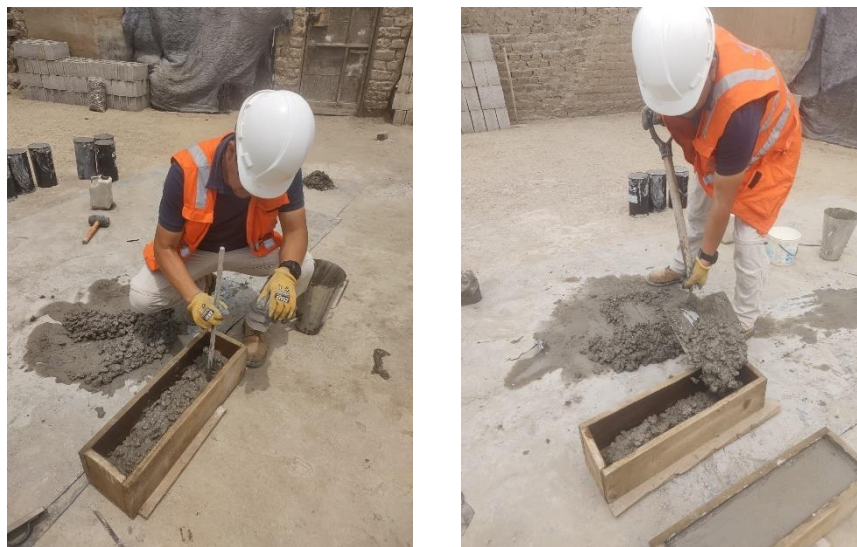
Ilustración 16. Preparación vigas prismáticas
