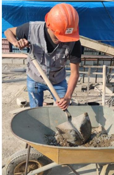
Fotografía 29. Realizando las mezclas en una carretilla – Elaboración de probetas.
