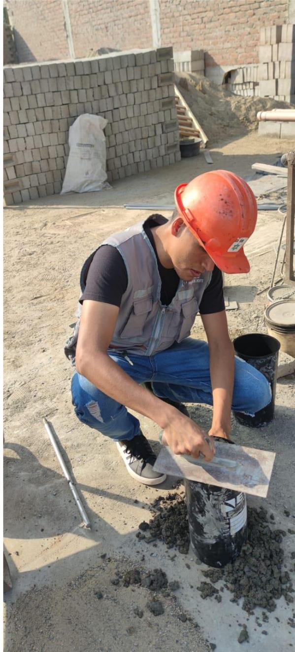
Fotografía 34. Frotachamos la mezcla – Elaboración de probetas.
