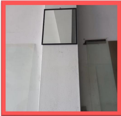
Figura 37 Señalizaciones y rótulos antes.
