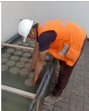
Foto 21: Curado de especímenes de concreto.
